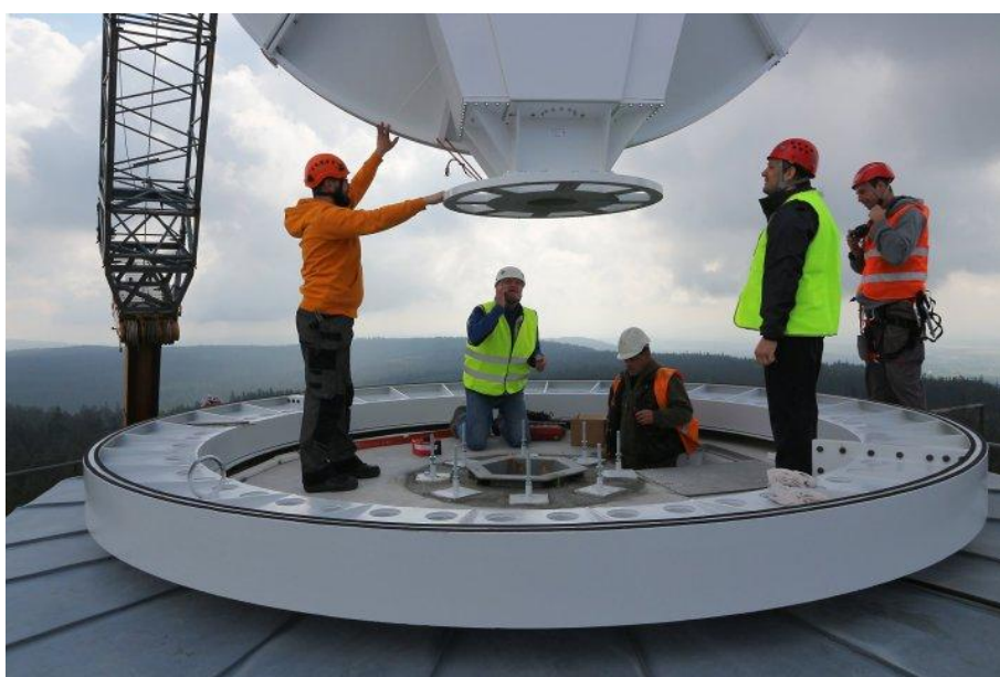
Instalace nové antény na radarovou věž (radar Brdy)
