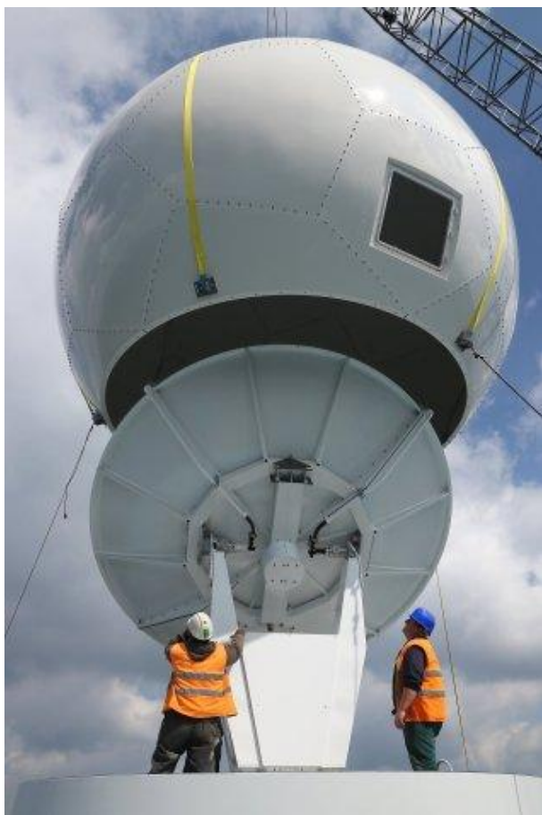
Instalace nové kopule antény na radarovou věž (radar Brdy)
