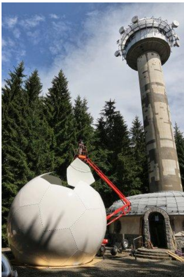
Sestavování nové kopule antény (radar Skalky)
