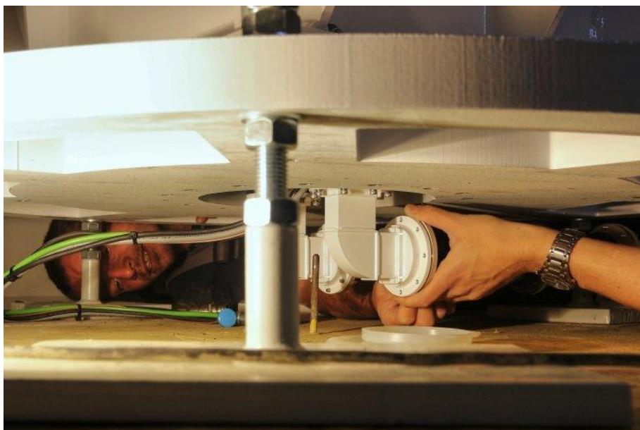
Sestavování vlnovodné trasy mezi anténou a radarovou skříní (radar Skalky)
