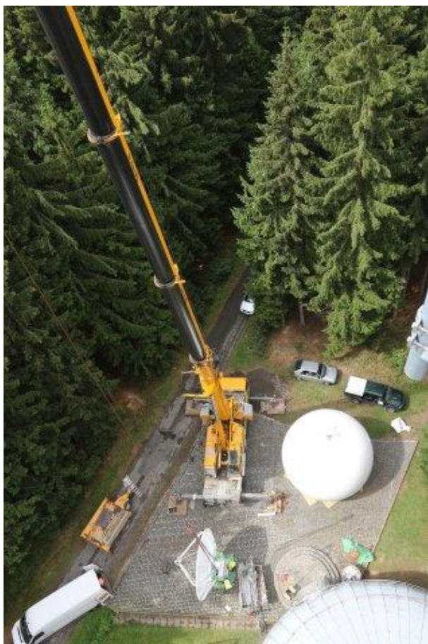
Vyzvedávání nové antény na radarovou věž (radar Skalky)
