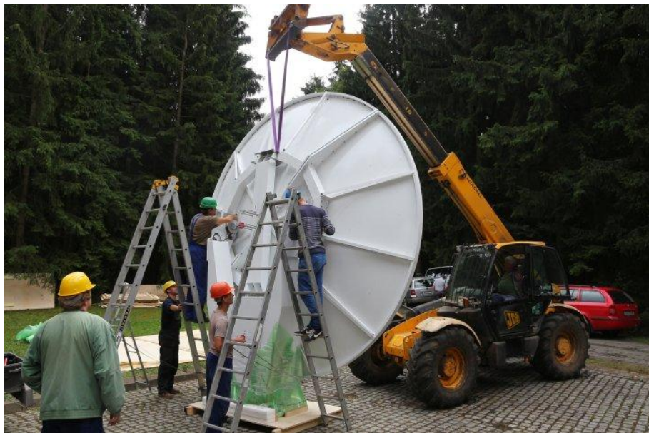
Sestavování antény a anténní mechaniky nového radaru (radar Skalky)
