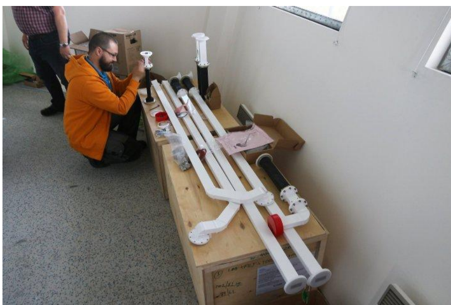
Sestavování vlnovodné trasy mezi anténou a radarovou skříní (radar Brdy)
