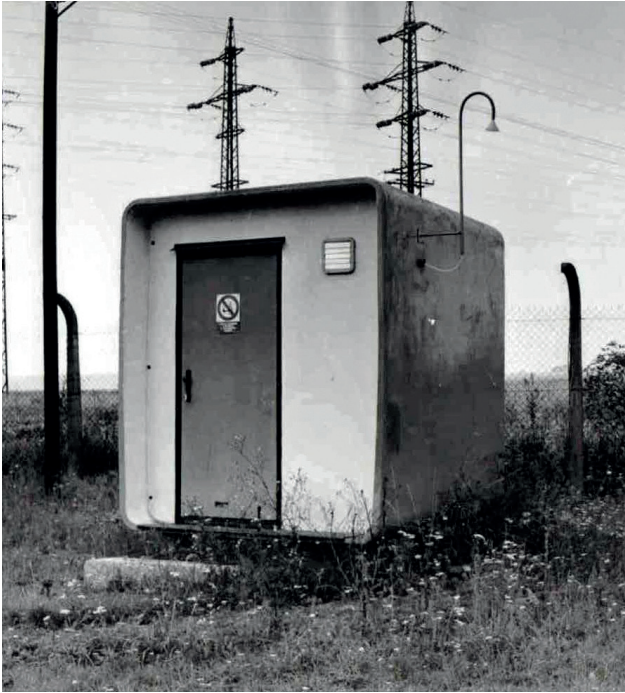
Obr. 14 Automatická monitorovací stanice umístěná v objektu staniční sítě Povodí Odry, 2. polovina 80. let 20. století (archiv ČHMÚ).
