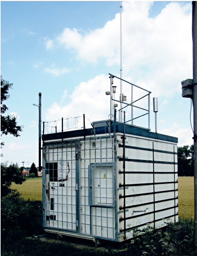
Obr. 43 Zabezpečená stanice AIM Věřňovice v létě 2013 (P. Smolík).
