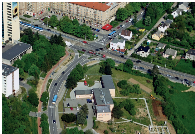
Obr. 2 Letecký pohled na pobočku ČHMÚ v Ostravě, K Myslivně 3/2181 v květnu 2013 (P. Lipina).
