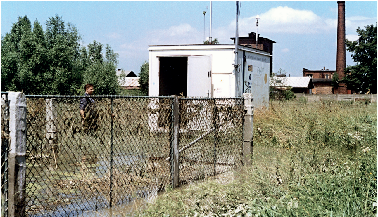
Obr. 37 Zaplavená stanice AIM Bohumín po příjezdu techniků v červenci 1997 (M. Nevrla).
