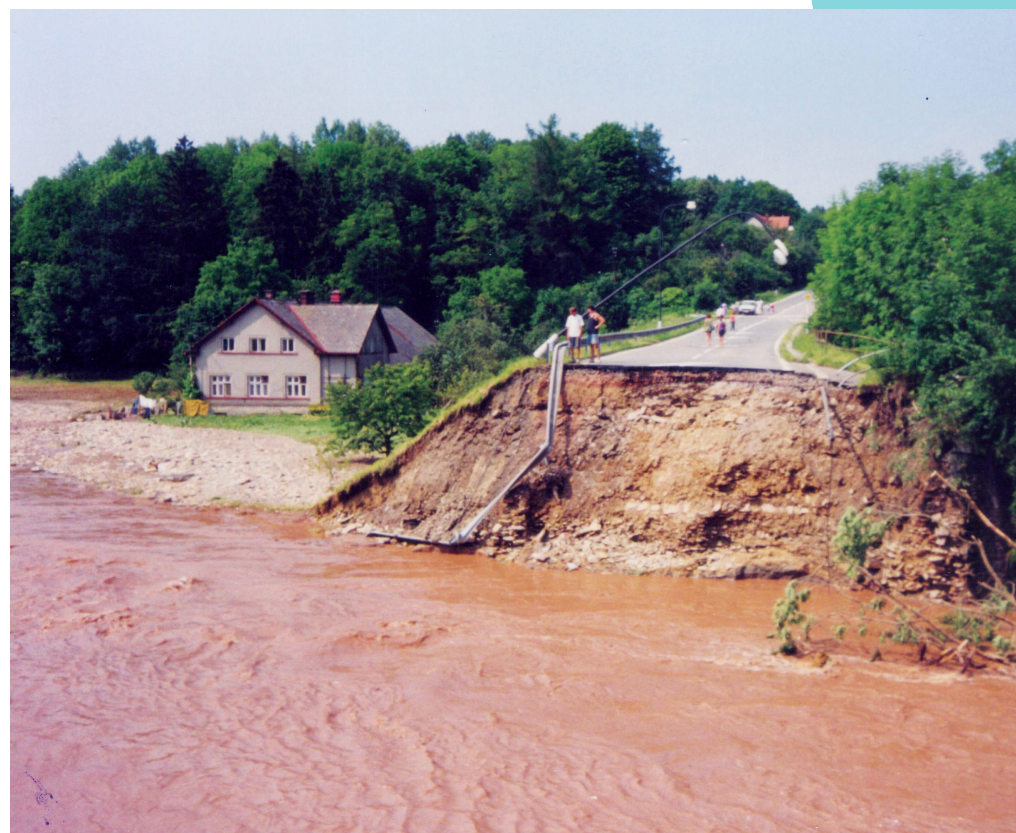
Stržený silniční most na Dědině v Cháborech.
