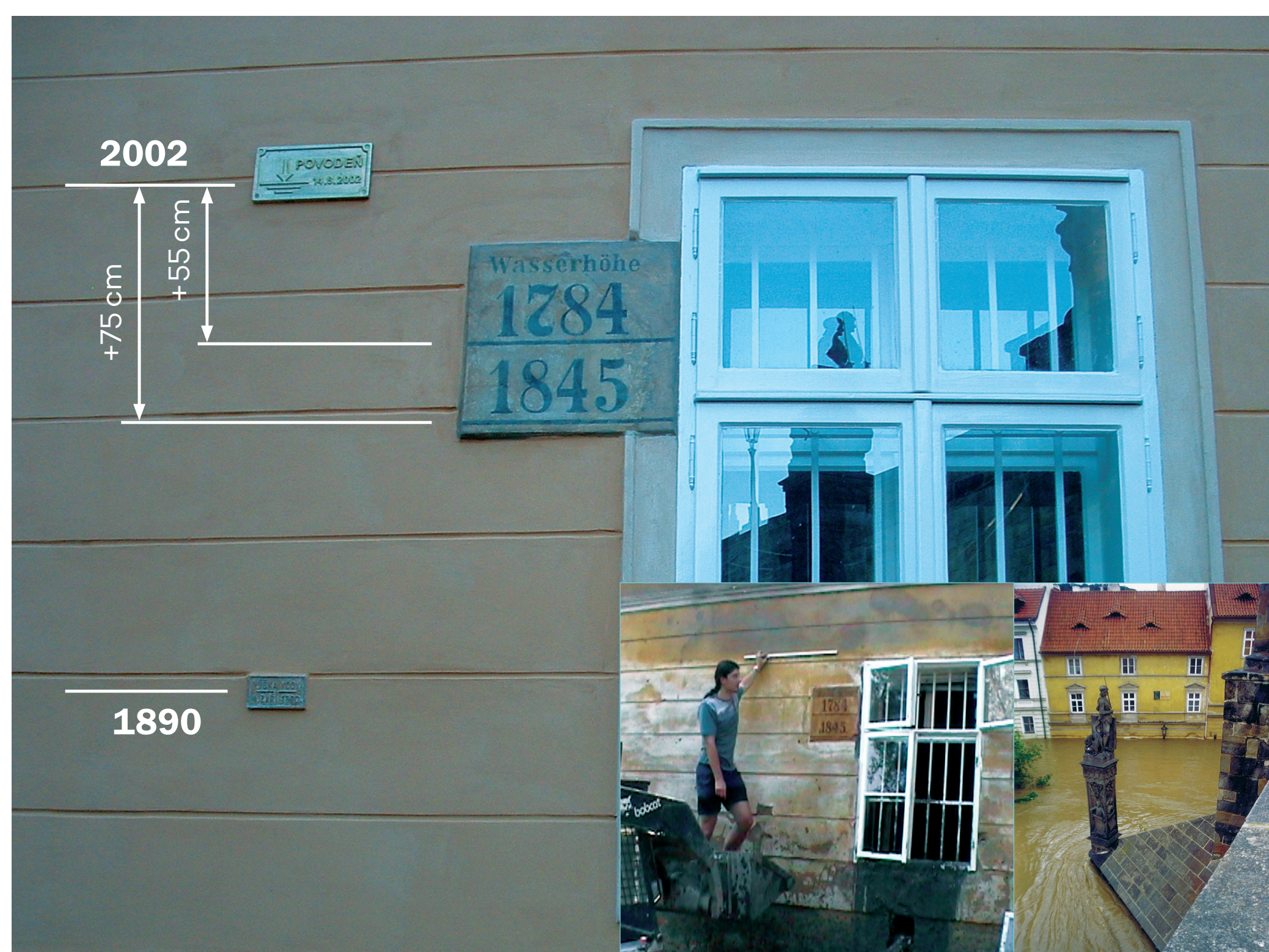
Porovnání s povodňovými značkami z let 1784, 1845 a 1890 na domě U obrázku Panny Marie pod Karlovým mostem.
