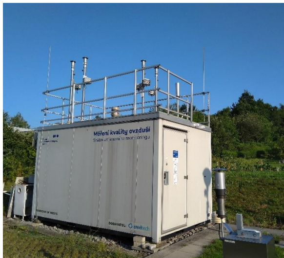
Obr. 6 Stanice AIM Ostrava-Poruba ČHMÚ (foto: P-ČHMÚ Ostrava)
