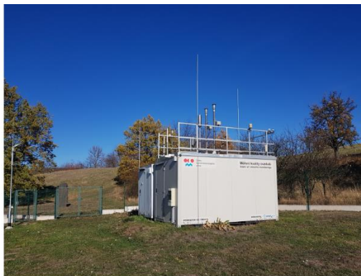
Fig. 6 Ústí nad Labem-Kočkov AIM station (photo: CHMI Regional Office in Ústí nad Labem)
