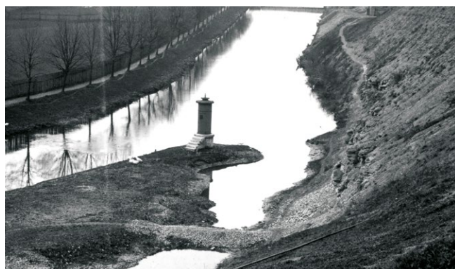
Obr. 13 Metuje v Krčíně, limnigraf osazen r. 1910, foto ca 1925. Zdroj: Archiv hydrologické služby ČHMÚ.
