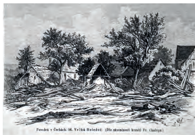
Obr. 8 Poničené domy v obci Holedeč na dokumentačním snímku. Zdroj: archiv Regionálního muzea K. A. Polánka v Žatci. Ilustrace z Holedeče od F. Chalupy. Zdroj: Světozor, č. 34, 23. 8. 1872, s. 404.
