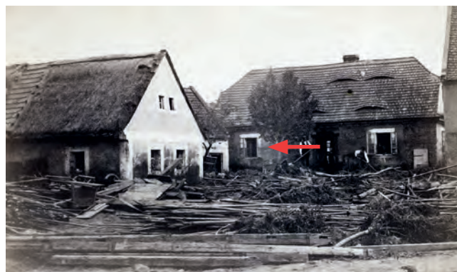
Obr. 4 Dům čp. 52 v Holedči po povodni r. 1872. Uprostřed rámu oken je patrná dosažená hladina vody. Dům stojí bez větších stavebních úprav dodnes. Obrazová dokumentace může být použita pro rekonstrukci nadmořské výšky hladiny v místě, kde jiné povodňové značky chybí. Zdroj: archiv Regionálního muzea K. A. Polánka v Žatci.
