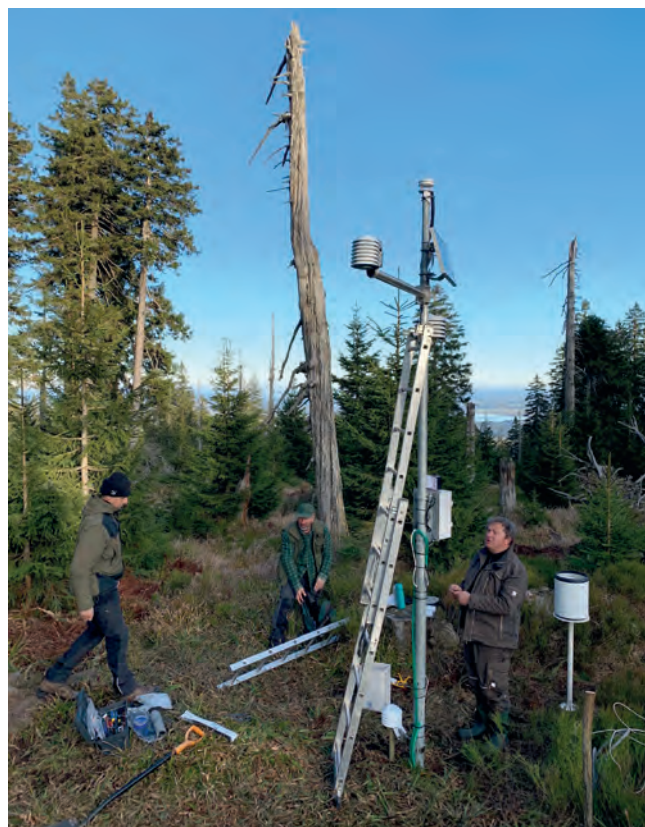
Rekonstrukce meteorologické stanice Smrčina v oblasti jihovýchodní Šumavy.
