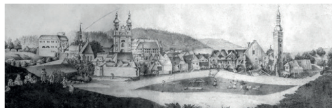
Obr. 3 Zničené opevnění a přilehlá část města Šternberka po katastrofální povodni řeky Sítka (povodí horní Moravy) 17. 8. 1789.
