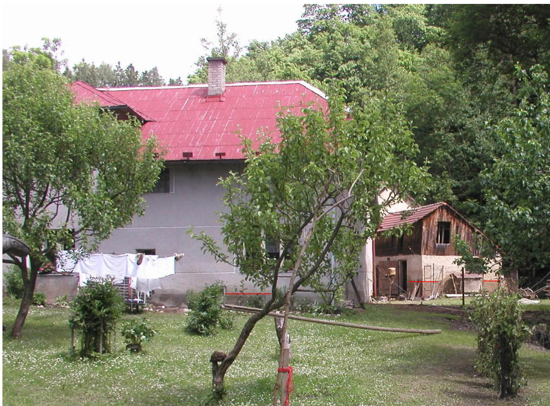
Obr. 10 – Stopy kulminační hladiny povodňové vlny na domku a kůlně (14.6.2004 11:00)
