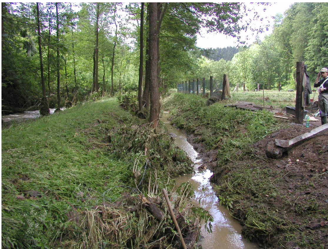
Obr. 8 – Odpadní koryto od nádrží pstruhové sádky (pohled po vodě)
