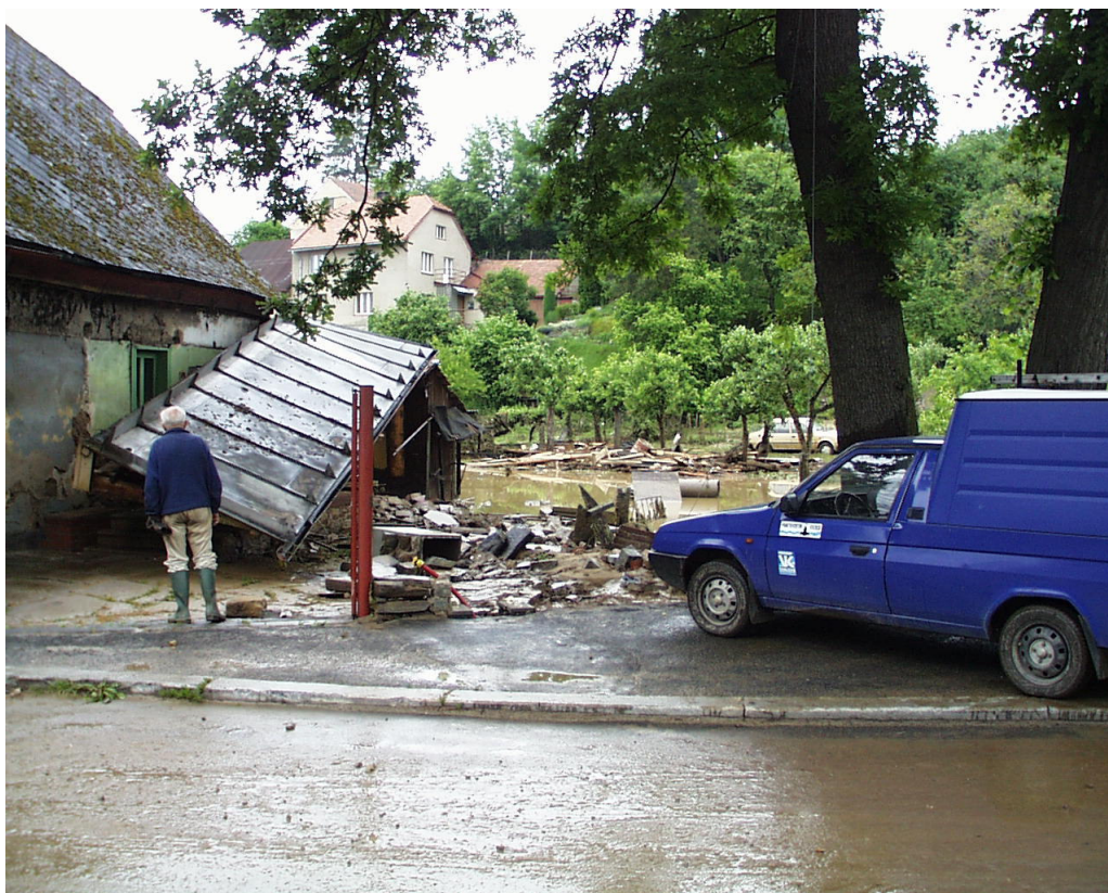
Obr. 14 – Ledec nad Sázavou 11.6.2004 v 9:20, povodňové škody
