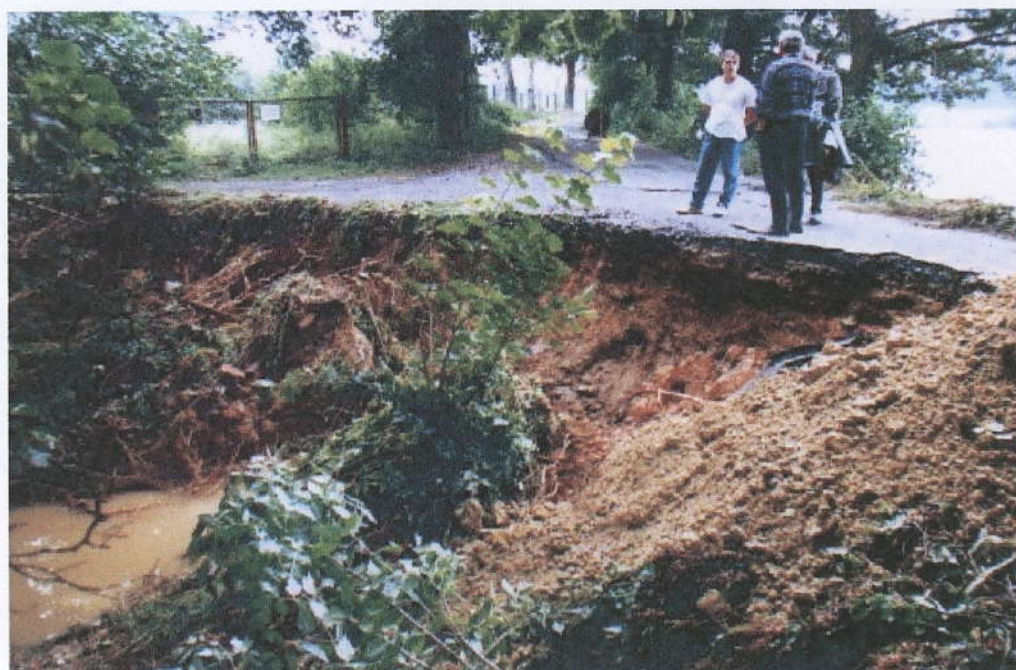
Prostřední stoka rozlitá na třeboňských loukách Přelitím narušená hráz Benátského rybníka u obce Libín
