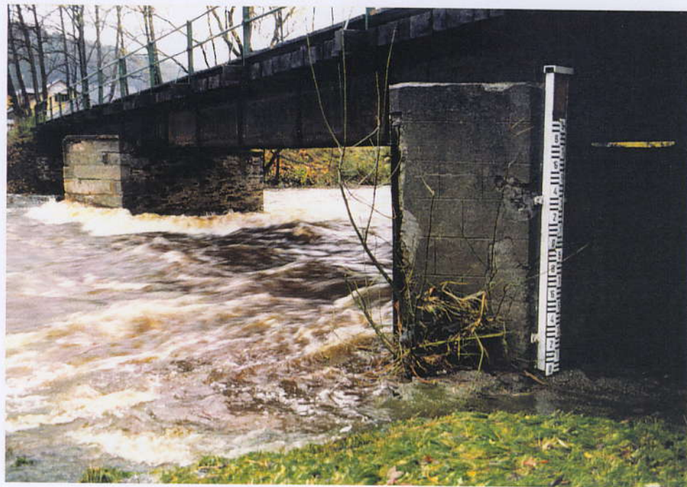
povodňový vodočet na mostu v Rejštejné při stavu 187 cm na limnigrafu, 187 m 3 /sec, 29.10.1998 ve 12.30
