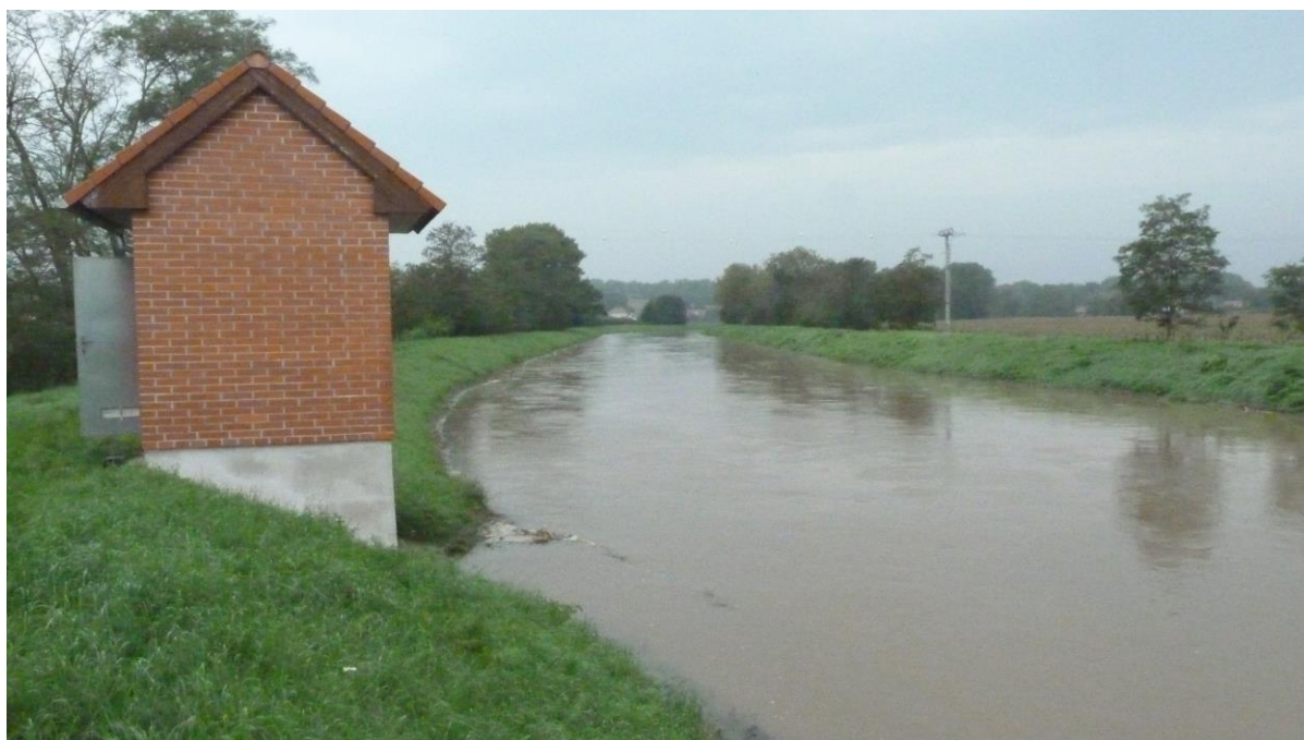
Obr. 7 Vodoměrná stanice Božice – Jevišovka 15.9.2014
