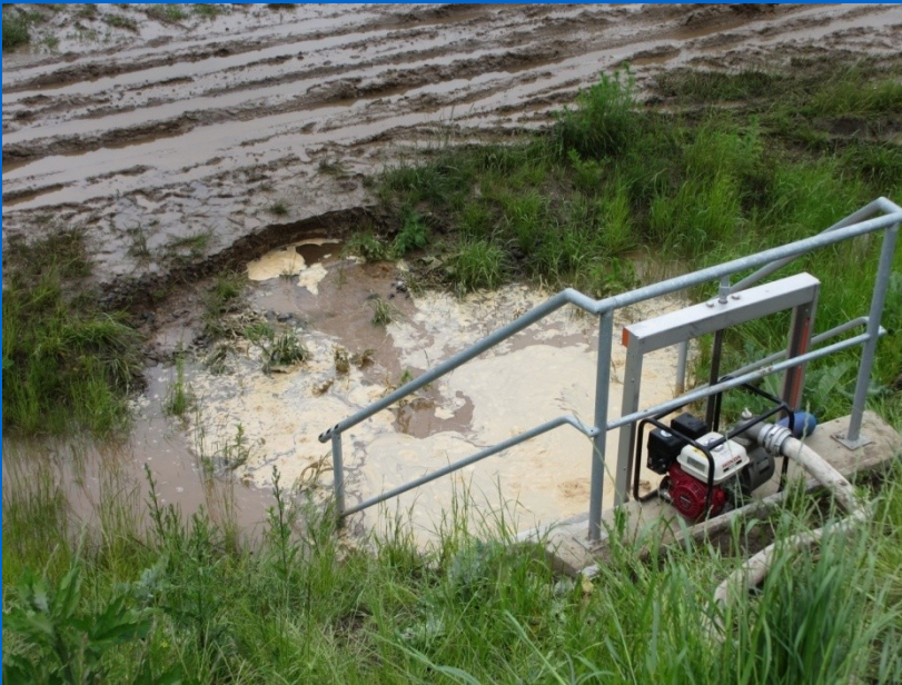
Čerpání průsakové vody
