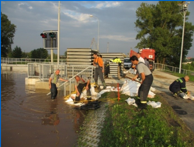
Provizorní sanace v napojení konstrukcí před kulminací
