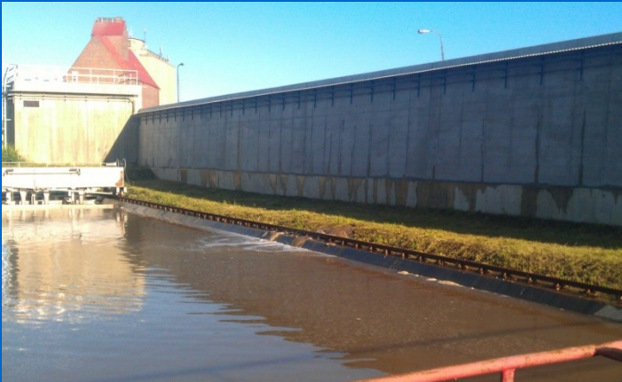
Průsaky otvorem v podzemním těsnícím prvku
