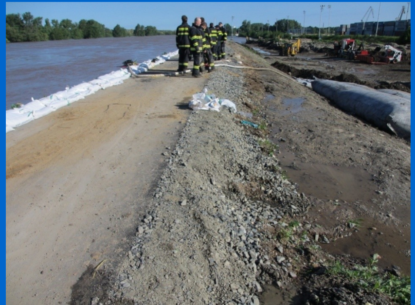
Čerpání průsakové vody
