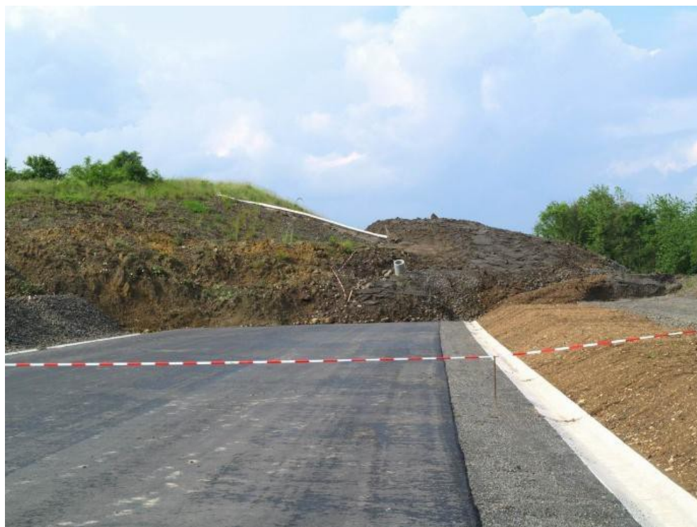
Akumulace sesuvu na dálničním tělese D8
