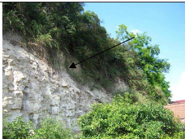
Foto 269: Pohled na skalní výchozy nad rodinným domem č. p. 201. Šipka znázorňuje místo litologického rozhraní mezi svrchnokřídovými vápnitými pískovci a svahovými sedimenty v nadloží.
