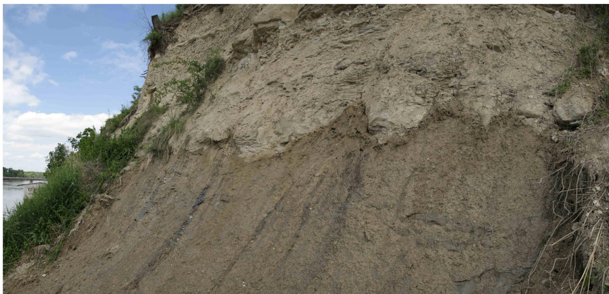
Foto 252: Bližší pohled na litologické rozhraní s vývěry podzemní vody
