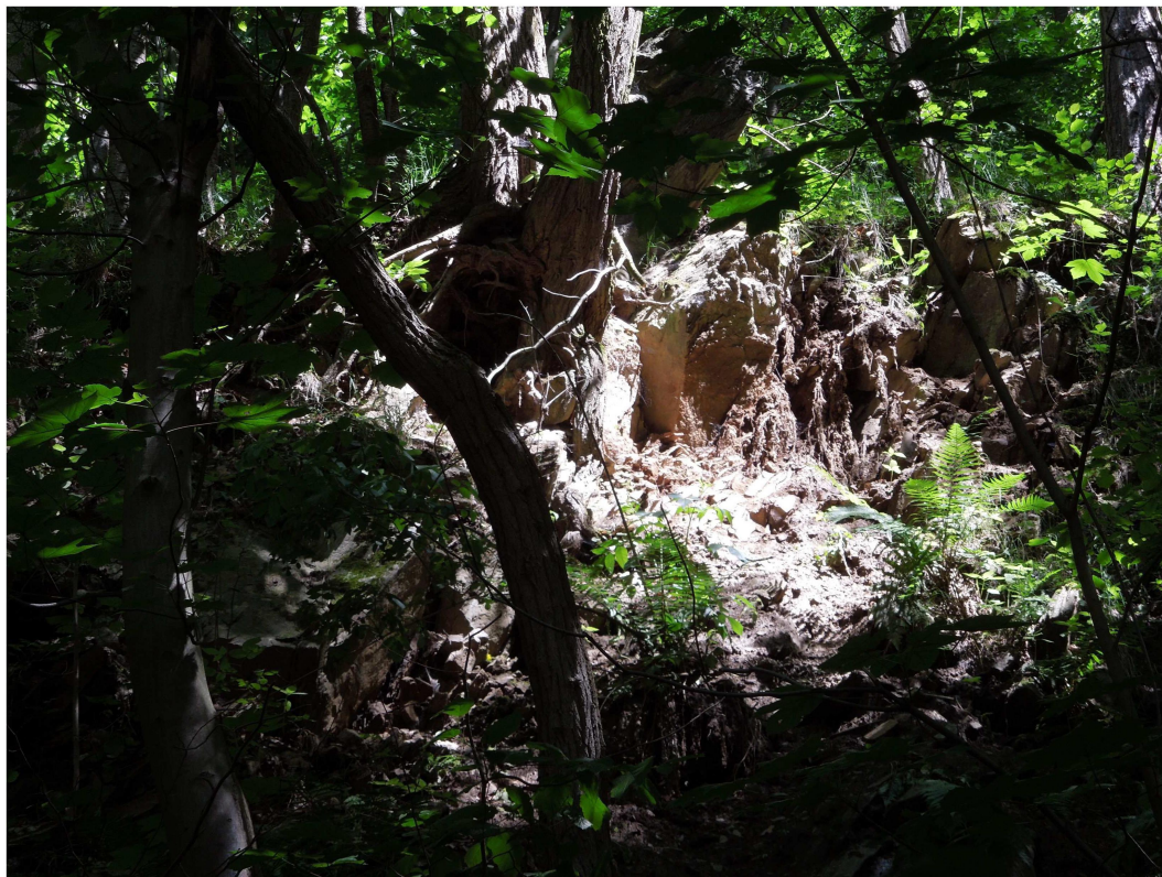
Foto 210: Stromy vyrůstající z vrcholové partie skal v bezprostřední blízkosti cesty způsobují odlamování bloků a jejich pád
