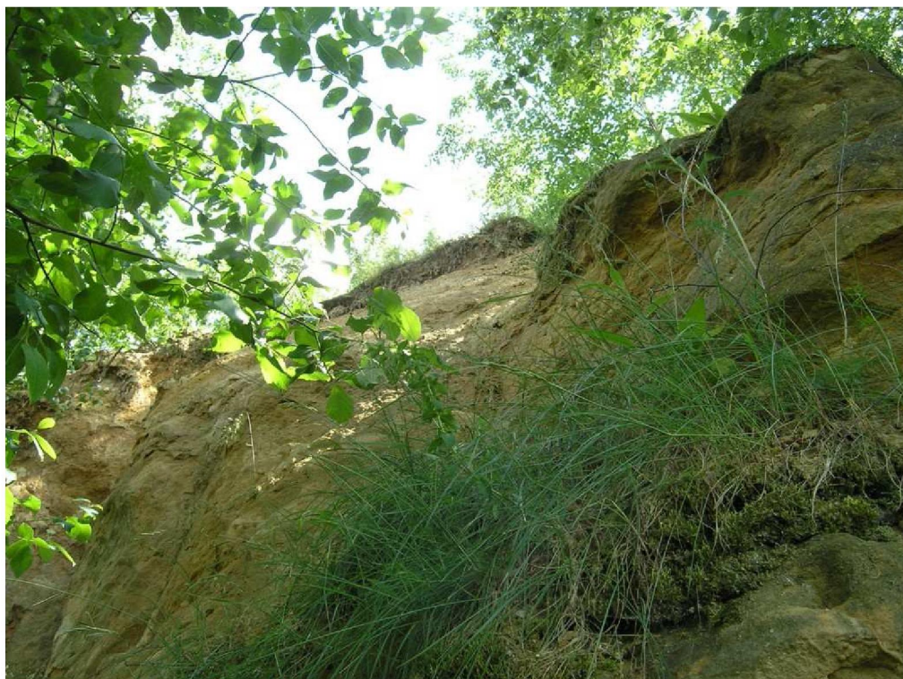
Foto 282: Pohled na pískovcovou stěnu, s travinami a náletovými dřevinami.
