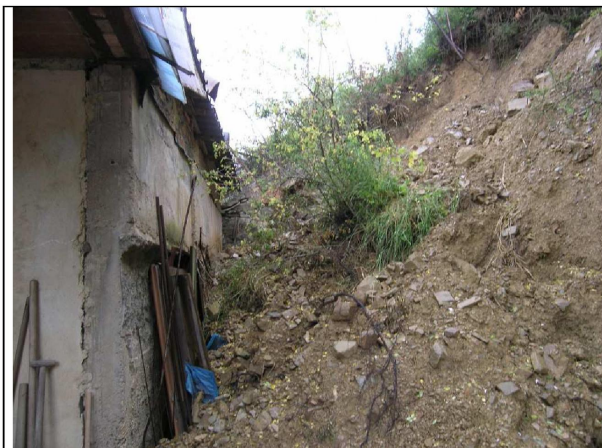
Foto 240: Akumulace horninových hmot za RD.
