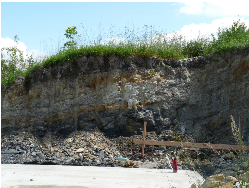
Foto 244: Ve stěně zářezu stavební parcely vystupují fylitické břidlice neoproterozoika s organickou příměsí a s úklony téměř paralelními se sklonem svahu
