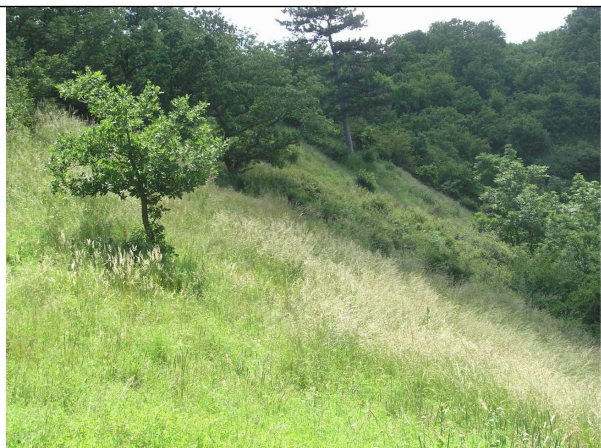
Foto 235: Pohled na sesuvný svah pod turistickou stezkou (viz strom), svahové deformace schované v trávě.
