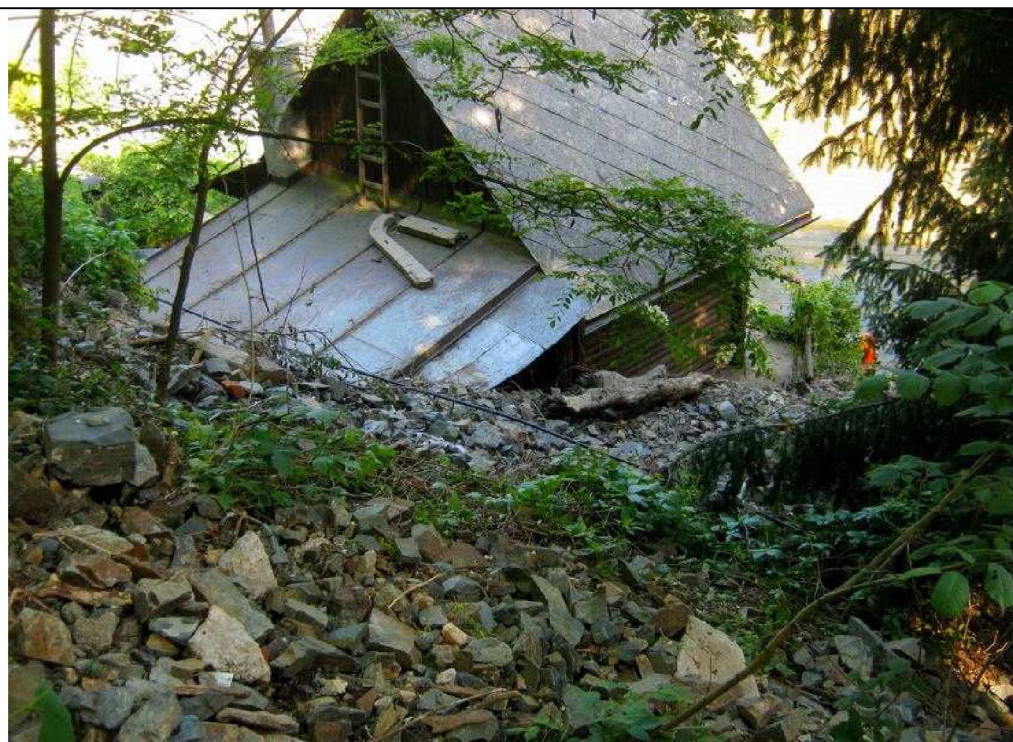
Foto 255: Kamenitá až balvanitá akumulace proudu sesuvu v jeho dolní části ohrožující rekreační objekty.
