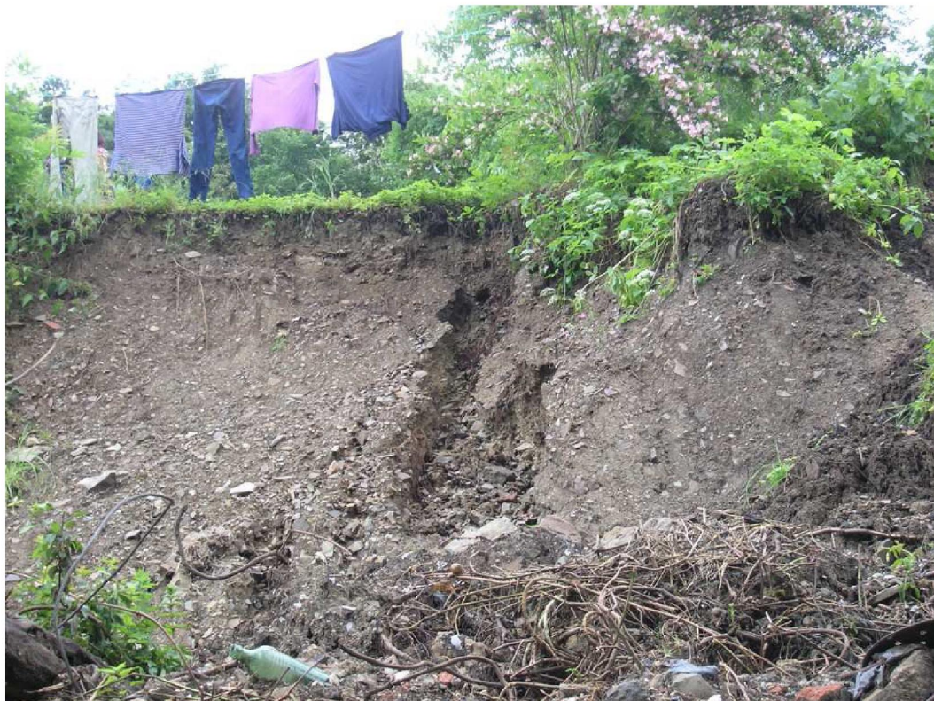
Foto 222: Odlučná stěna s erozní rýhou
