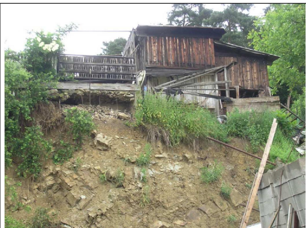
Foto 241: Východní část území s potenciálně nestabilními objekty na horní hraně svahu.
