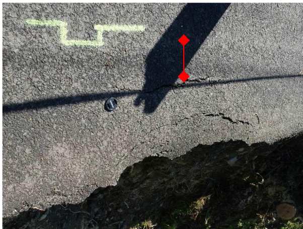
Foto 158: Zátrhy v asfaltu probíhají cca 15 cm od vyznačeného plynovodu
