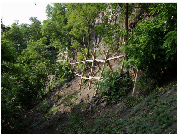
Foto 204: Profil svahem – ve spodní části osypy a suťové kužele, uprostřed ochranné sítě a vpravo již kolmé výchozy vulkanických hornin
