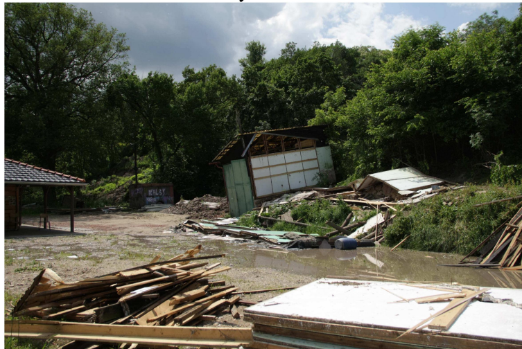
Foto 171: Čelo sesuvu. Svahová deformace zdemolovala společenský objekt místního mysliveckého sdružení.
