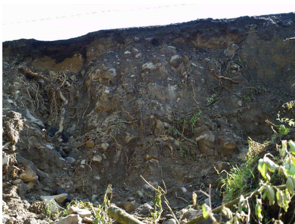
Foto 160: Materiálové složení svahu v odlučné stěně (čelo staré svahové deformace)
