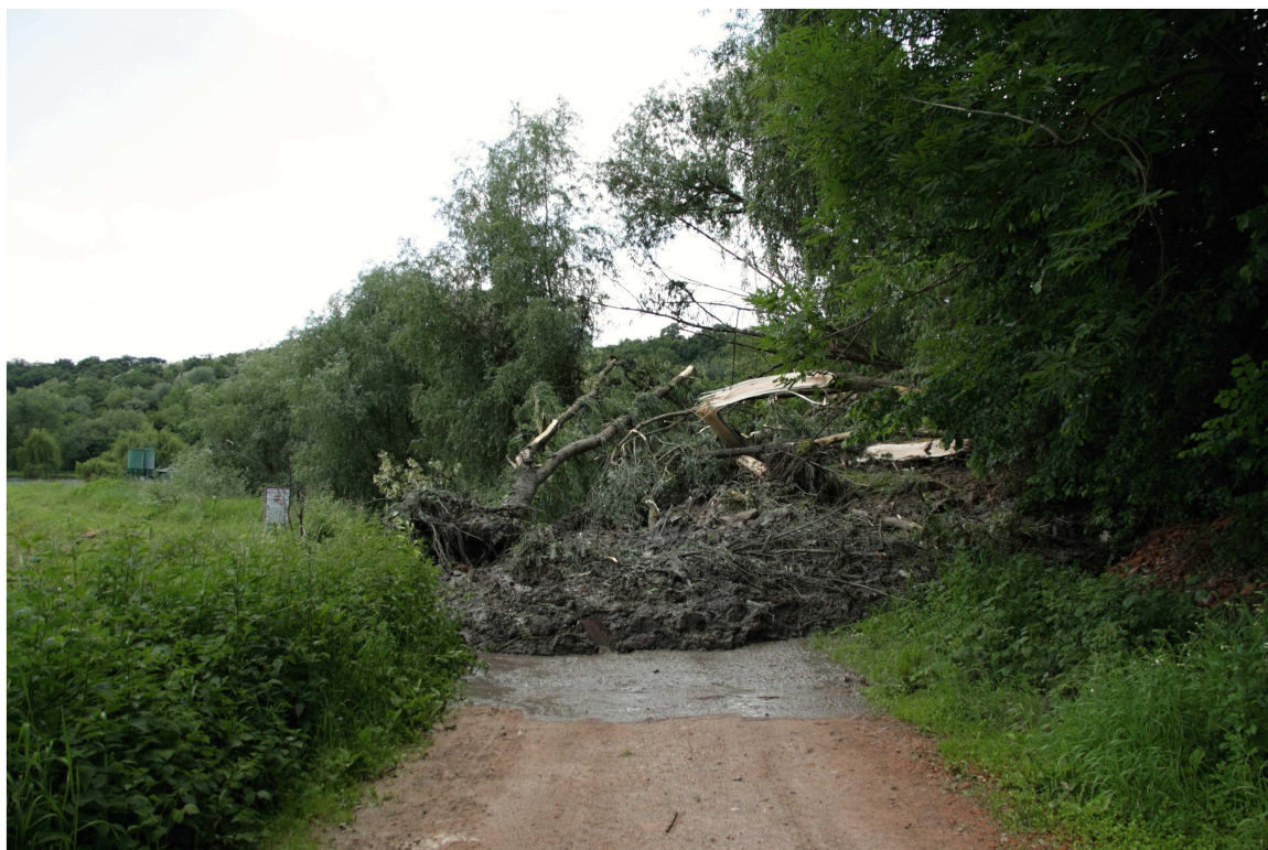
Foto 174: Čelo proudového sesuvu sesutého z erozní rýhy od pramenného vývěru
