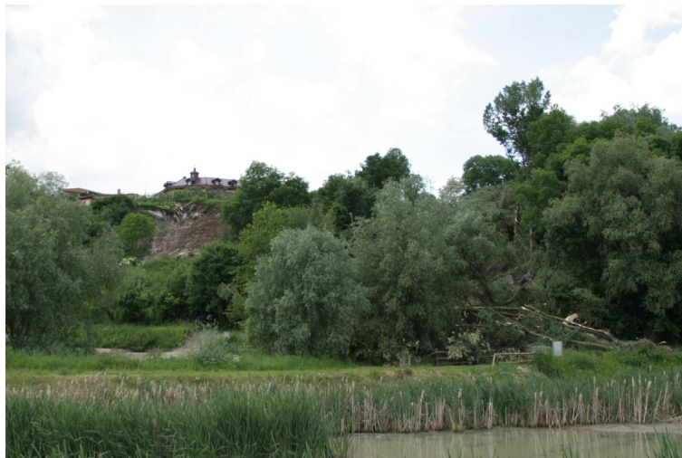
Foto 172: Vzdálený pohled na postižený svah pod domem č.p. 125. V pravé části jsou povalené stromy na čele proudového sesuvu.
