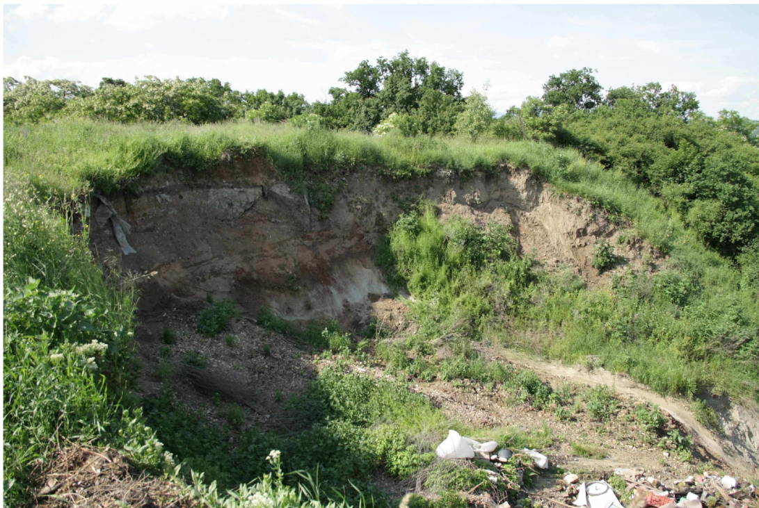
Foto 178: Pohled k severu. Ve spodní části obnažené podložní sedimenty střední části mosteckého souvrství. Pokryvné útvary tvoří šterky a písky a antropogenní navážky odpadu
