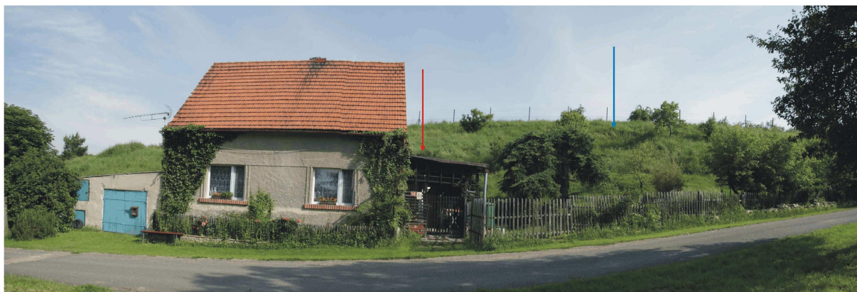
Foto 154: Čelní pohled k severu na dům č.p. 28. Za pravou přístavbou (červená šipka) se nachází hlášená svahová deformace. Modrá šipka ukazuje na obdobný jev mělkého plošného sesouvání (viz foto )
