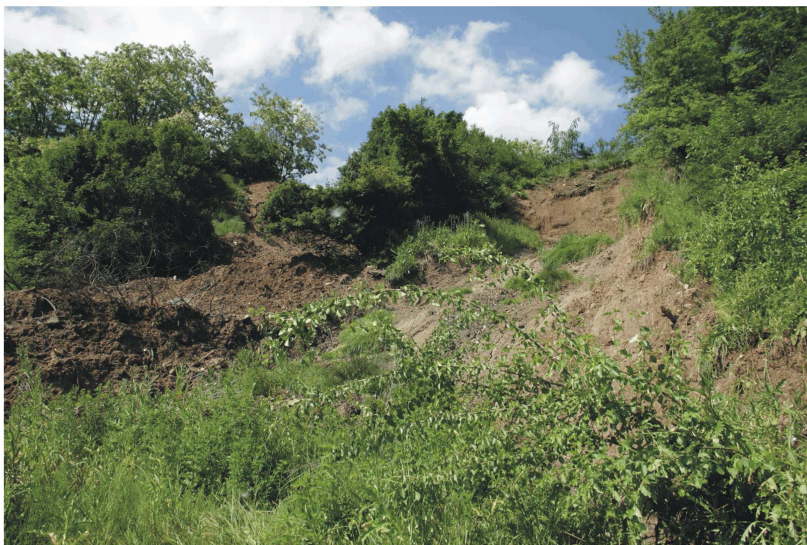
Foto 195: Pohled ze spojené akumulční části k dvěma odlučným stěnám
