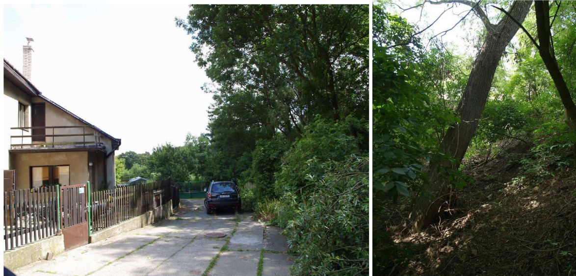
Foto 206: Celkový pohled na popisovanou situaci, vpravo stromy doporučené ke kácení, vlevo ohrožený dům č.p. 7
