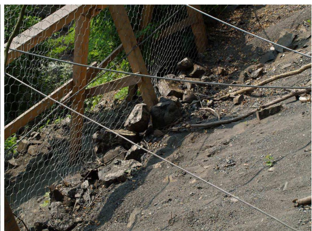
Foto 204: Profil svahem – ve spodní části osypy a suťové kužele, uprostřed ochranné sítě a vpravo již kolmé výchozy vulkanických hornin
