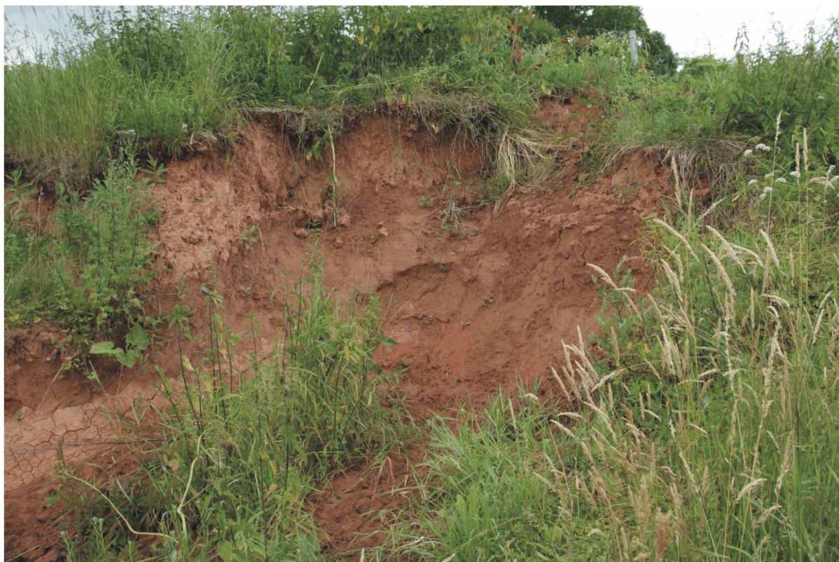
Foto 191: Část odlučné stěny mocné okolo 1,5 m
