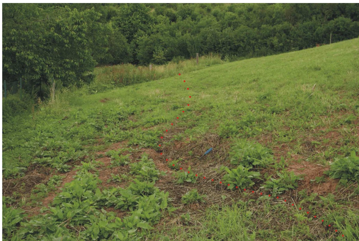
Foto 193: Tečkovaná čára kopíruje tahovou trhlinu pokračující ze sesuvu ohrožující dům č.p. 72. Foceno z jižního okraje zahrady.
