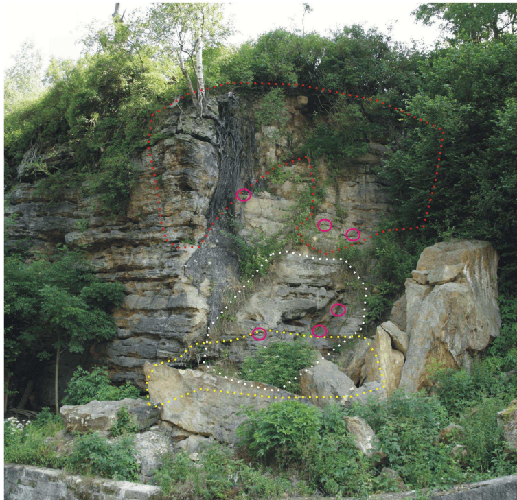
Foto 150: Čelní pohled na odlučné plochy a zřícené bloky. Červená tečkovaná linie zvýrazňuje skalní objekty, které je vhodné dotěžit a zároveň jsou nejrizikovějšími částmi skalního výchozu při ponechání a rozpojování zřícených bloků pod nimi. Bílá tečkovaná linie omezuje skalní objekt, který je vhodné ve skalní stěně ponechat a podezdít (viz dále). Žlutá tečkovaná linie vymezuje část, kde je vhodné patu stěny zpevnit podezdívkou. Červené kroužky naznačují příklady míst instalace dilatometrických sklíček měření)
