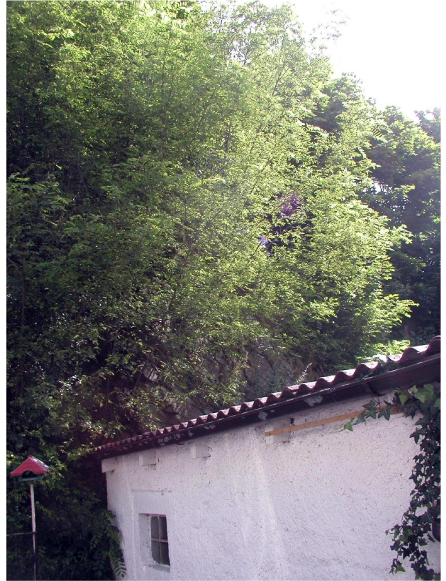
Foto 142: Rozrušená skála v kontaktu s přilehlou nemovitostí.
