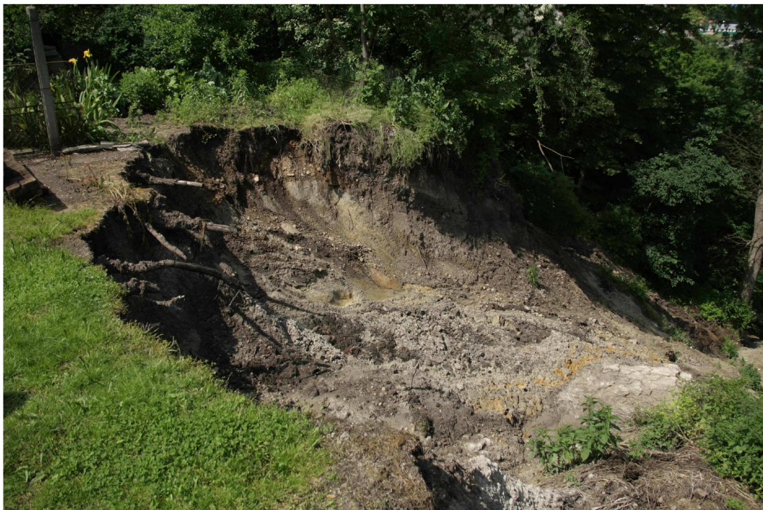
Foto 184: Pohled k severu na odlučnou stěnu
