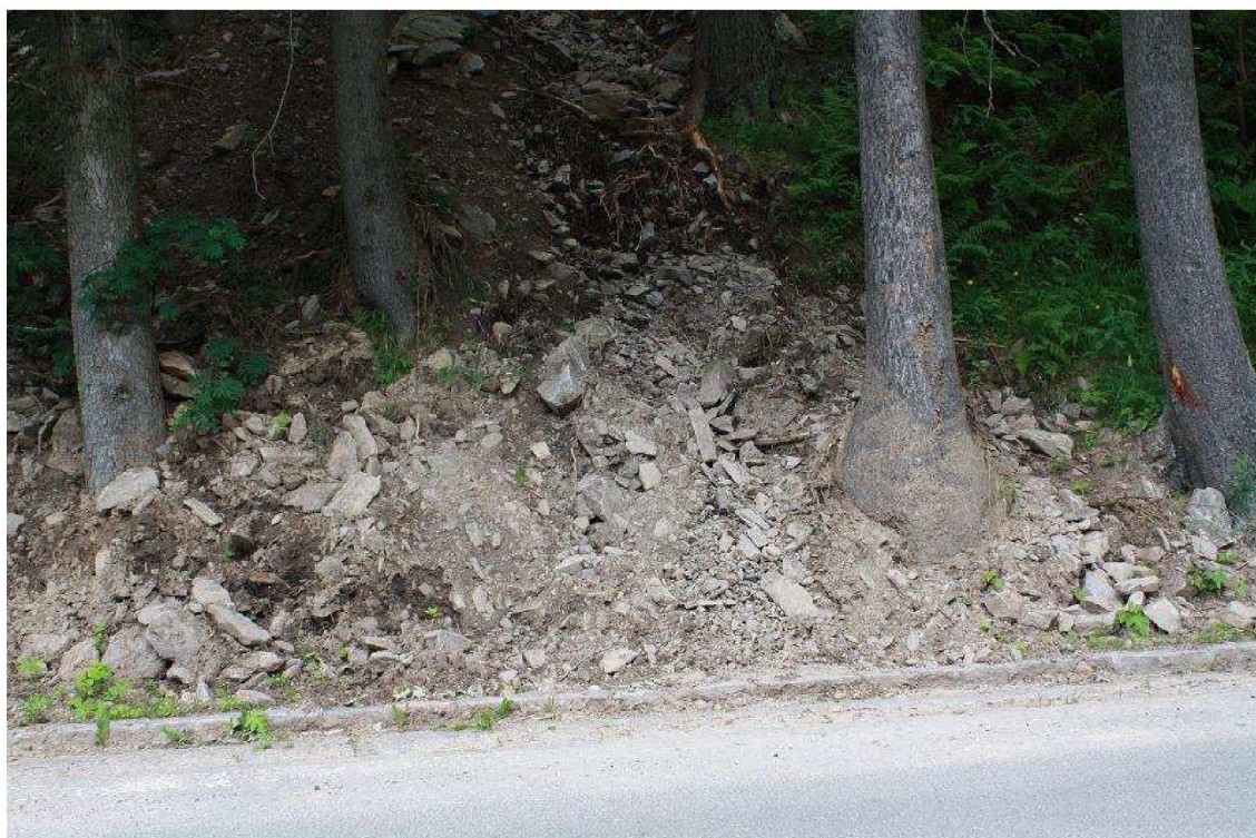
Foto 109: Pohled na čelo sesuvu (materiál z větší části odtěžen technikou)
