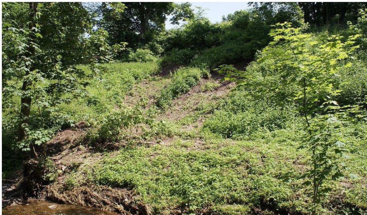
Foto 100: Čelní pohled na sesuv
