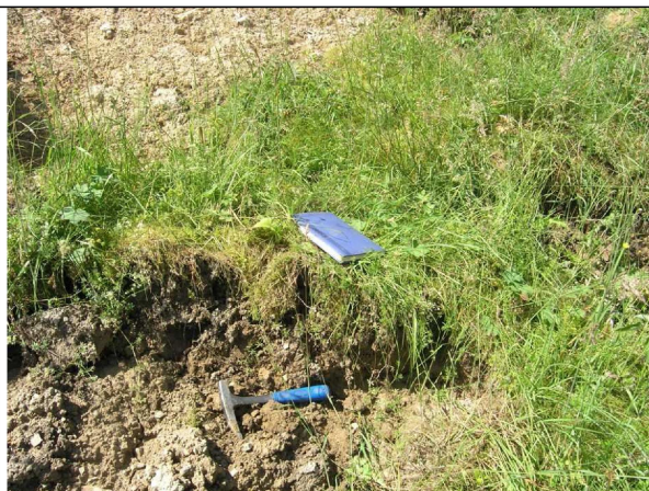
Foto 55: Akumulované sesuté hmoty při patě sesuvu A.
