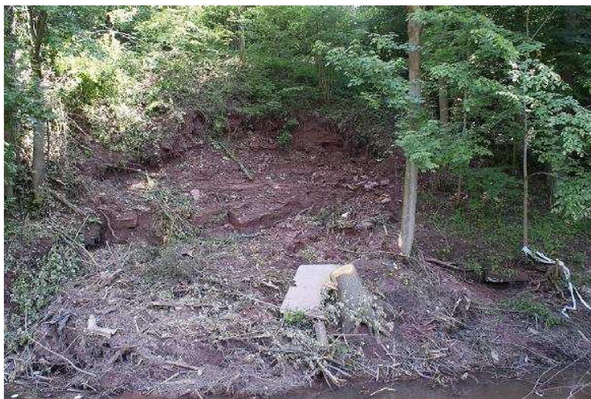
Foto 38: Čelní pohled na sesuv
