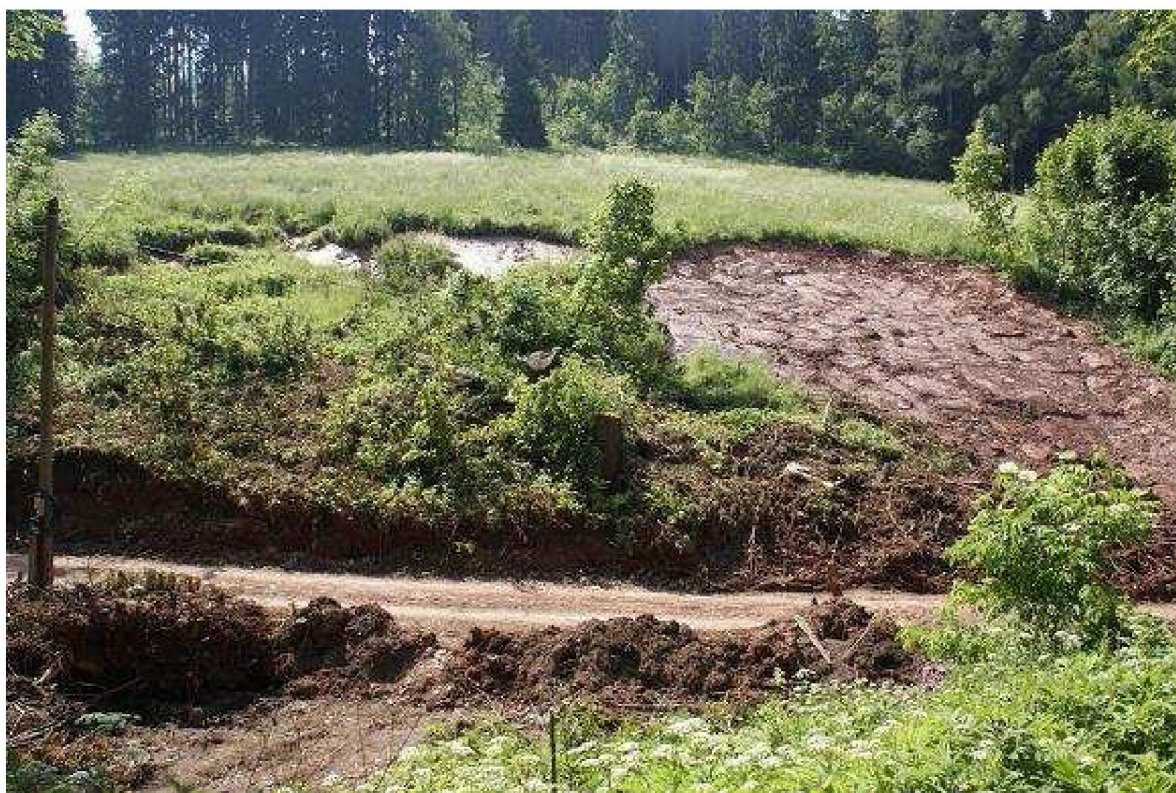
Foto 65: Čelní pohled na sesuv
