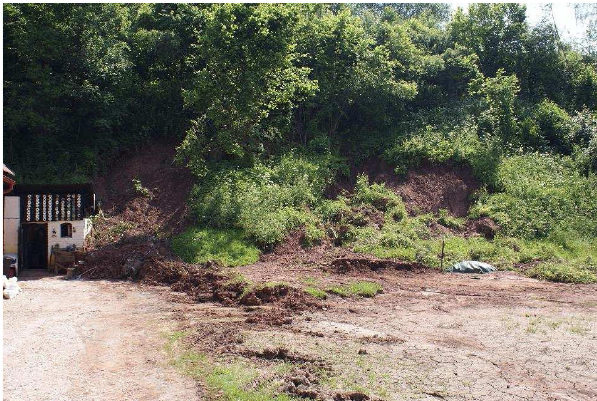
Foto 125: Celková situace sesuvů na p.p.č. 49 v k.ú. Arnultovice u obytného domu č.p. 40
