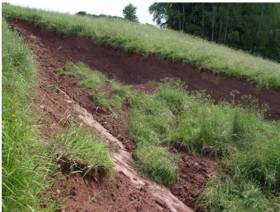
Foto 63: Odlučná trojúhelníková oblast o výšce stěny 2 m.
