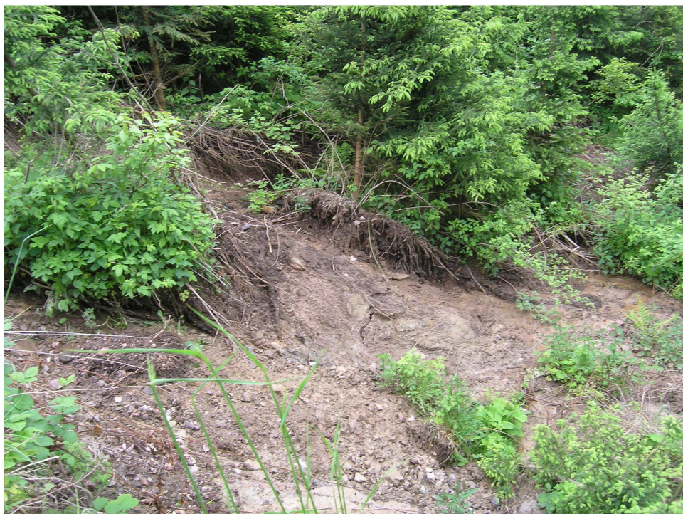
Foto 61: Boční svah, odkrytý sesunutím kvartérního pokryvu
