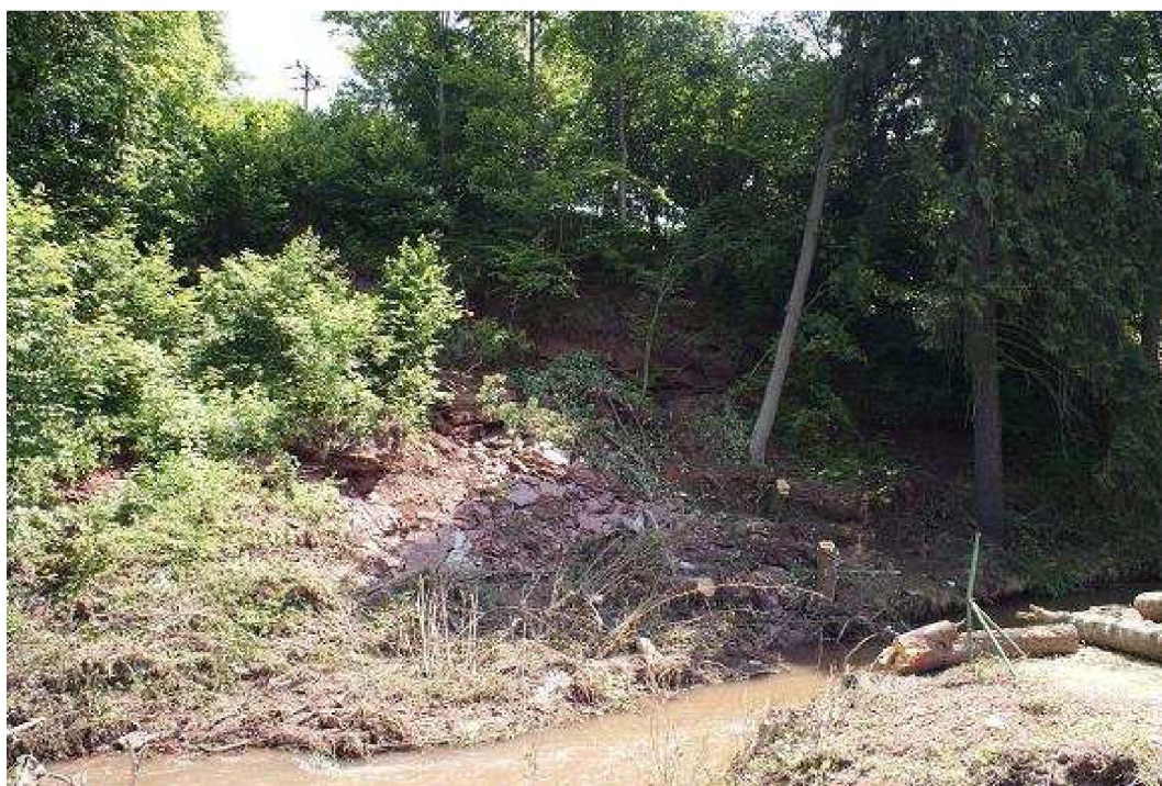
Foto 39: Čelní pohled na sesuv
