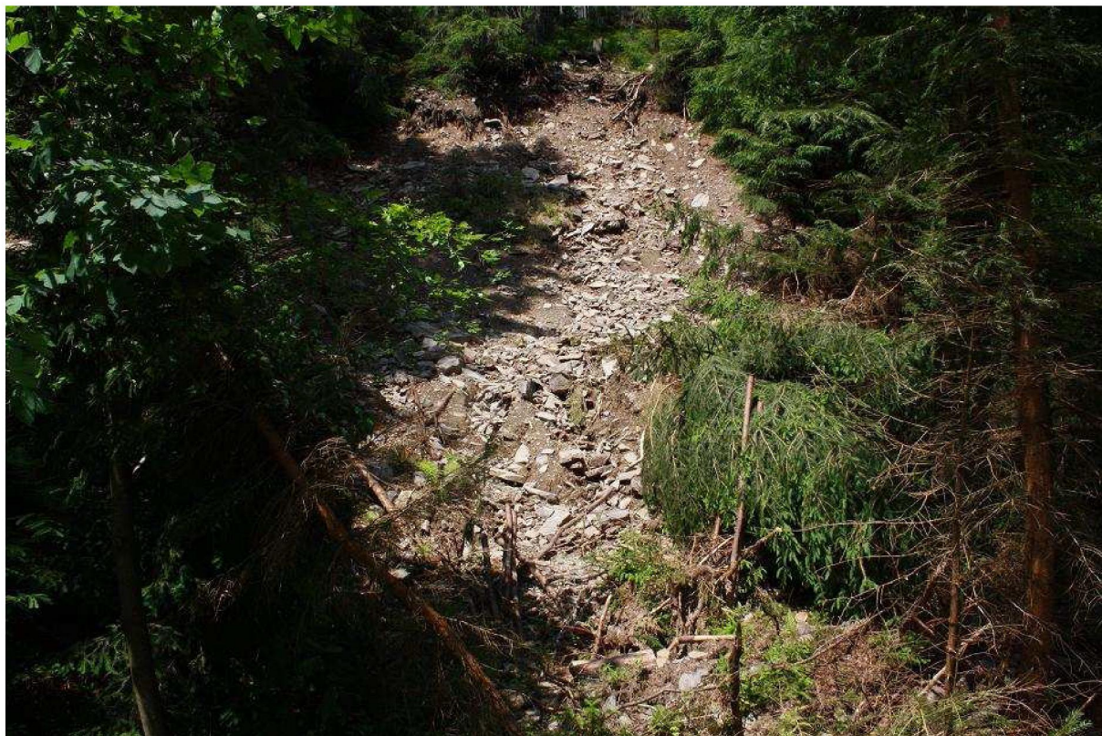
Foto 131: Celkový pohled na sesuv
