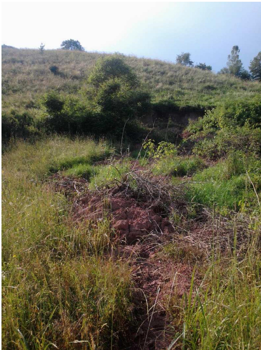
Foto 123: Čelní pohled na sesuv
