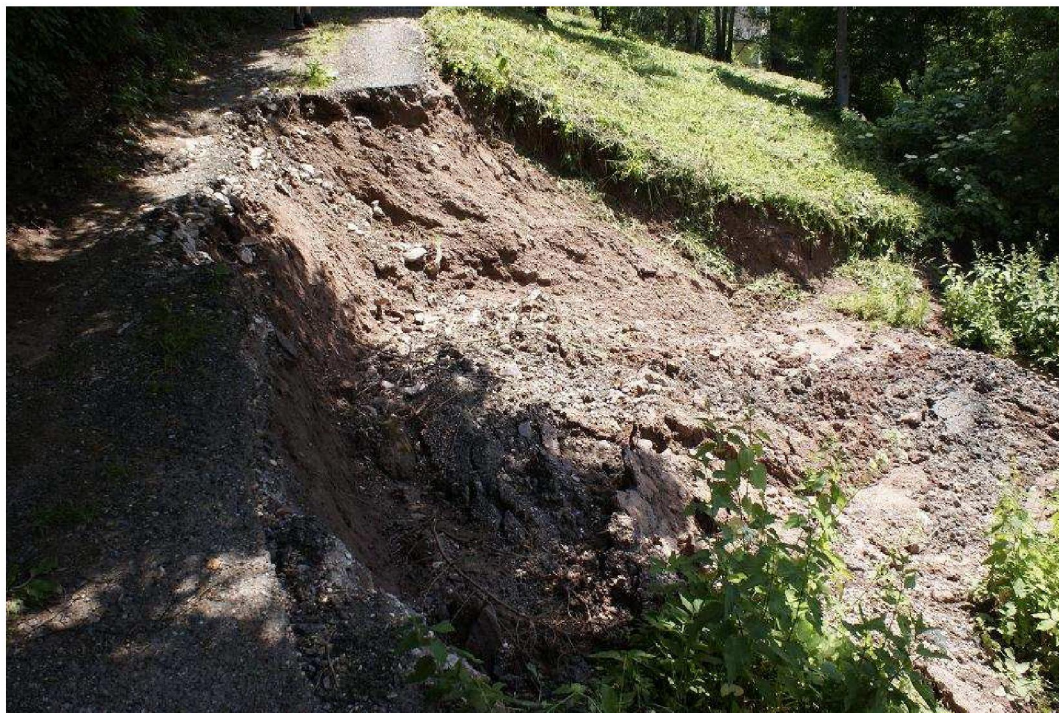
Foto 74: Odlučný prostor sesuvu s poškozenou komunikací
