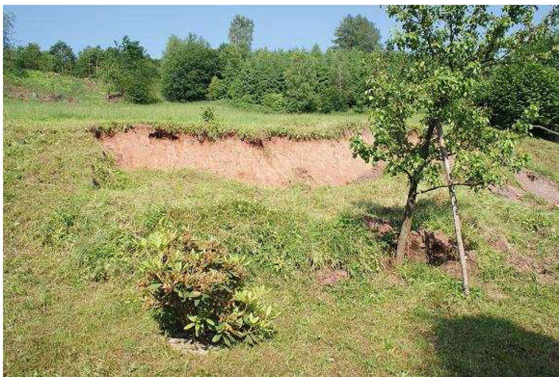
Foto 48: Čelní pohled na sesuv
