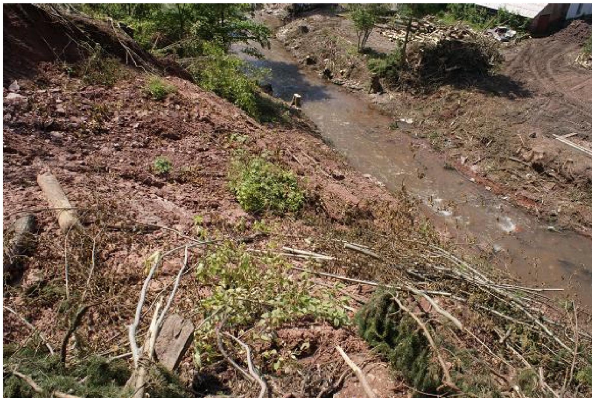
Foto 45: Transportní a akumulční oblast sesuvu (čelo sesuvu odtěženo technikou)
