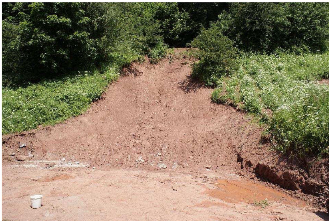
Foto 77: Čelní pohled na sesuv
