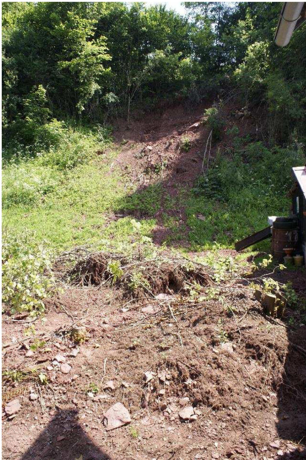
Foto 129: Čelní pohled na sesuv
