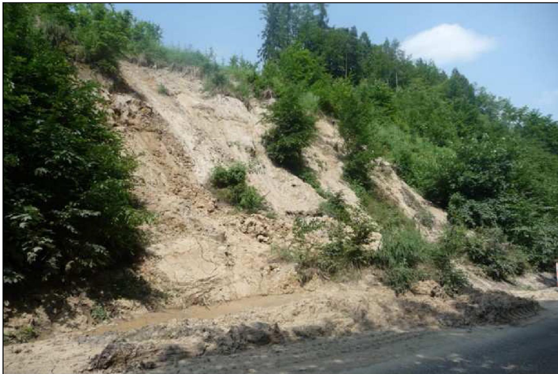
Foto 24: Celkový pohled na sesuv
