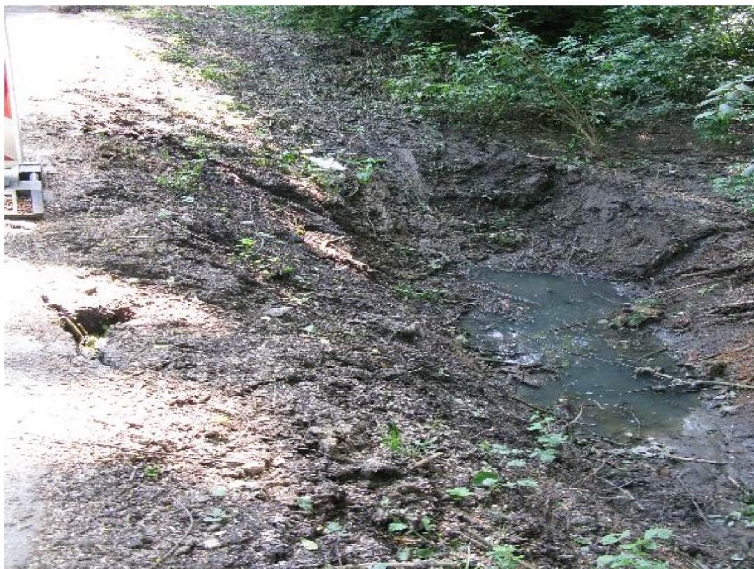
Foto 8: detail trativodu komunikace III/10564
