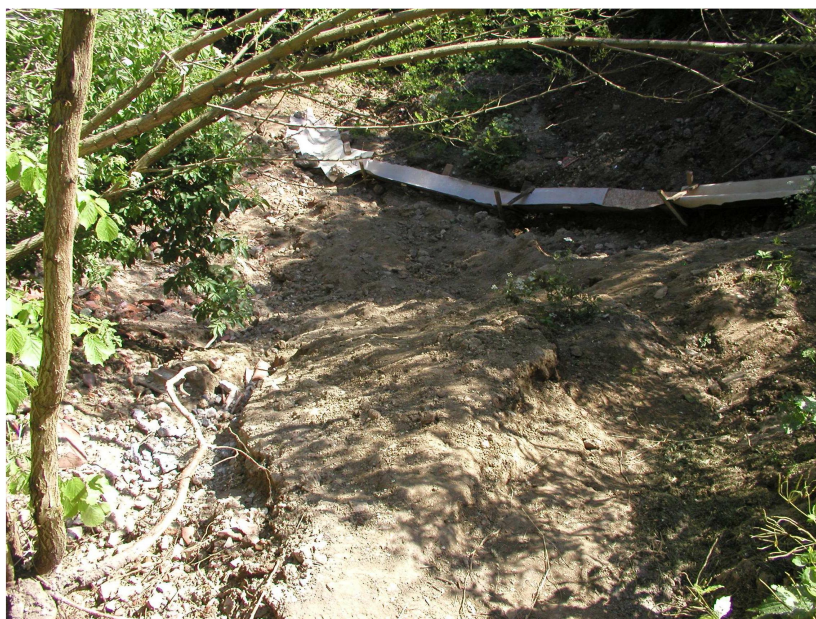
Foto 13: Horní část sesuvu těsně pod zdí kláštera
