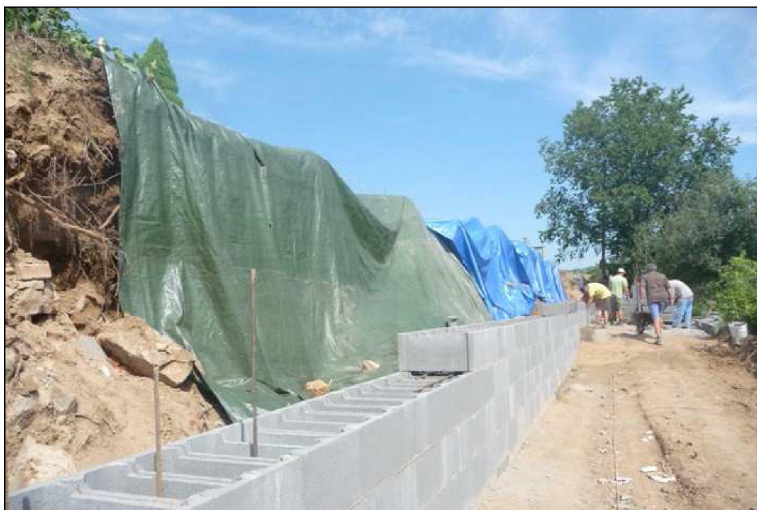
Foto 32: Nově budovaná opěrná zeď
