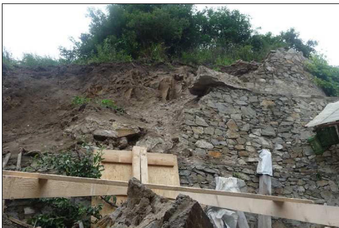
Foto 37: Provizorní zabezpečení opěrné zdi
