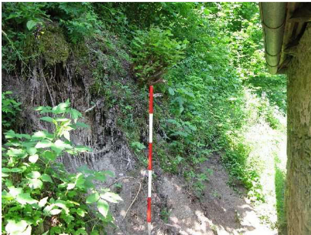
Foto 5: svah v těsném sousedství budovy č. p. 18, celková situace
