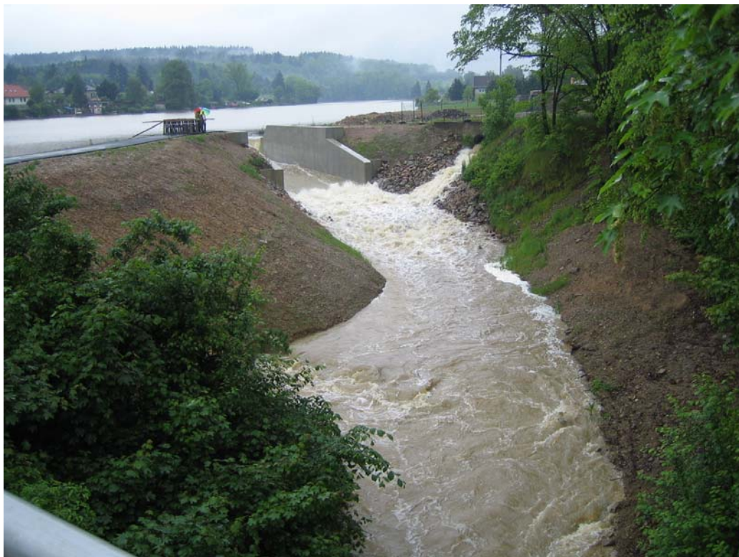
Holoubkovský rybník - Odpadní koryto od bezpečnostního přelivu
