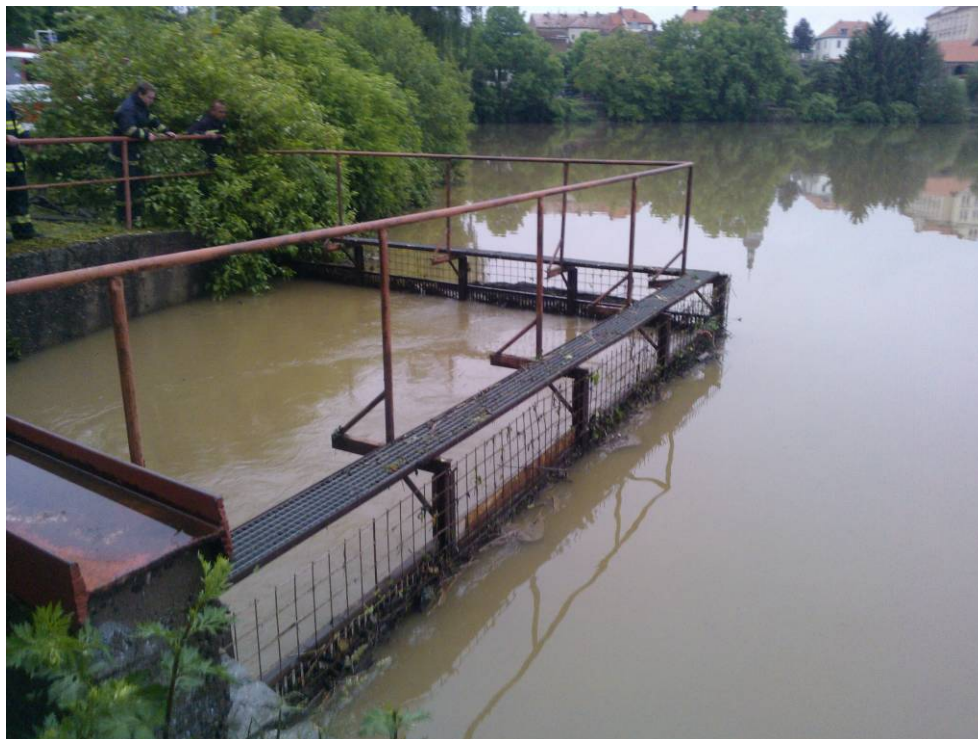
Mlýnský rybník - bezpečnostní přeliv, den po kulminaci povodně 3.6.2013.
