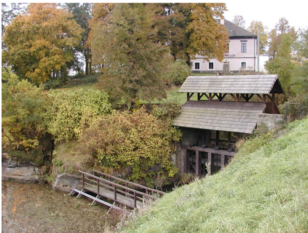
Česlová stěna a stavidlová výpust při provozní hladině 10.10.2013
