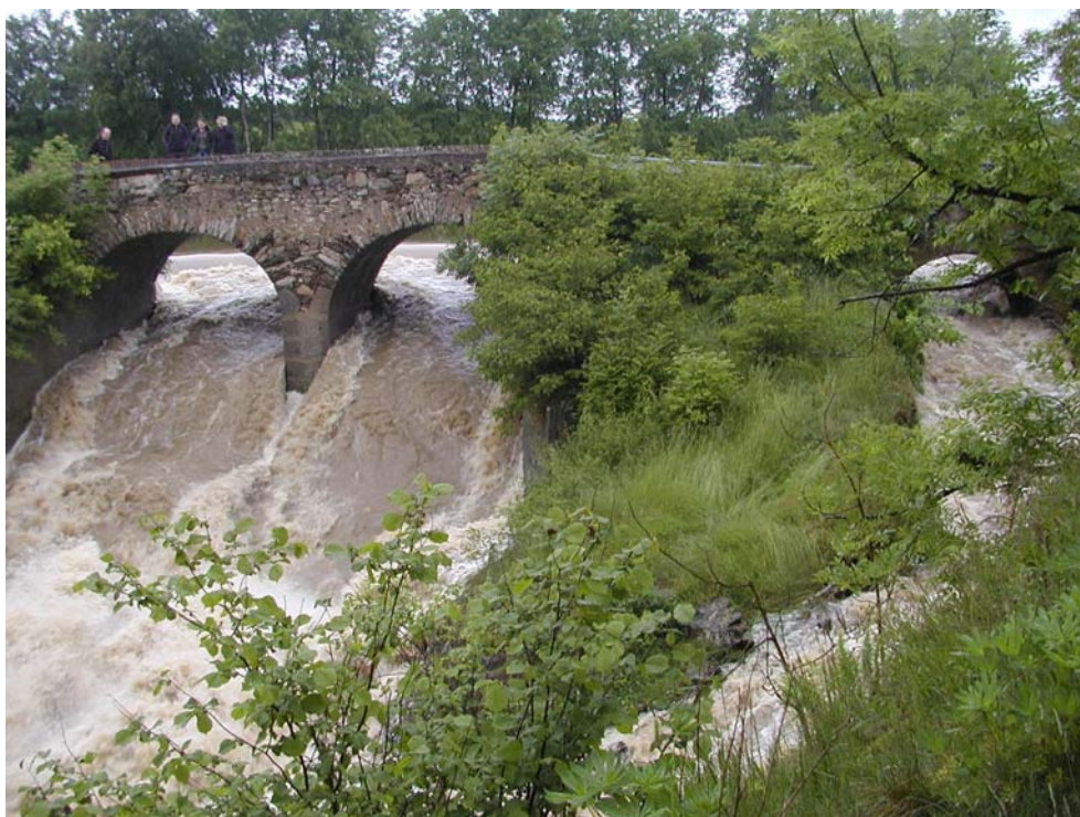
Odtok vody od bezpečnostních přelivů rybníka Chobot při povodni 2.6.2013
