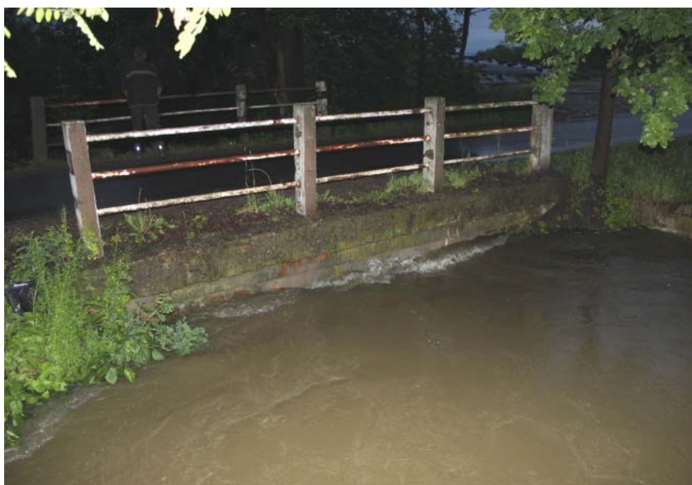
Rybník Zbudovský – zahlcený vtok propustku za bezpečnostním přelivem při kulminaci hladiny v nádrži (archiv provozovatele, 4. 6. 2013)
