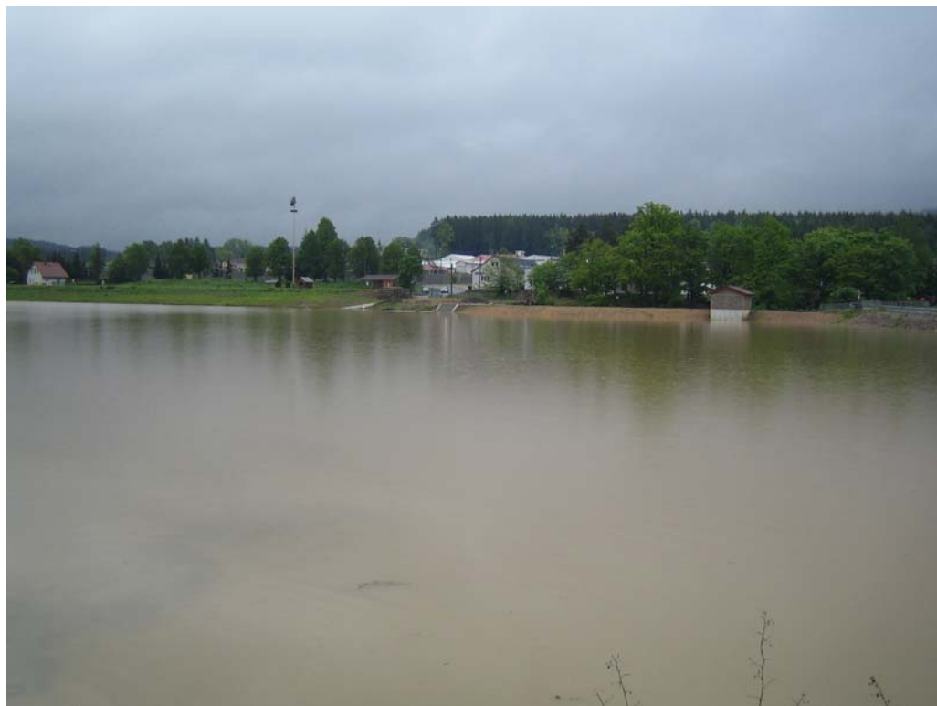
Holoubkovský rybník - Pohled na levé zavázání s doplňkovým i bezpečnostním přelivem
