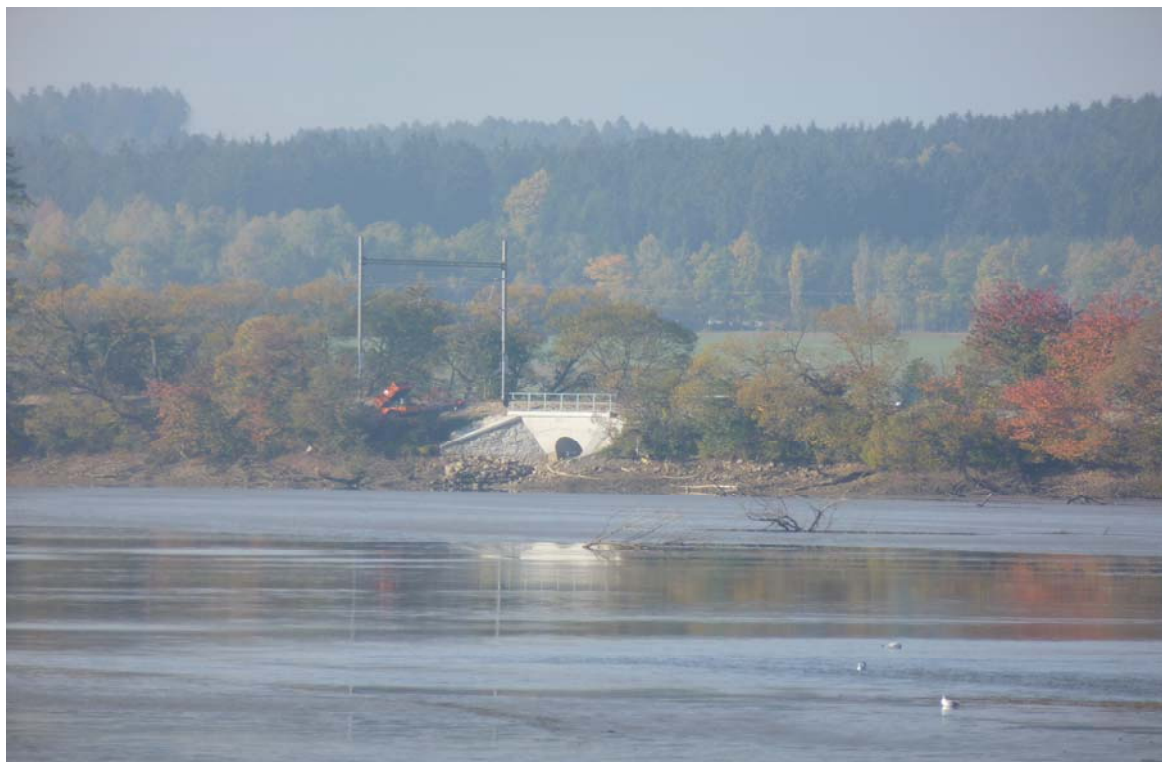
Kařežský dolní rybník - pohled na železniční násep s propustkem
