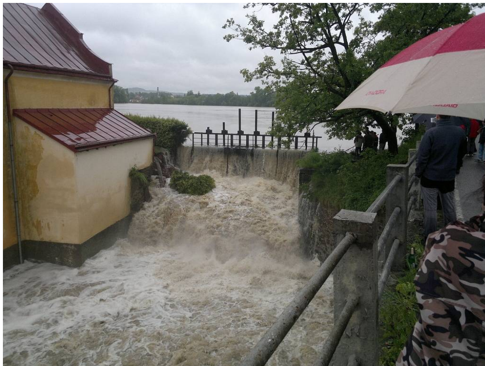
Splavský rybník - pohled na stavidla bezpečnostního přelivu (2. 6. 2013).
