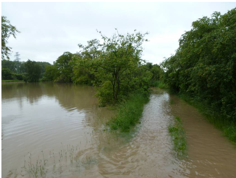
Olšanský rybník – pohled na korunu hráze v pravém zavázání (2. 6. 2013).
