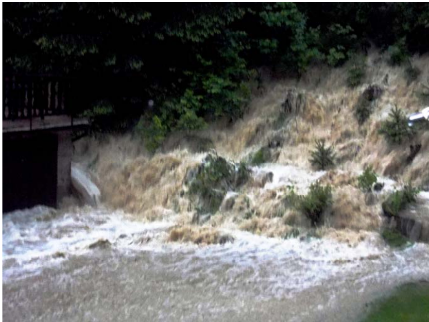
Rybník Mlýnský (Stádlec) - pohled na přelévání střední a levé části koruny hráze při kulminaci povodně dne 2. 6. 2013 po 5. hod. ráno (foto získáno od firmy Štičí líheň – ESOX s.r.o.).
