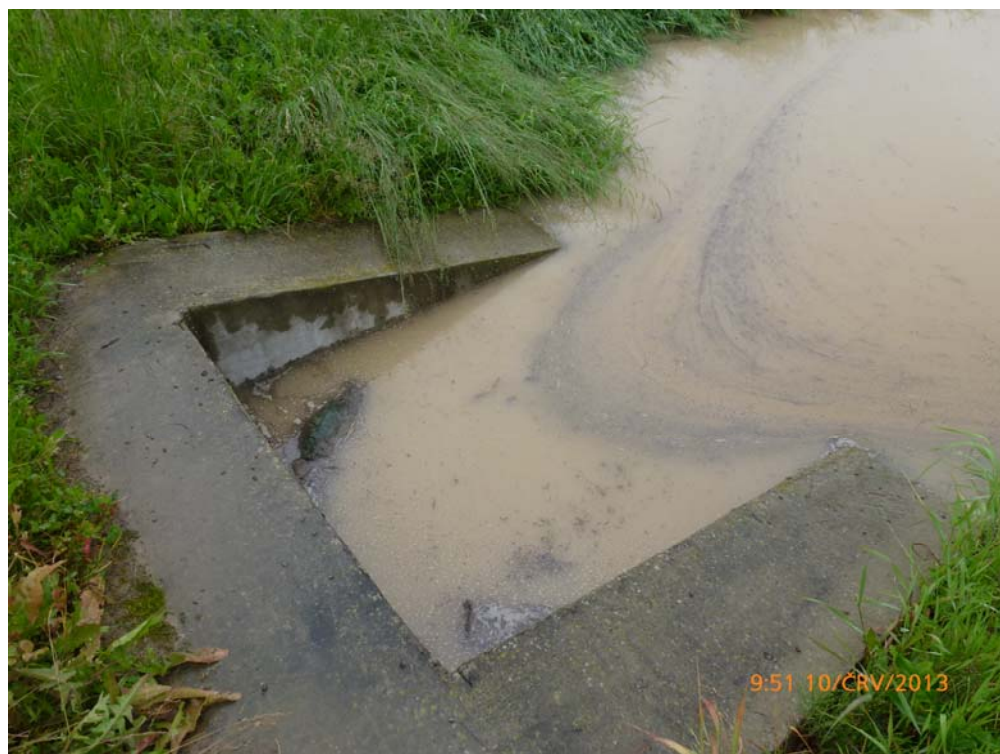
VD Bohuslavice – stav na nátoku do výpustného zařízení
