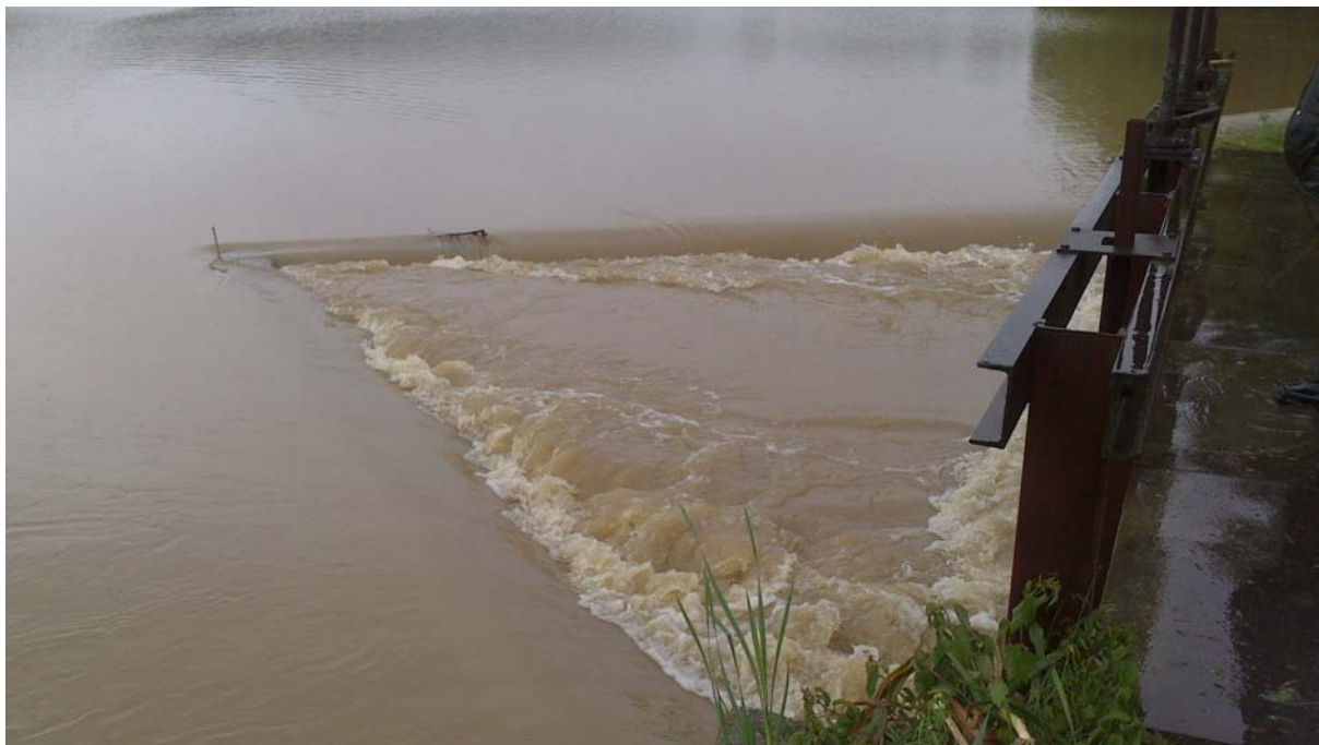
Rybník Hrejkovický - pohled na přelévající česlovou stěnu bezpečnostního přelivu při kulminaci hladiny v nádrži na kótě 467,95 m n. m. (archiv provozovatele, 2. 6. 2013).
