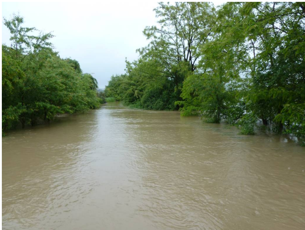
Olšanský rybník - pohled na přelévanou korunu hráze v době kulminace (2. 6. 2013).
