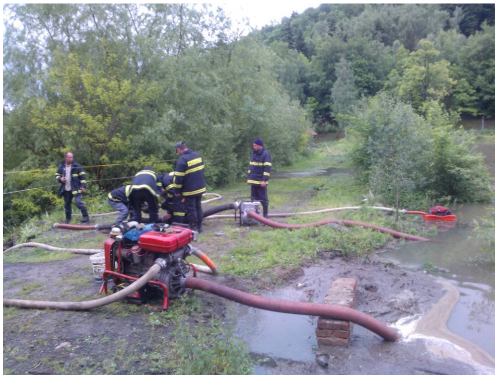
Oráčovský rybník – přečerpávání vody JSDH Jesenice u bezpečnostního přelivu (3. 6. 2013).
