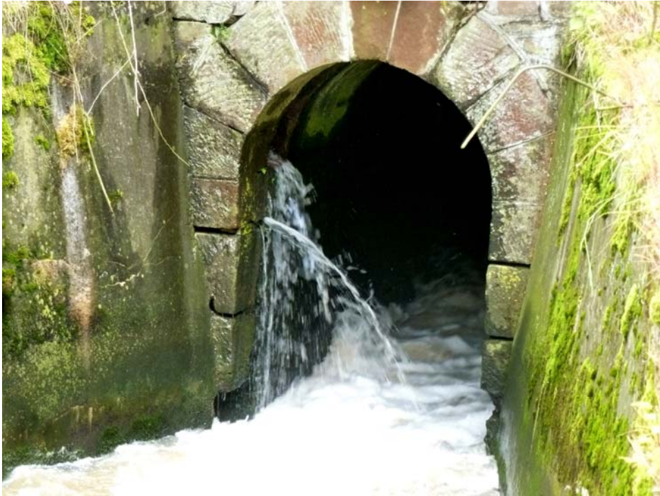
Rybník Vavřinec – vývěr u pravého konce opevnění štoly spodní výpusti (VODNÍ DÍLA – TBD a.s., 6. 6. 2013).
