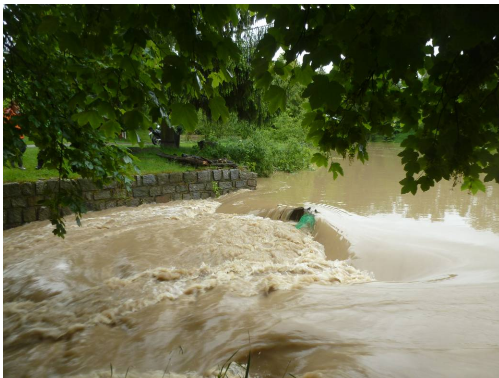
Rybník Skalník – pohled na bezpečnostní přeliv po kulminaci (2. 6. 2013).
