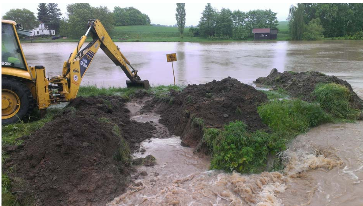
Prohrábka boční hráze Chotouchovského rybníka
