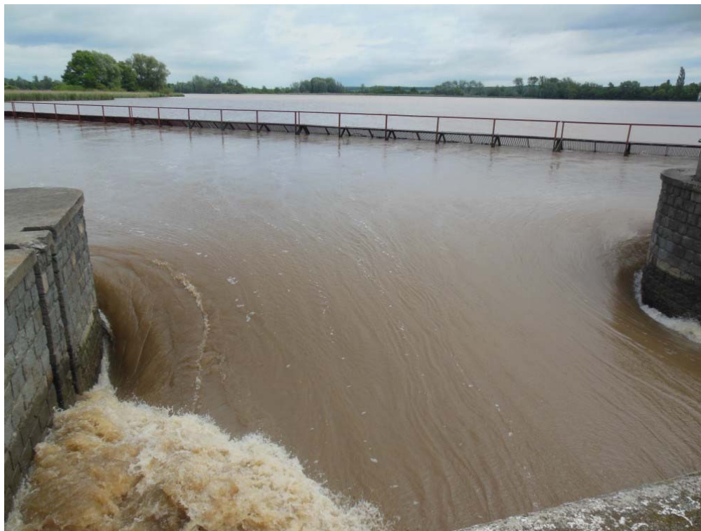
Žehuňský rybník - pohled na sklopenou klapku přelivu
