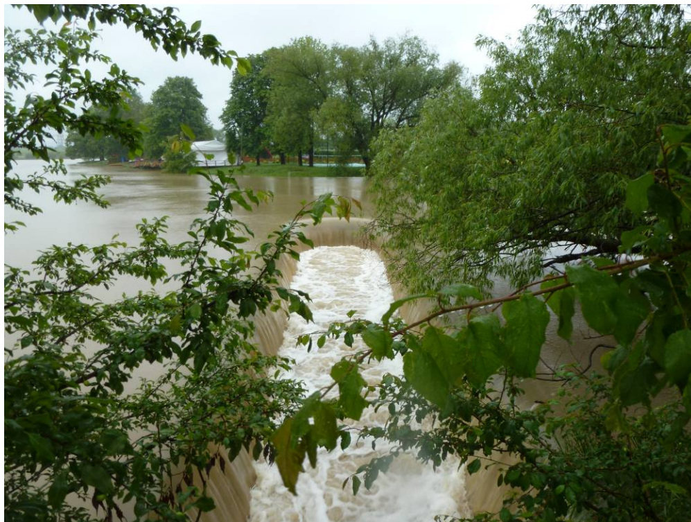
Rybník Šeberák - pohled na kašnový bezpečnostní přeliv (2. 6. 2013).
