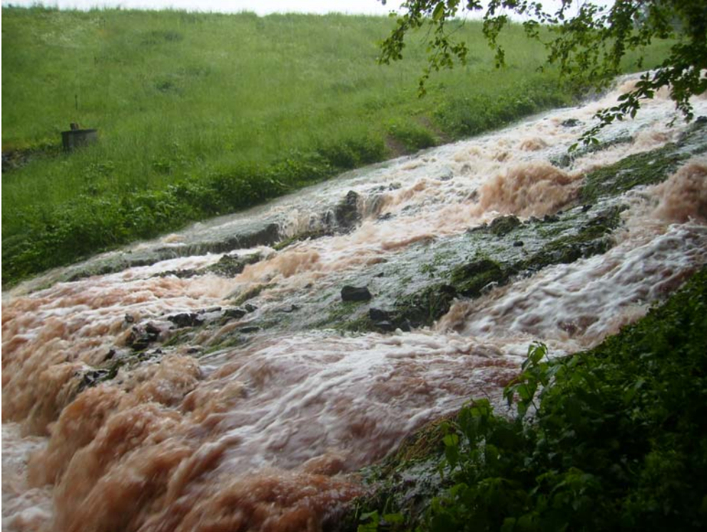
Obr. 2.3 - Jahodnice – kaskáda od bezpečnostního přelivu (Povodí Labe s.p., 2.6.2013)
