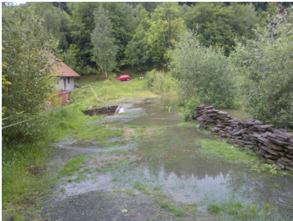
Oráčovský rybník - pohled na přelévanou korunu hráze (3. 6. 2013).
