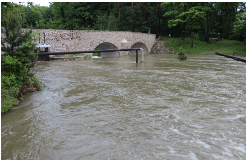
Rybník Bezdrev – pohled na most bezpečnostního přelivu (archiv provozovatele 4. 6. 2013).
