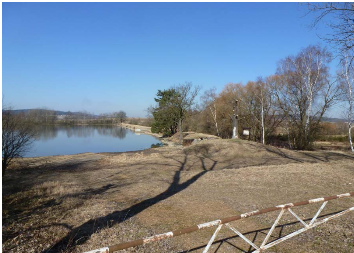
Kařežský dolní rybník - pohled na pravé zavázání s doplňkovým i bezpečnostním přelivem
