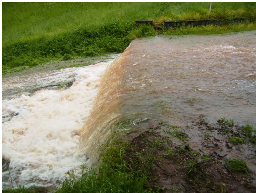
Jahodnice – pohled na kaskádu od bezpečnostního přelivu (Povodí Labe s.p., 2.6.2013)
