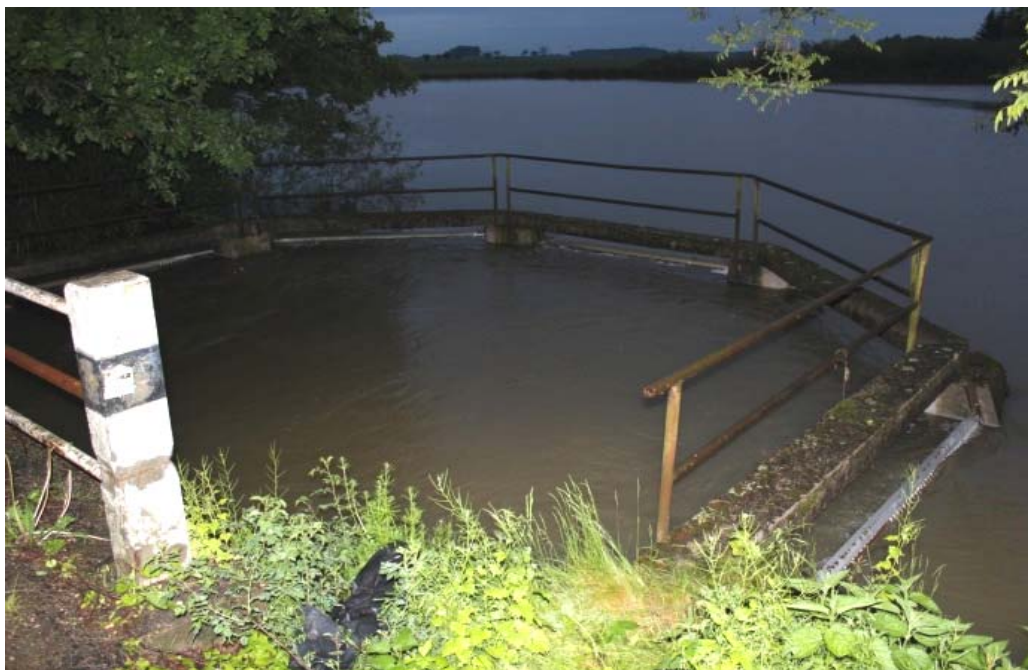
Rybník Zbudovský - pohled na bezpečnostní přeliv při kulminaci hladiny v nádrži (archiv provozovatele, 4. 6. 2013)
