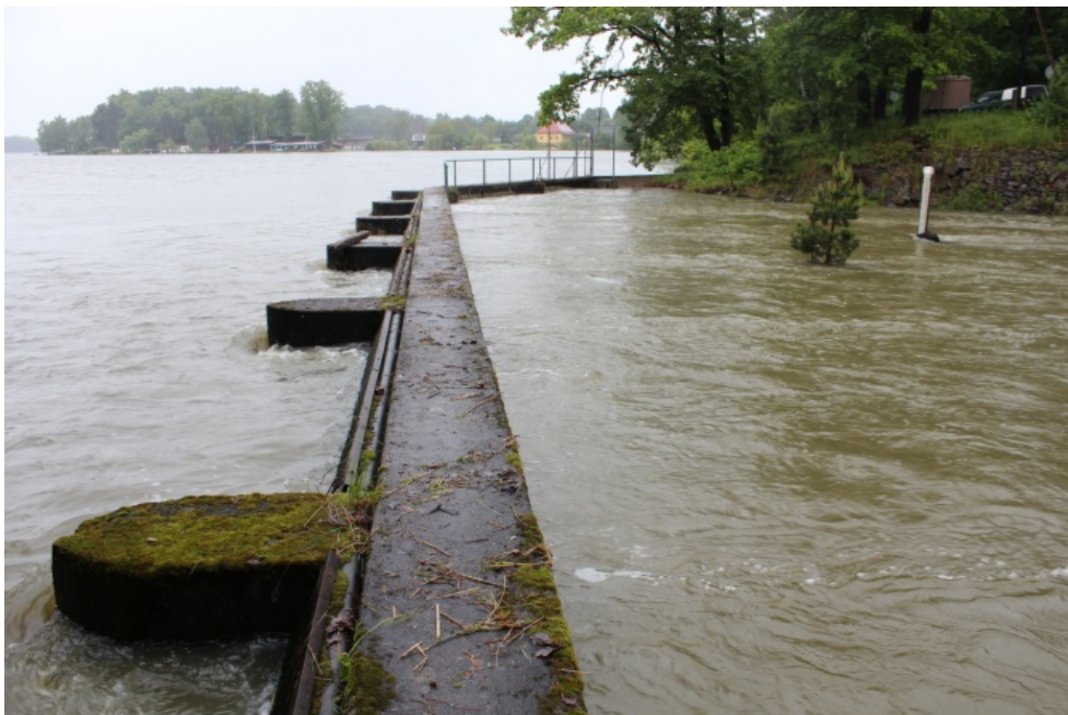
Rybník Bezdrev - pohled na česlovou stěnu bezpečnostního přelivu (archiv provozovatele 4. 6. 2013).
