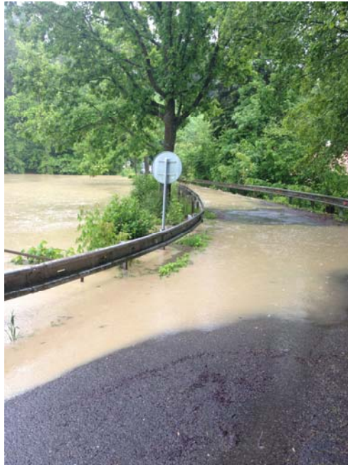
Rybník Mlýnský (Stádlec) - pohled na přelévání střední a levé části koruny hráze při kulminaci povodně dne 2. 6. 2013 po 5. hod. ráno (foto získáno od firmy Štičí líheň – ESOX s.r.o.).
