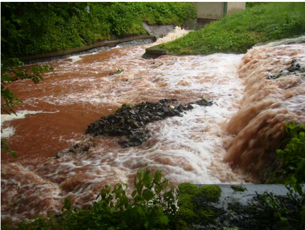
Obr. 2.4 - Jahodnice – soutok kaskády od bezpečnostního přelivu a odpadu potrubí stálého průtoku (Povodí Labe s.p., 2.6.2013)
