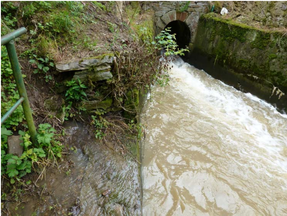
Rybník Vavřinec – vývěr z terénu nad pravou betonovou zdí asi 5 m od vzdušní paty (VODNÍ DÍLA – TBD a.s., 6. 6. 2013).
