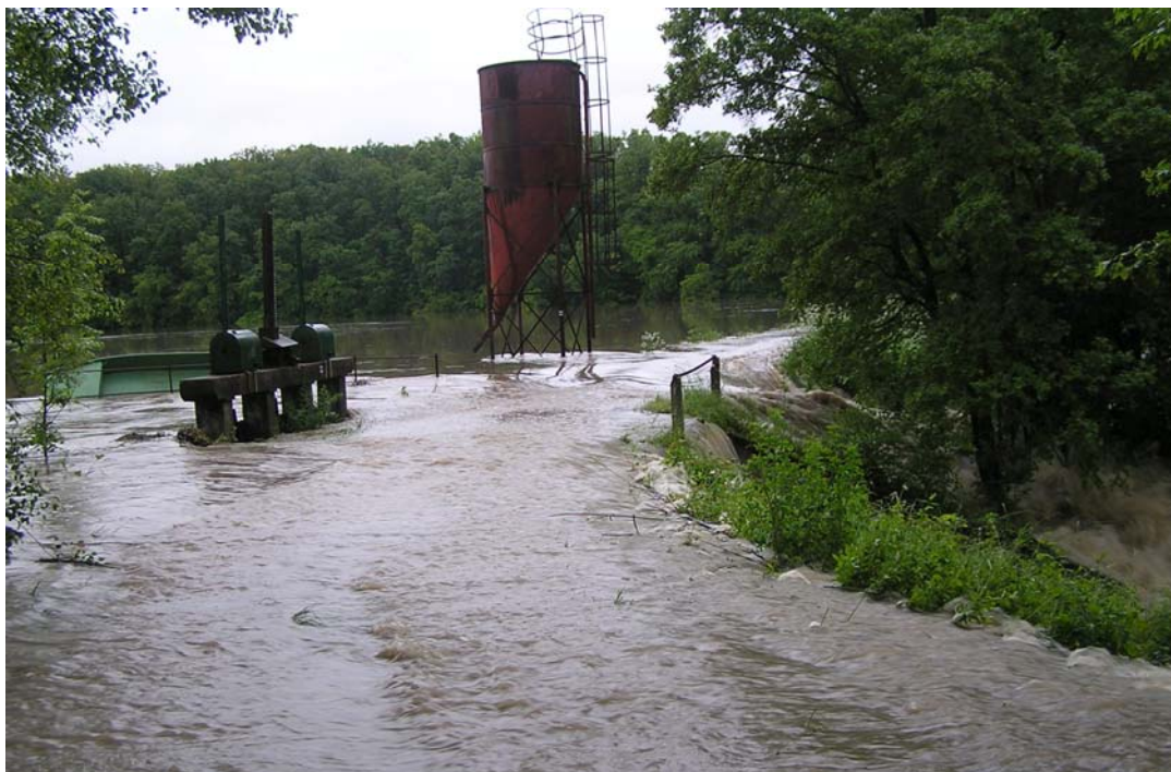
VD Komárovský rybník - voda přepadající přes hráz rybníka
