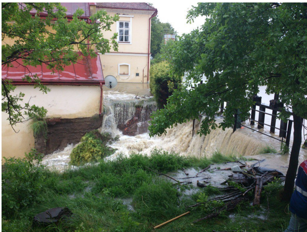
Splavský rybník – pohled na přelévané pravé zavázání u bezpečnostního přelivu (2. 6. 2013).
