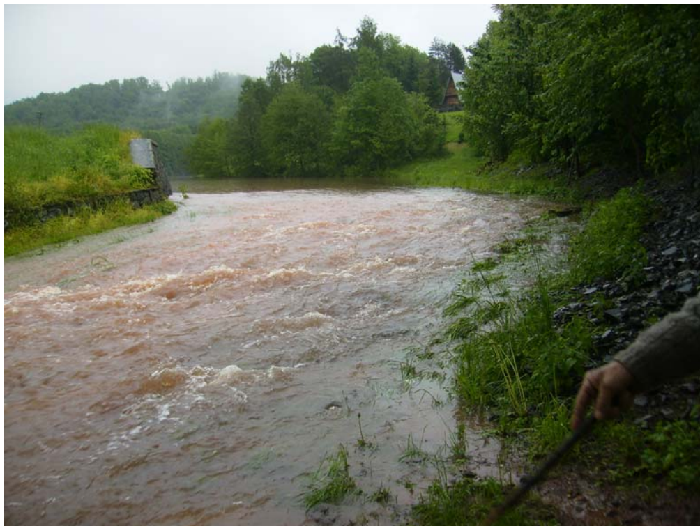
Jahodnice - bezpečnostní přeliv (Povodí Labe s.p., 2.6.2013)
