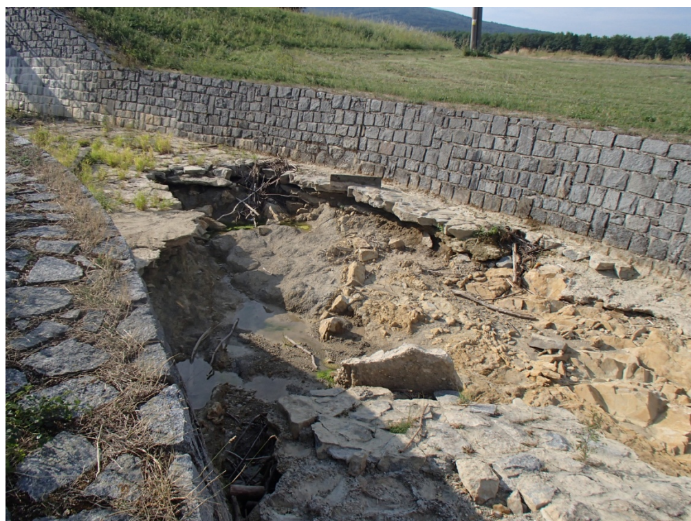
VD Bánov_Ordějov silně poškozený skluz a vývar
