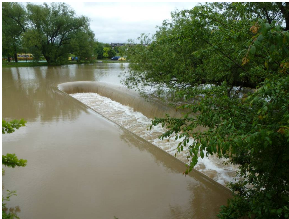
Rybník Šeberák – pohled na bezpečnostní přeliv v době kulminace (2. 6. 2013).
