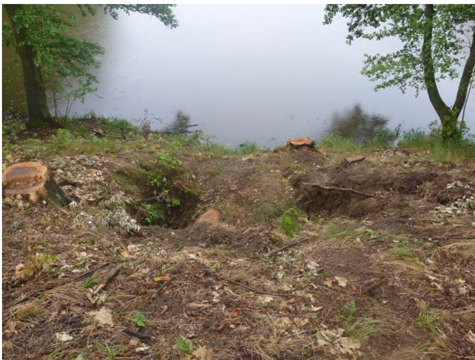
Rybník Nový Jistebnický - propadlý vzdušný svah v profilu spodní výpusti (VODNÍ DÍLA – TBD a.s., 24. 6. 2013)
