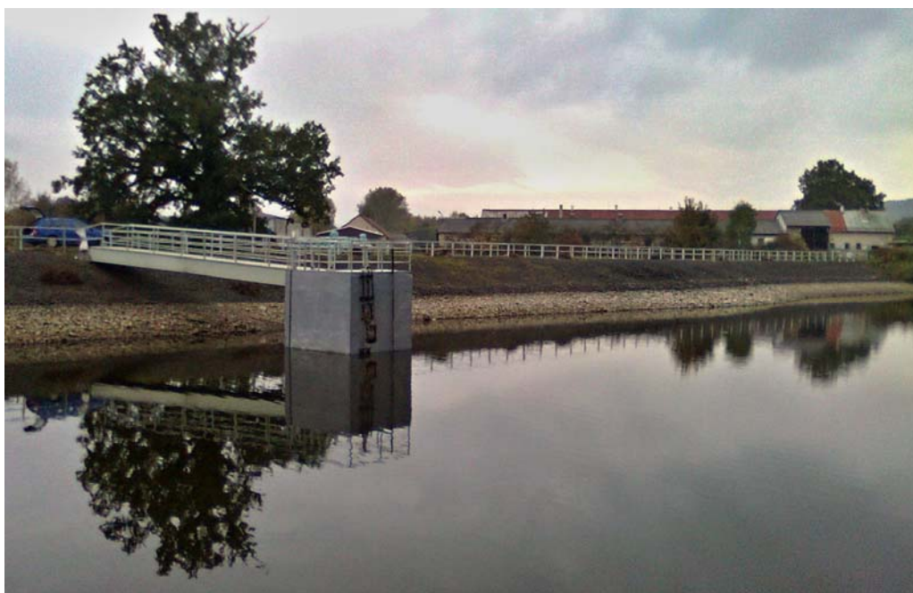
VD Markvartice – funkční objekt spodních výpustí
