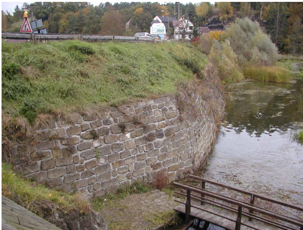
Hráz Novozámeckého rybníka při provozní hladině 10.10.2013.
