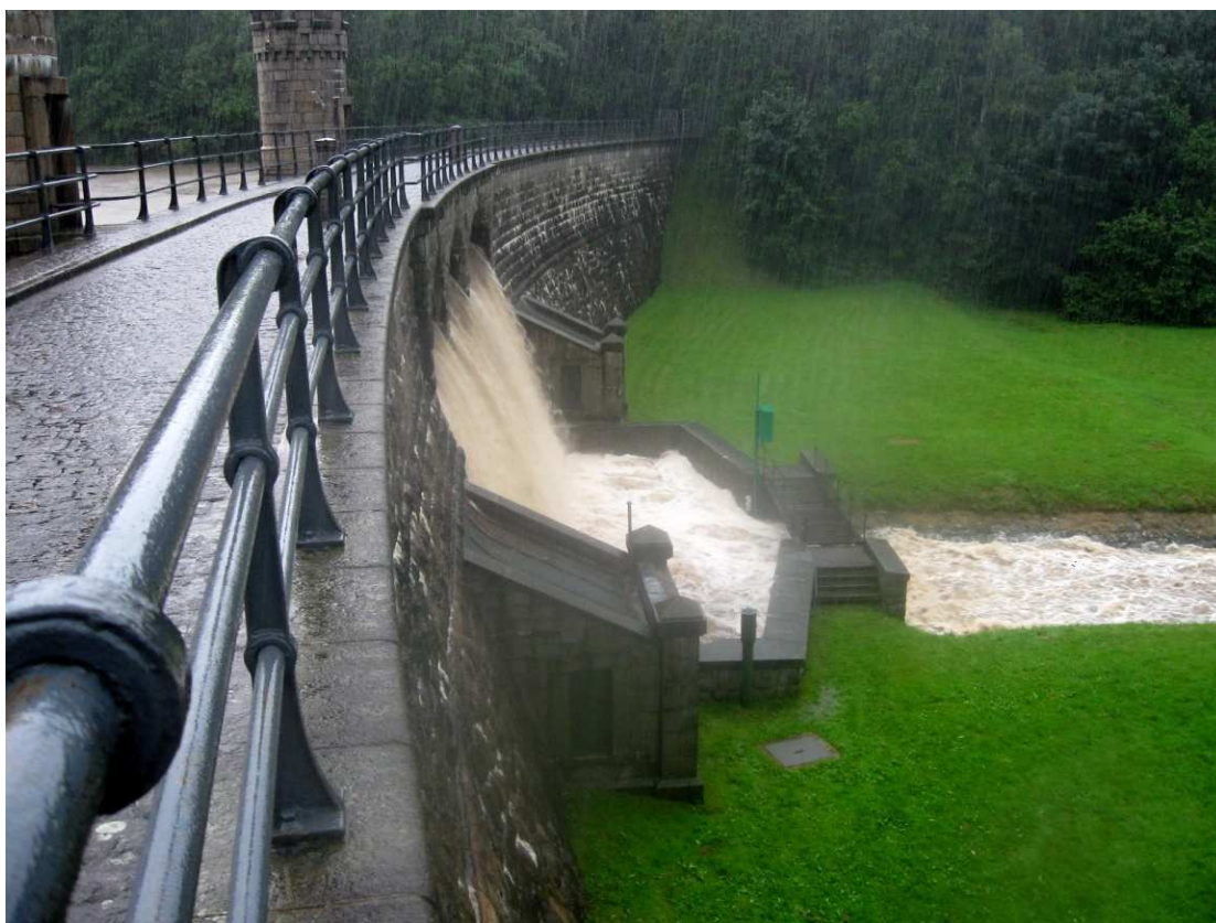
Obr. 4.8 - VD Fojtka, bezpečnostní přeliv v činnosti (7.8. 9:46 hodin)
