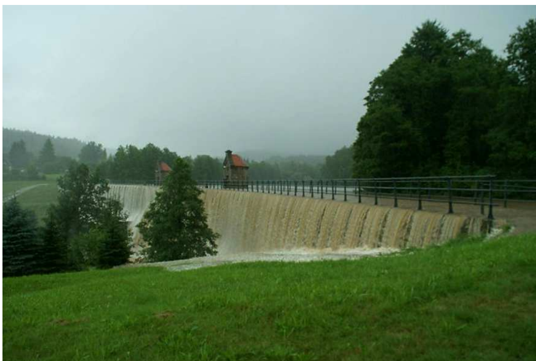
Obr. 4.9 - VD Mlýnice, přelévání koruny hráze (7.8. 10:56 hodin)
