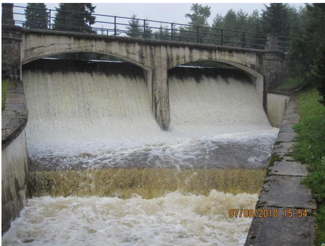
Obr. 4.7 - VD Bedřichov, bezpečnostní přeliv při povodni
