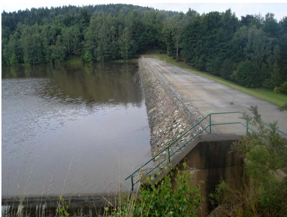
Obr. 2.11 - VD Chřibská, těleso hráze, nádrž dne 8.8.2010
