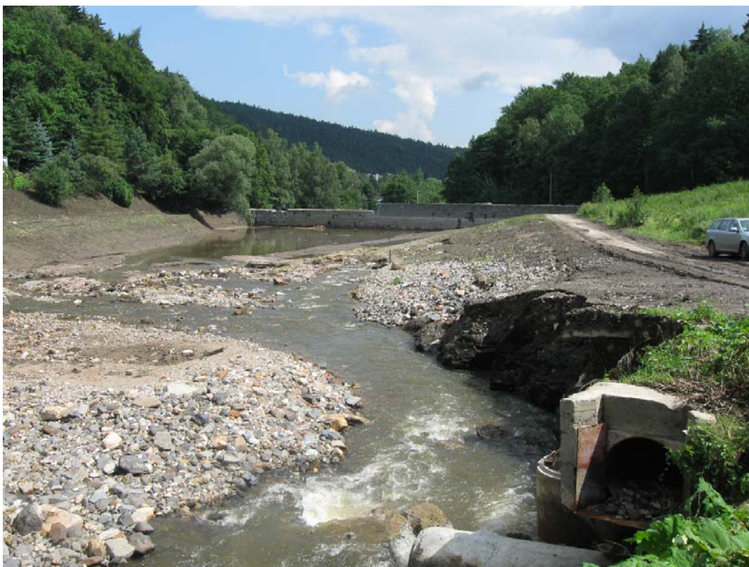
Obr. 4.2 – Prostor nátoky do obtokového potrubí v červenci 2010
