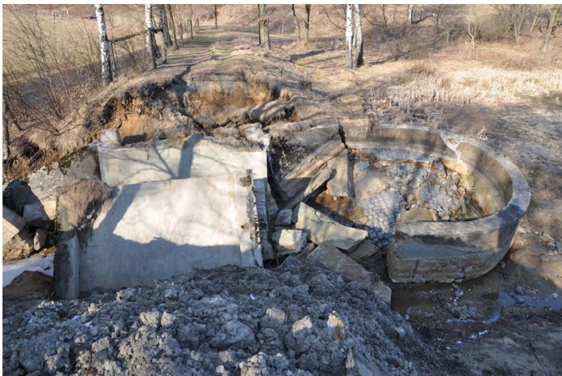
Obr. 3.34 – Panenský rybník – protržená hráz v profilu bezpečnostního přelivu – pohled z koruny hráze
