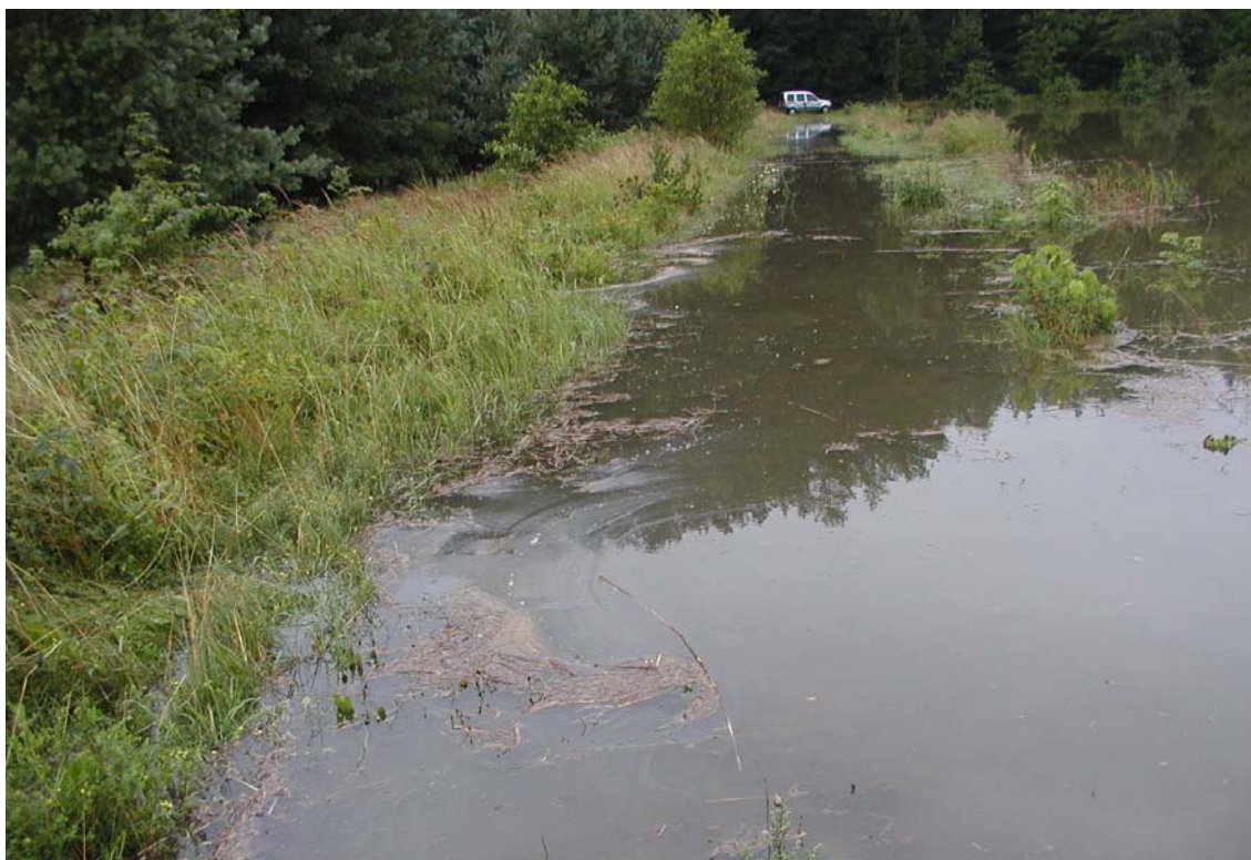
Obr. 3.7 – Rybník Kunratický dolní – Pohled na vodu přetékající přes korunu hráze vpravo od výpusti
