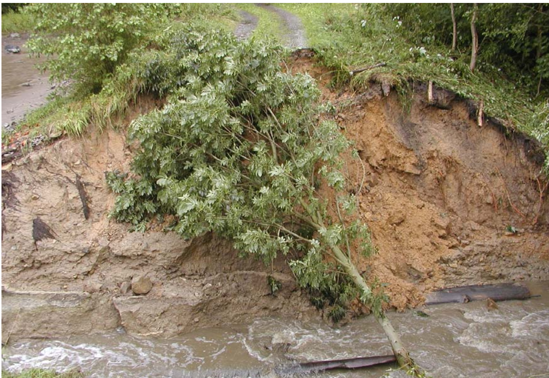
Obr. 3.18 – Kněžický rybník – Pohled z koruny hráze na průrvu v profilu spodní výpusti.
