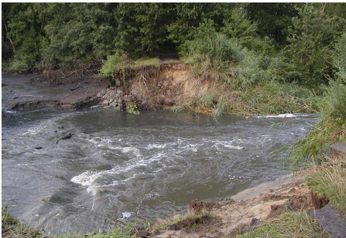
Obr. 3.25 – Mlýnský rybník – Pohled z koruny na průrvu v levé části hráze.
