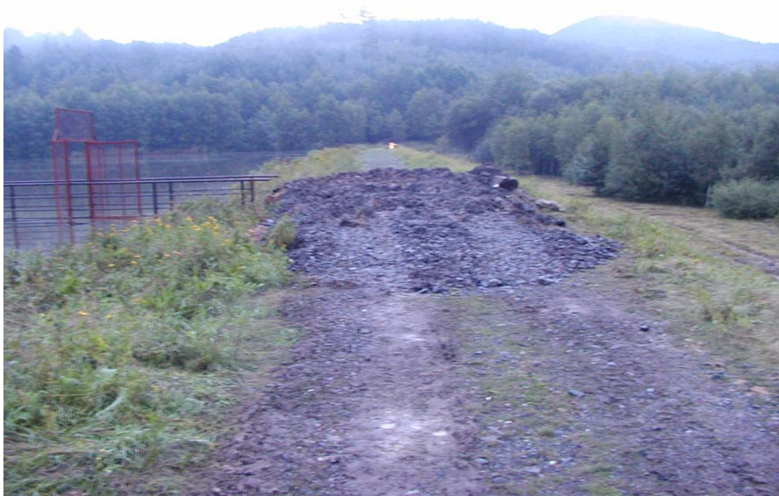
Obr. 3.4 – Rybník Kunratický horní – provizorní navážkou materiálu se zabránilo protržení v místě tvořící se průrvy v profilu výpusti.
