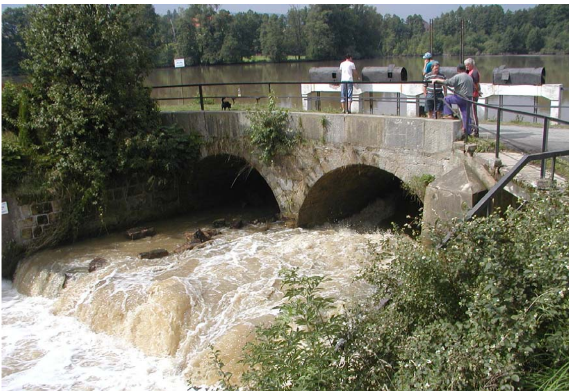
Obr. 3.23 – Markvartický rybník – Silniční mostek a stupeň za bezpečnostním přelivem.
