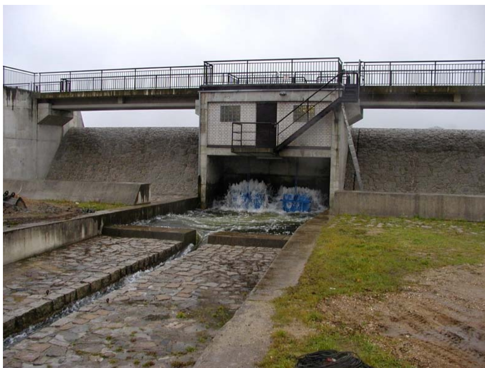
Obr. 2.19 - VD Stráž pod Ralskem, objekt spodních výpustí a bezpečnostního přelivu
