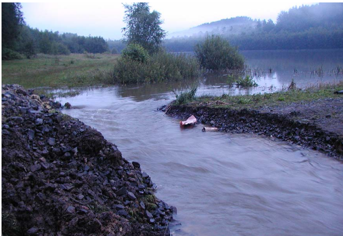
Obr. 3.3 – Rybník Kunratický horní – pohled na nouzový překop hráze v pravém zavázání provedený s cílem zamezit přelévání vody přes korunu hráze.
