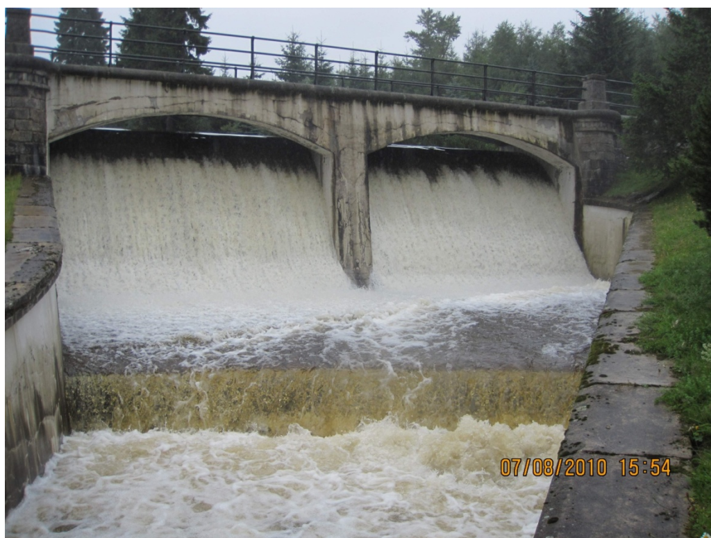
Obr. 2.8 -VD Bedřichov, bezpečnostní přeliv při povodni
