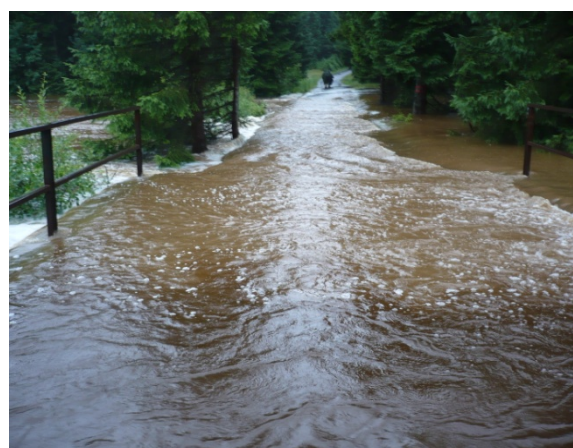
Obr. 2.4 - Blatný potok 7.8.2010, přelévání mostku na Novou Louku
