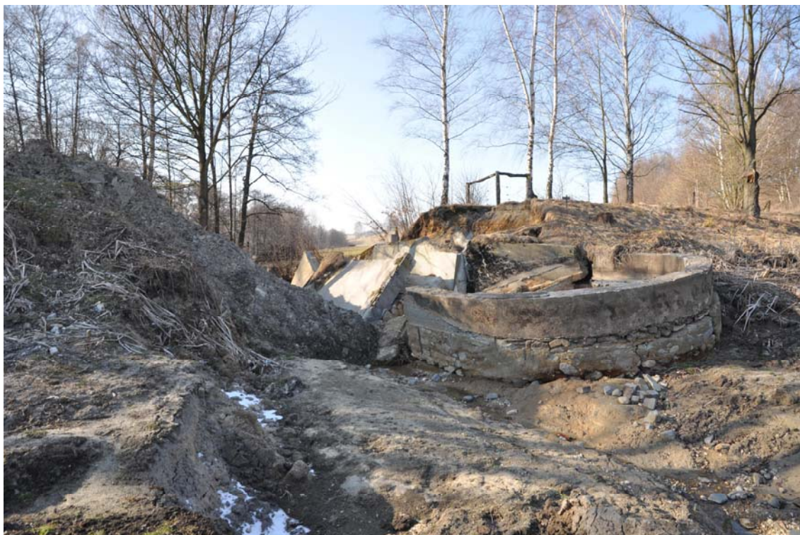
Obr. 3.34 – Panenský rybník – protržená hráz v profilu bezpečnostního přelivu – pohled z koruny hráze
