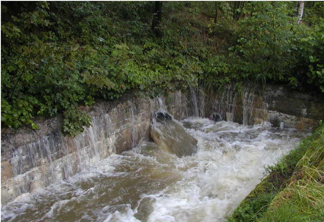
Obr. 3.8 – Rybník Kunratický dolní – Vyústění potrubí spodní výpusti do betonové podtrubní jámy.
