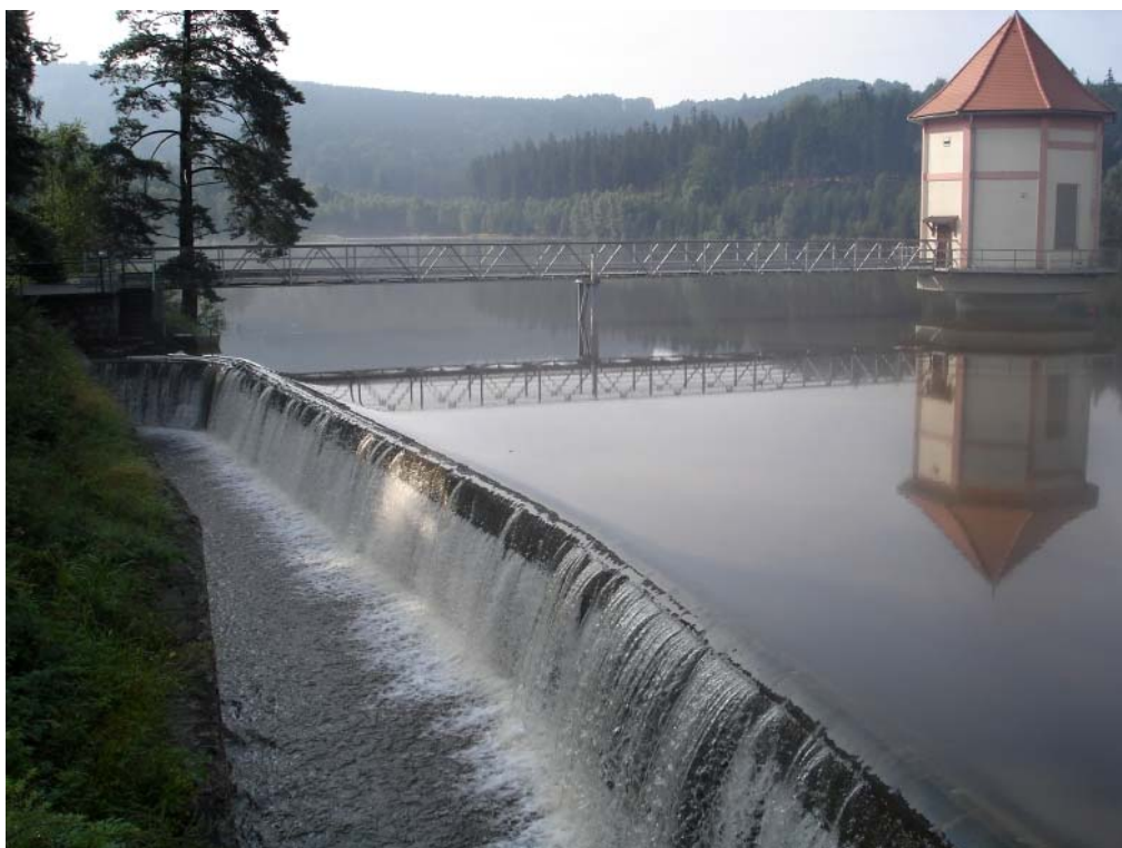
Obr. 2.10 - VD Chřibská, přepad přes bezpečnostní přeliv dne 8.8.2010
