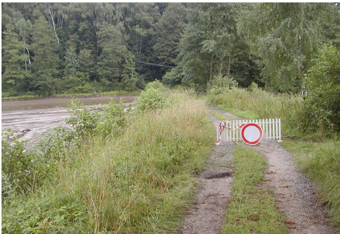
Obr. 3.16 – Kněžický rybník – Pohled na korunu hráze od pravého konce
