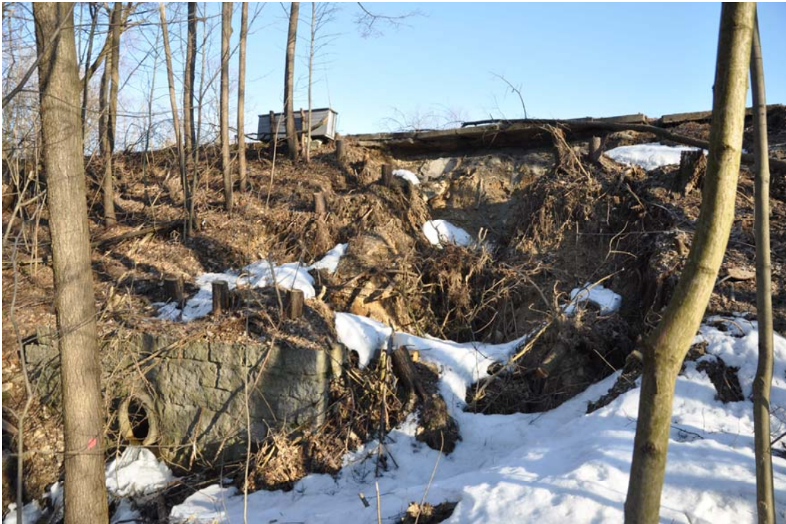
Obr. 3.40 – Retenční nádrž Albrechtice – pohled na porušený vzdušný svah v profilu nad spodní výpustí
