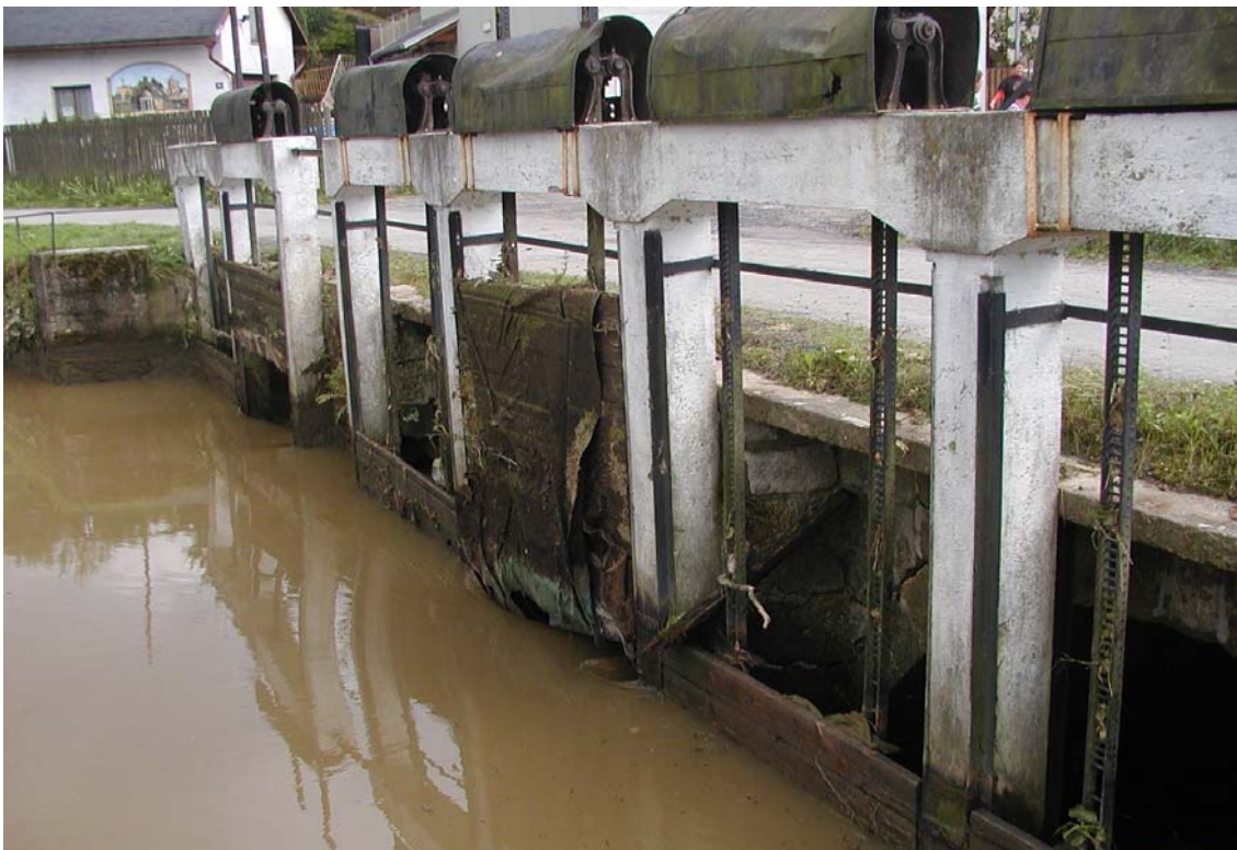
Obr. 3.22 – Markvartický rybník – Stavidla bezpečnostního přelivu.
