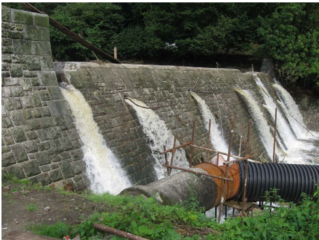
Obr. 4.3 – Prostor stavby v prostoru bezpečnostního přelivu v srpnu 2010
