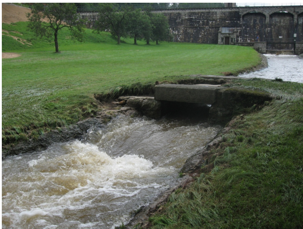
Obr. 2.14 - VD Fojtka, poškozený mostek přes odpadní koryto (8.8. 13:45 hodin)
