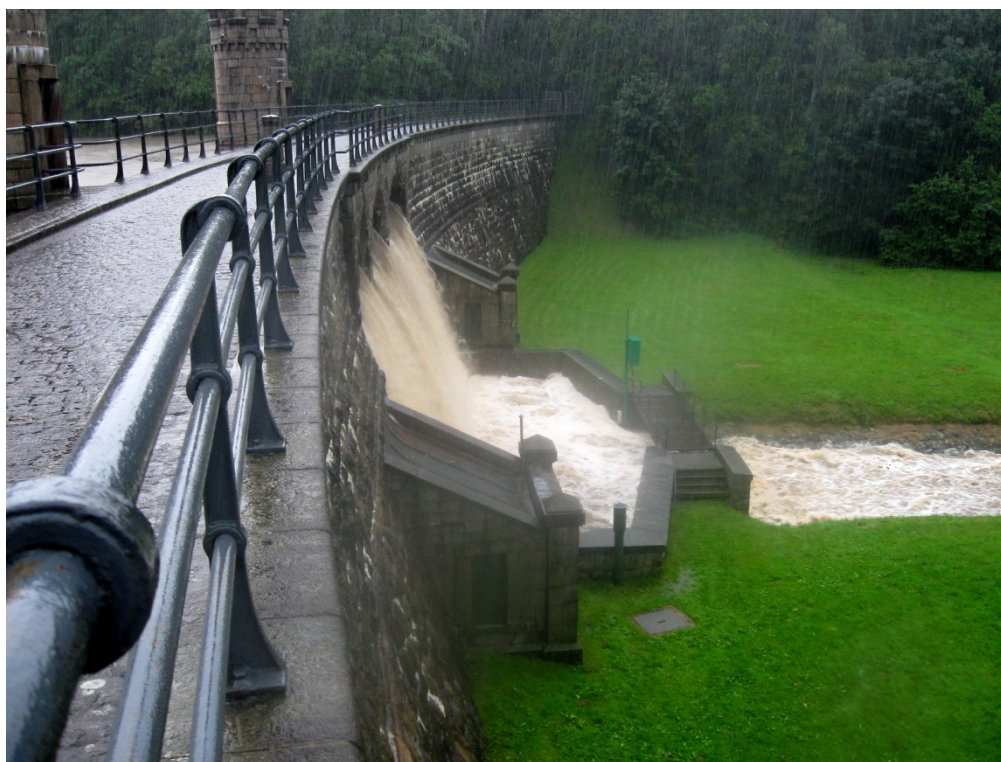
Obr. 2.12 - VD Fojtka, bezpečnostní přeliv v činnosti (7.8. 9:46 hodin)
