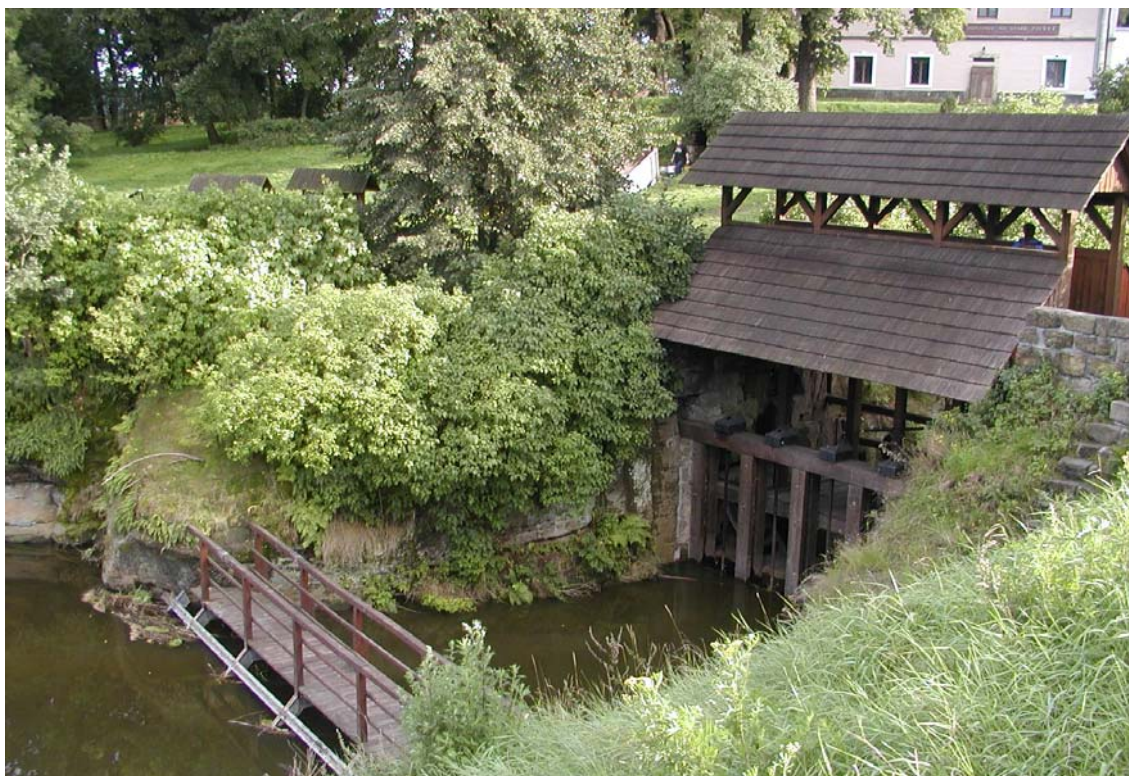
Obr. 3.2 – Novozámecký rybník – pohled z koruny hráze na česlovou stěnu a na stavidlovou výpust v levém konci hráze.
