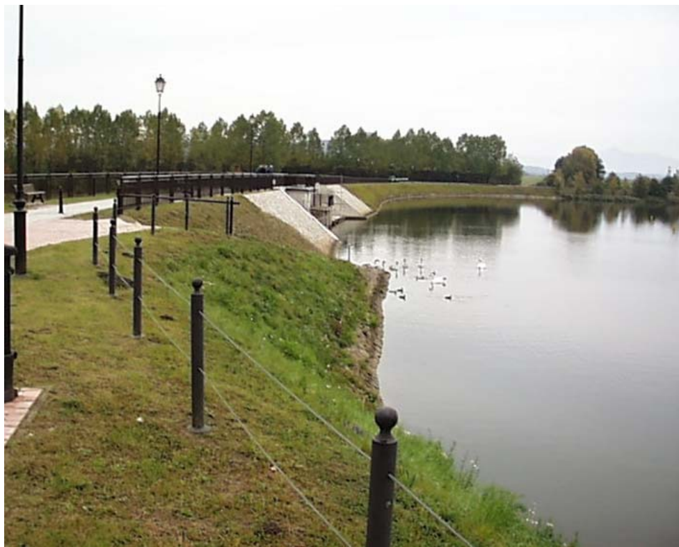
Obr. 2.18 - VD Stráž pod Ralskem, těleso hráze
