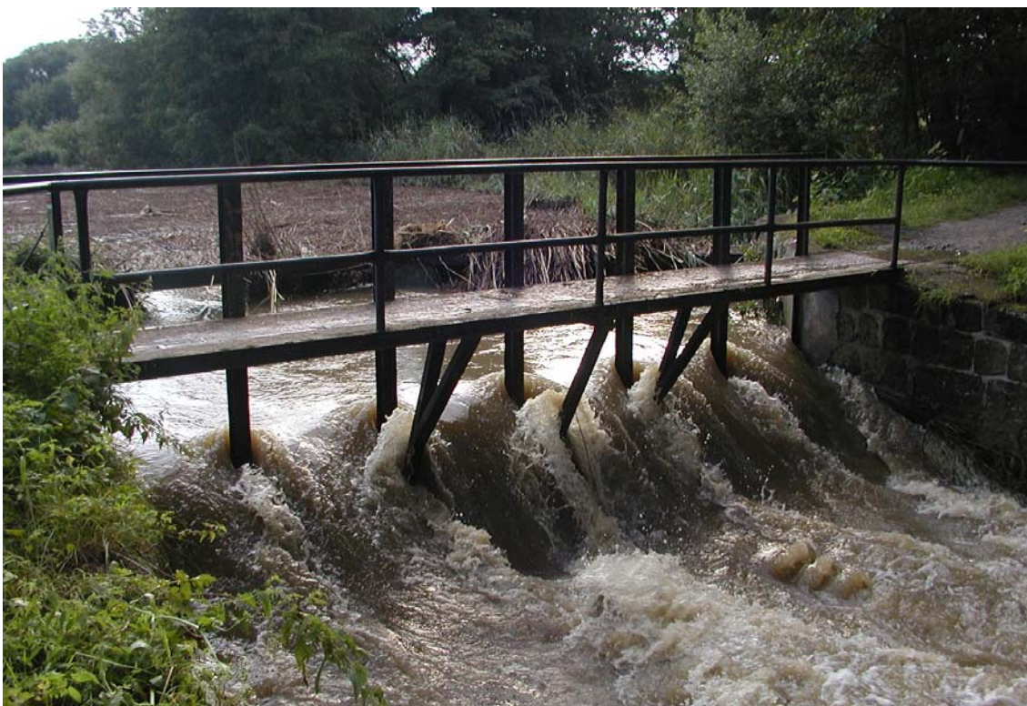
Obr. 3.15 – Holanský rybník – levý bezpečnostní přeliv
