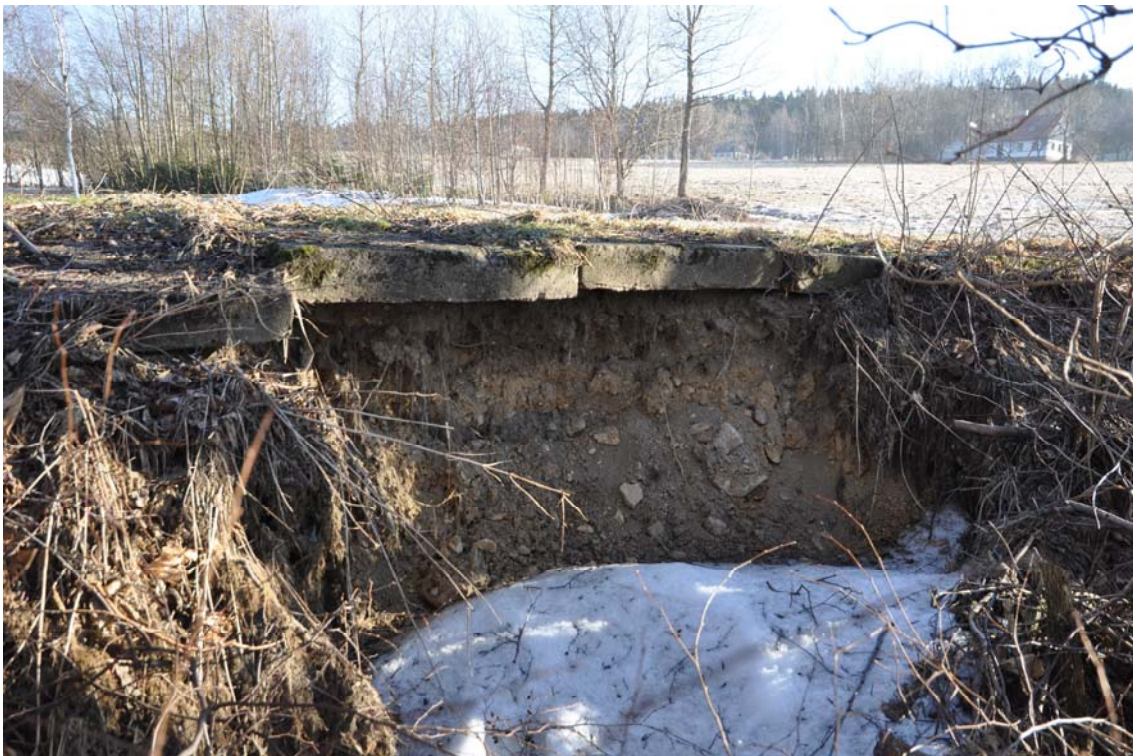
Obr. 3.40 – Retenční nádrž Albrechtice – pohled na porušený vzdušný svah v profilu nad spodní výpustí
