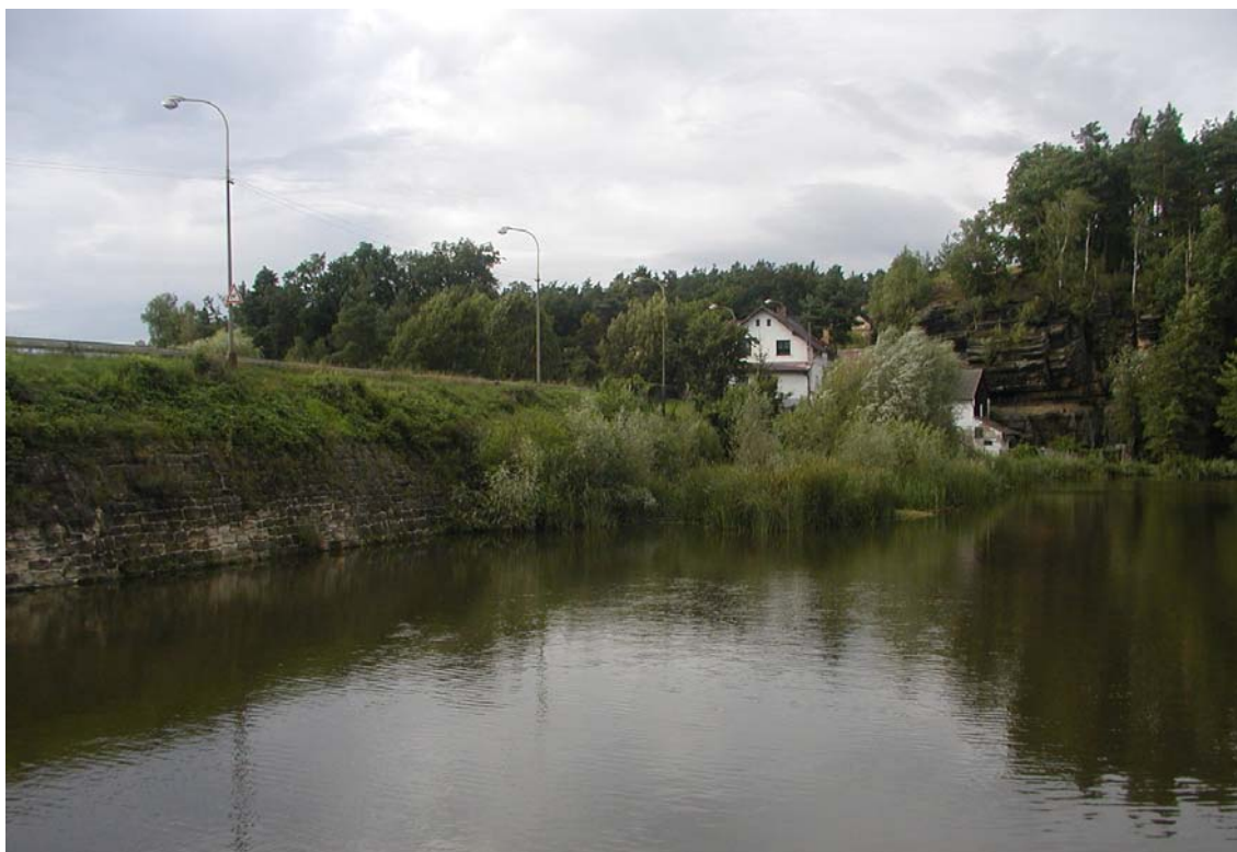
Obr. 3.1 – Novozámecký rybník – Pohled na návodní svah hráze.
