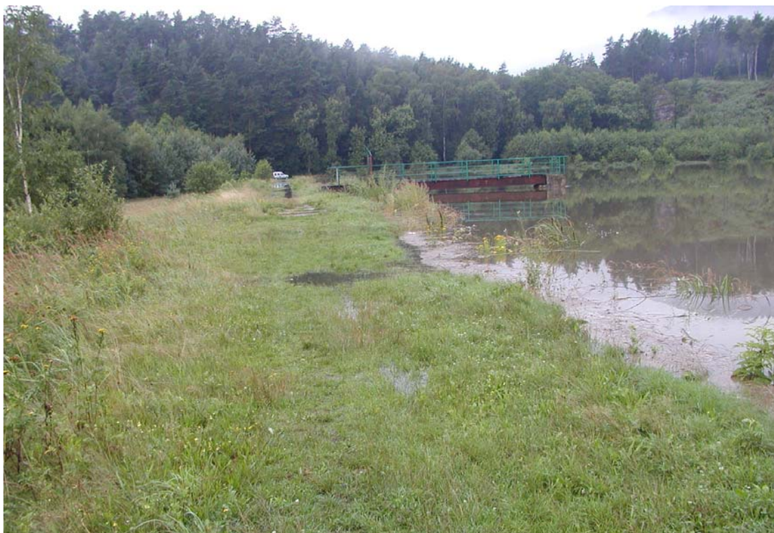
Obr. 3.6 – Rybník Kunratický dolní – Pohled na korunu od levého konce hráze.
