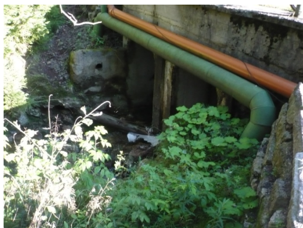
Obr. 2.1 - Kamenice pod lmg, návodní strana přemostění lesní cesty
