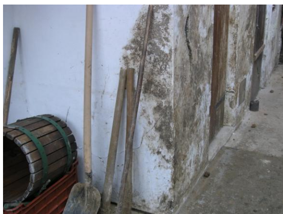
Foto 8 Zed' domu č.p. 264 poškozená trhlinami následkem sesuvu.
