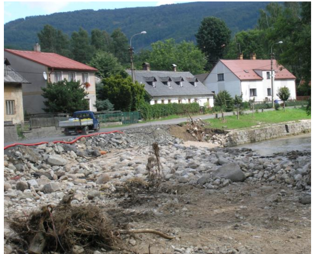
Foto 2 – Naplavený materiál při břehu řeky Smědá, vlevo poškozená silnice II/290
