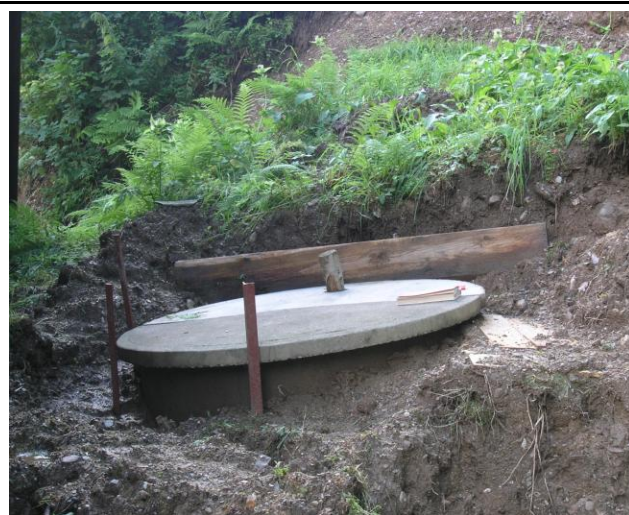
Foto 3 – porušená a zavalená studna za č.p. 40
