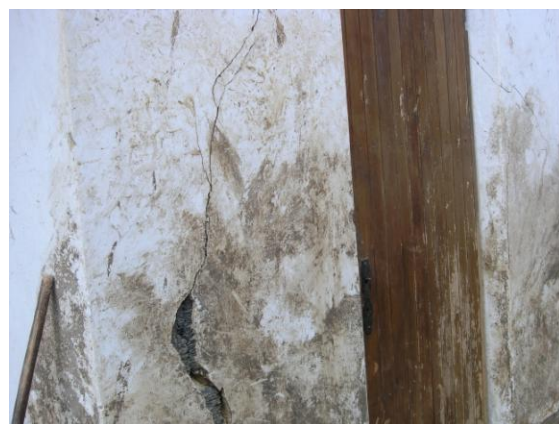
Foto 8 Zed' domu č.p. 264 poškozená trhlinami následkem sesuvu.
