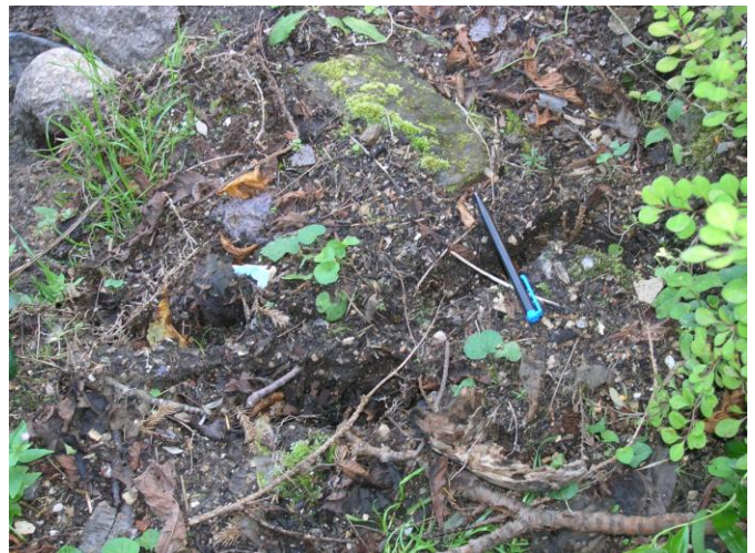
Foto 4 – Trhliny na povrchu parcely č. 1124 při okraji plošiny
