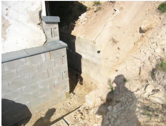
Foto 5 – Nestabilní svah nad opěrnou zídou. (Foto J. Krupička)
