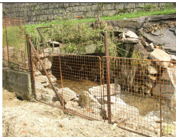
Foto 2 – Nouzově spravený plot v místech, kterými stékala voda ze svahu do koryta potoka
