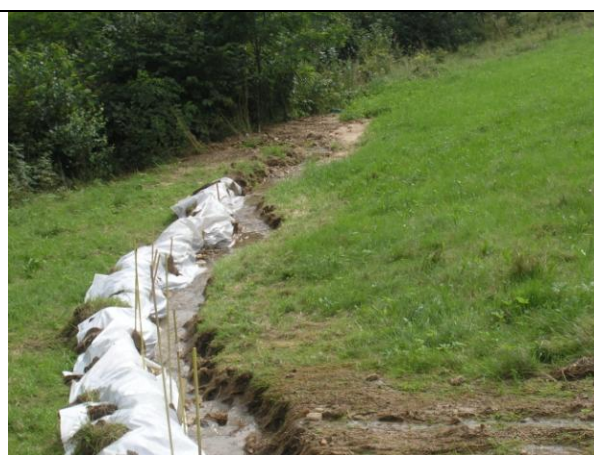
Foto 6 – Příkop na okraji louky nad pozemkem s objektem čp. 63 na odvedení vody
