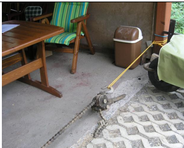
Foto 3 – Provizorní zajištění stability kůlny
