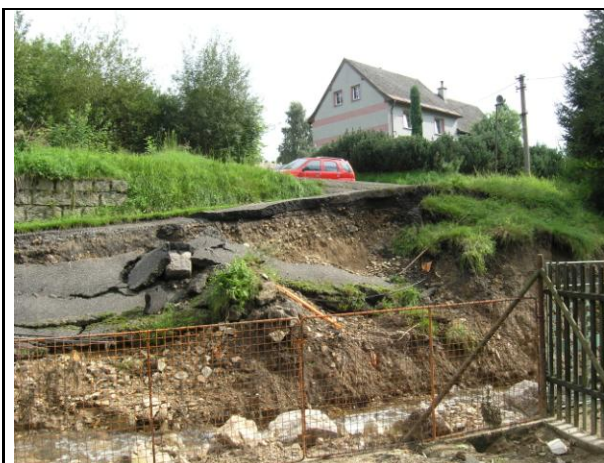
Foto 1 – Vítkovský potok, nad ním zhroucený násep silnice, dole pozemek pana Teslíka
