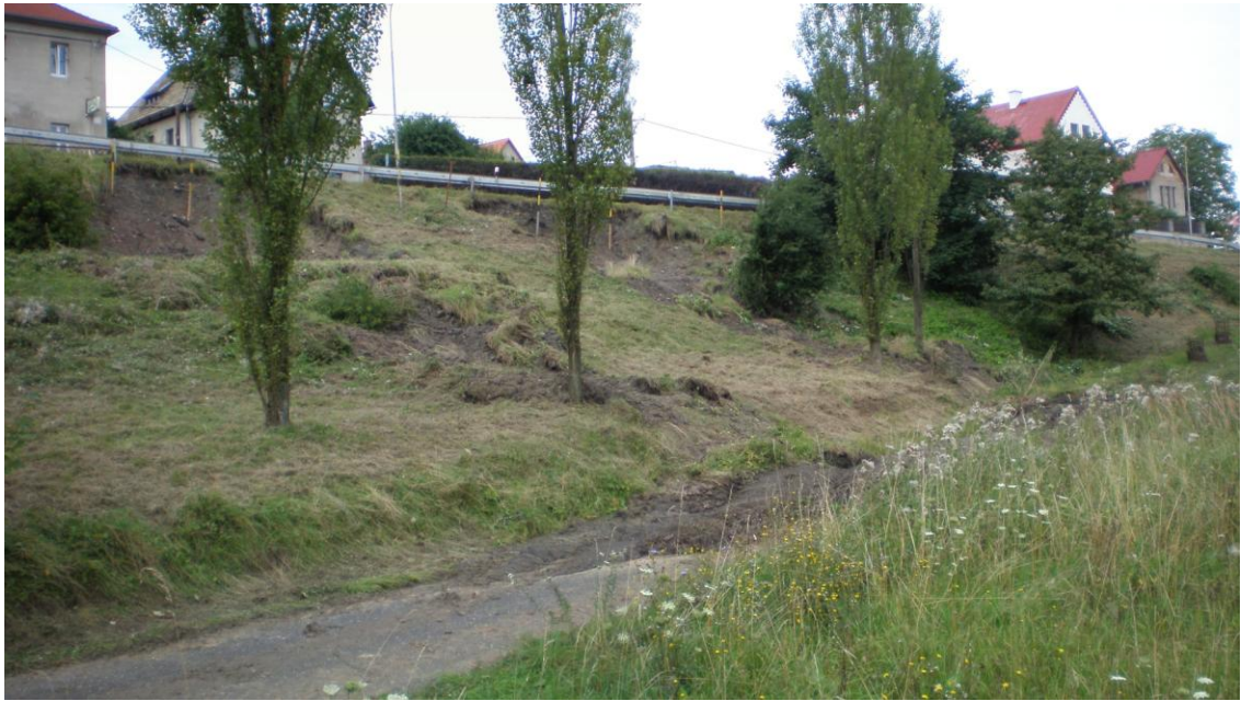
Obr. 2 Sesuvné území svahu pod silnicí I/8 s projevem dvou dílčích těles (foto J. Malík 11.8.2010)
