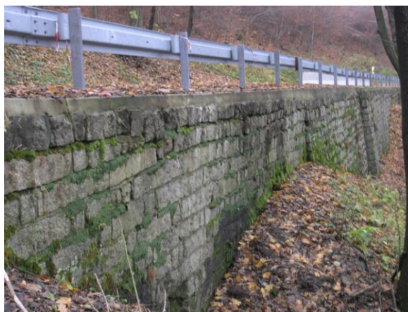
Foto 4 – Relativně stabilní opěrná zeď z kamenných kvádrů v nepoškozeném úseku silnice
