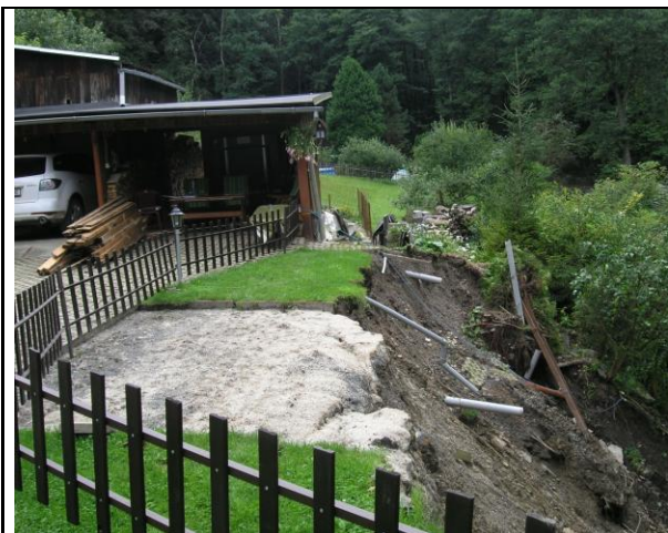
Foto 1 – Sesunutý svah u č.p. 111
