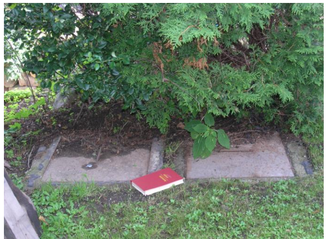
Foto 6 – Poklopy od septiku, v úrovni 3 – 4 m nade dnem potoka
