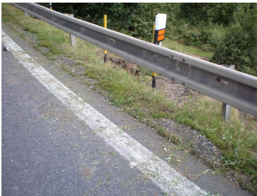
Obr. 9 Nad odlučnou hranou akumulace spláchnutého inertního posypu silnice, naznačující přítok srážek do svahu (foto J. Malík 11.8.2010).
