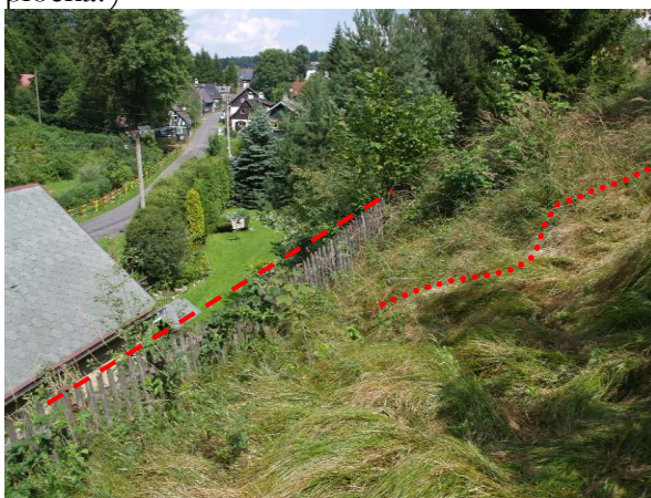
Foto 5: Mírný pokles plotu a zátrh ve svahu
