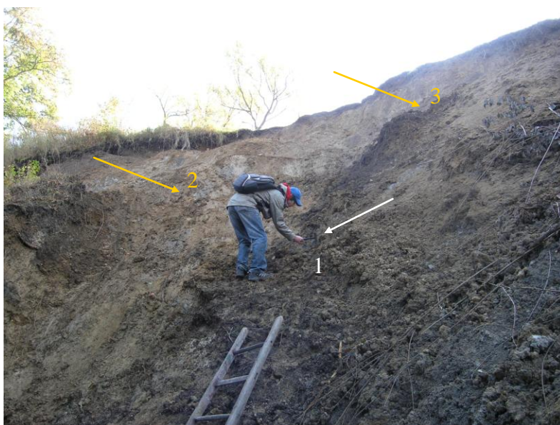
Foto 6 Výchozy podložních hornin v profilu obnaženém svahovým pohybem: 1 – jílovce jizerského souvrství, 2 – zpevněná tefra, 3 – zvětralá a rozložená tefra. Srovnej s foto 7.
