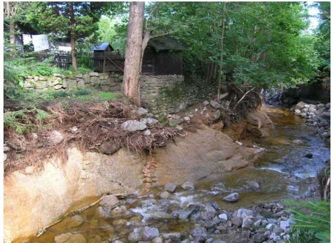
Foto 2 – Obnažený skalní podklad v levém břehu Černého potoka v podloží domu čp. 239
