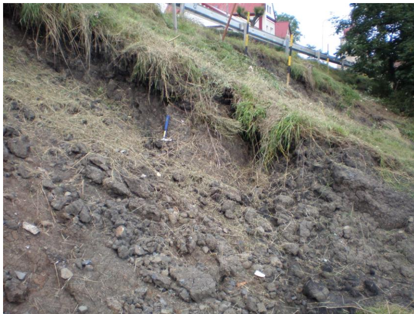
Obr. 7 Hloubka porušení cca 1 m (foto J. Malík 11.8.2010)
