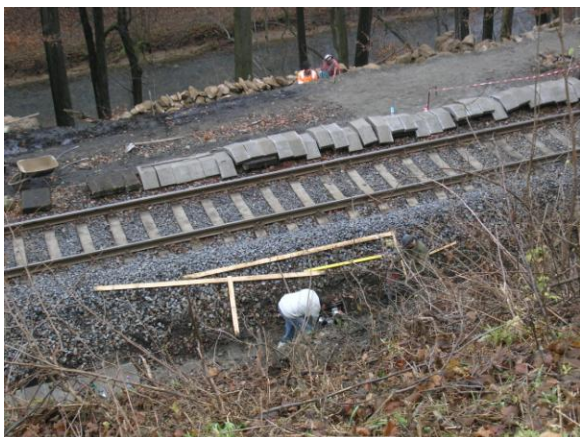
Foto 5 – Pohled na rekonstruovaný úsek železniční trati, ležící ve svahu pod poškozenou komunikací
