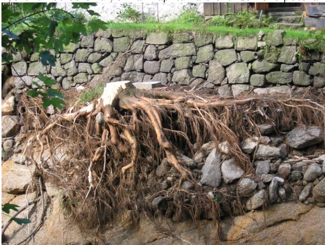
Foto 3 – Opěrná zed' s obnaženými kořeny stromu.
