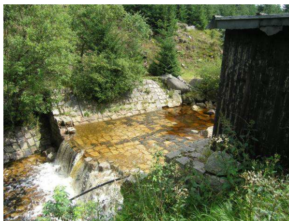
Obr. 3.15 Zničený příčný práh u limnigrafu
