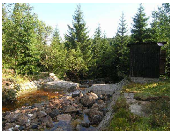
Obr. 3.12 Naplavené balvany u limnigrafu na Bílé Smědě
