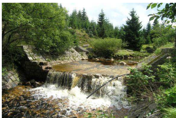
Obr. 1.3 Zničená úprava toku na Smědavě
