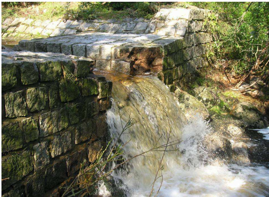
Obr. 5.3 Vytržený měrný přepad na Bílé Smědě
