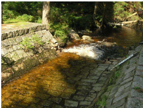
Obr. 5.1 Stržený vzdouvací objekt na Blatném potoce
