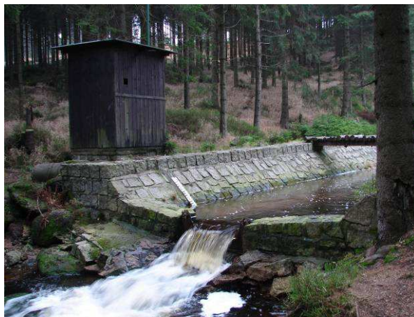
Obr. 5.2 Úprava toku před poškozením povodní
