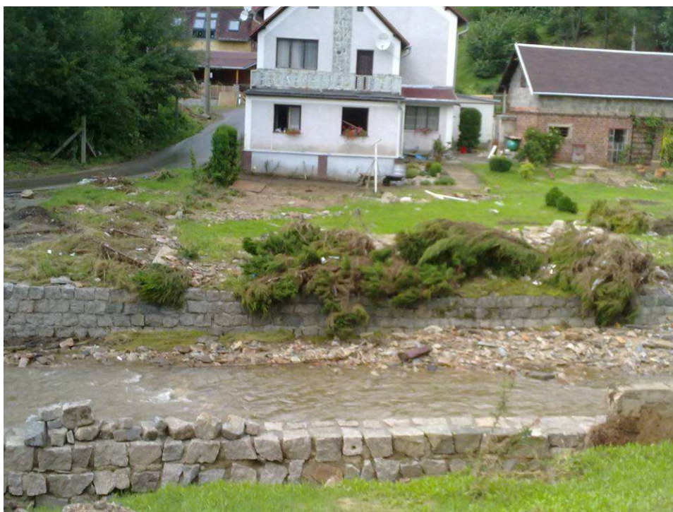
Foto 4.3 Eroze terénu za svislou opěrnou zdí a mírné nánosy v korytě
