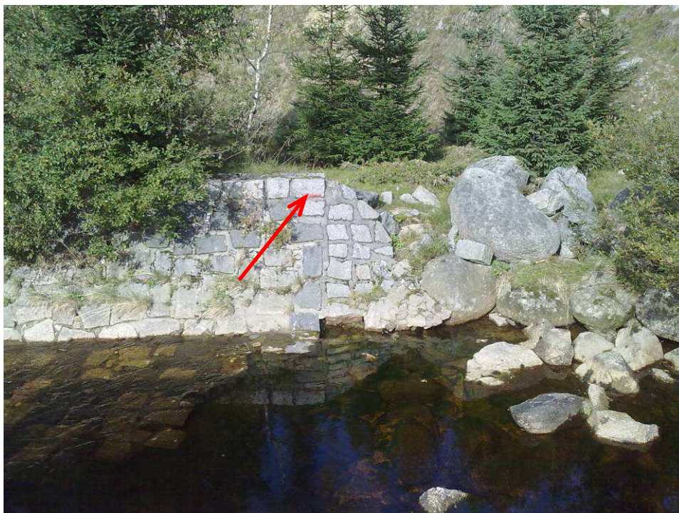
Foto 7.4 Značka stopy po kulminační hladině na břehovém opevnění v blízkosti profilu limnigrafické stanice na Smědě
