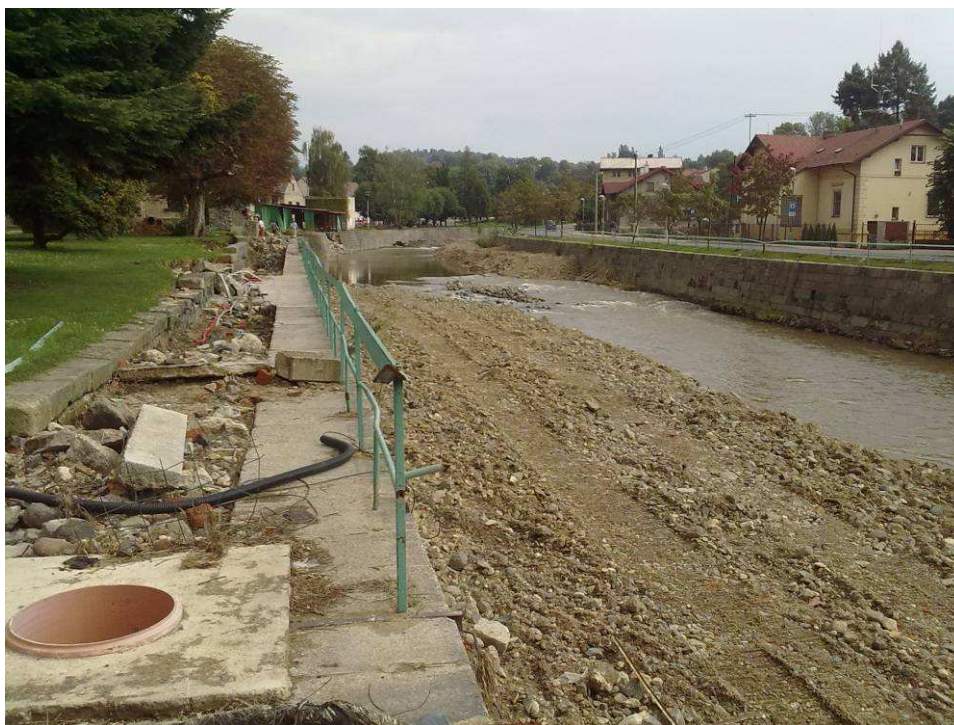
Foto 9.1 Částečně zanesené koryto Smědé se zbytkem limnigrafické stanice
