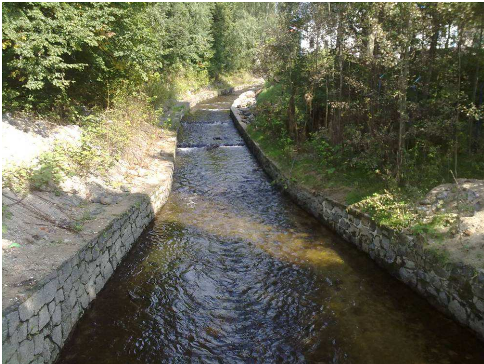
Foto 10.4 Nepoškozené upravené koryto nad mostem v ř.km 0.547.
