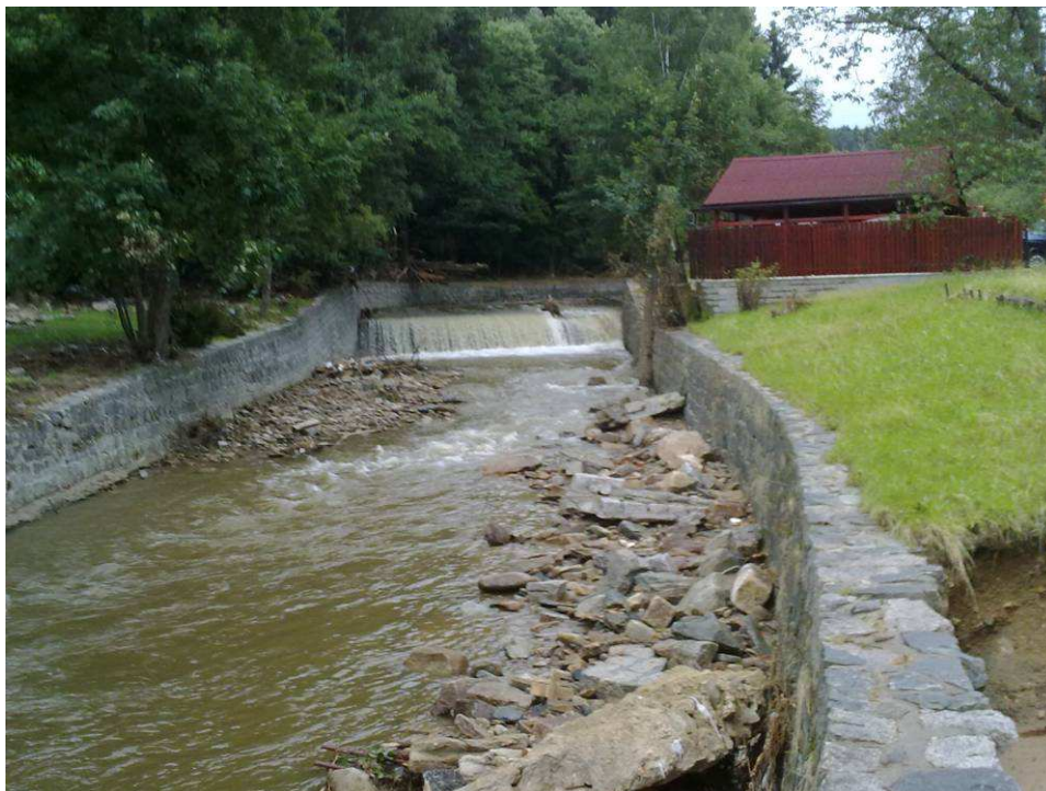
Foto 4.1 Vysoký stupeň ve dně s mírnými nánosy v podjezí
