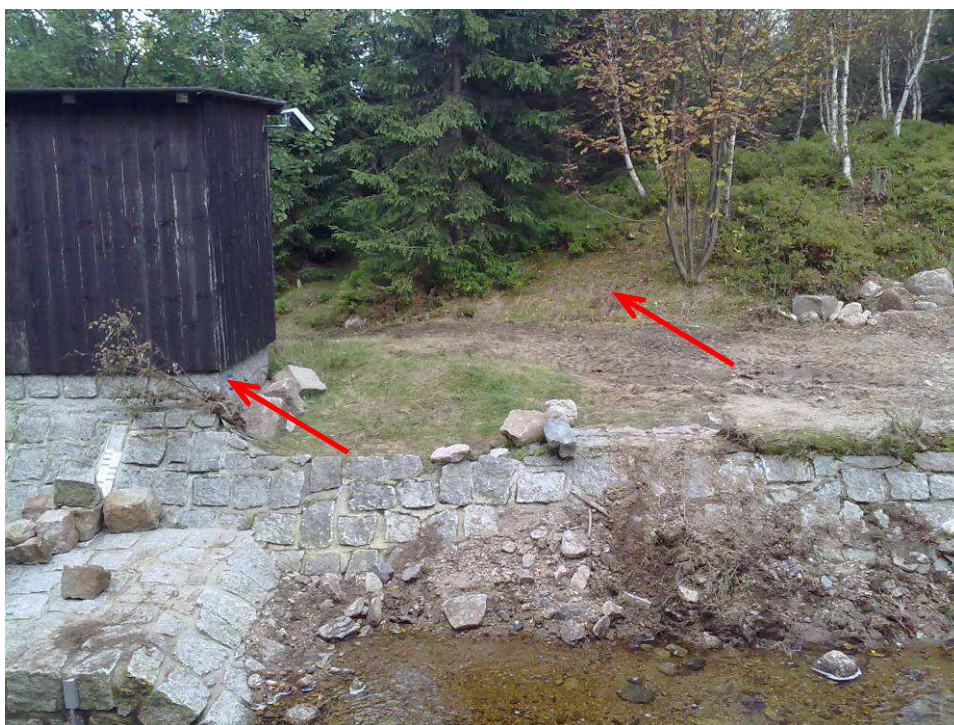
Foto 7.2 Značky stop po kulminační hladině v blízkém okolí limnigrafické stanice na Bílé Smědě
