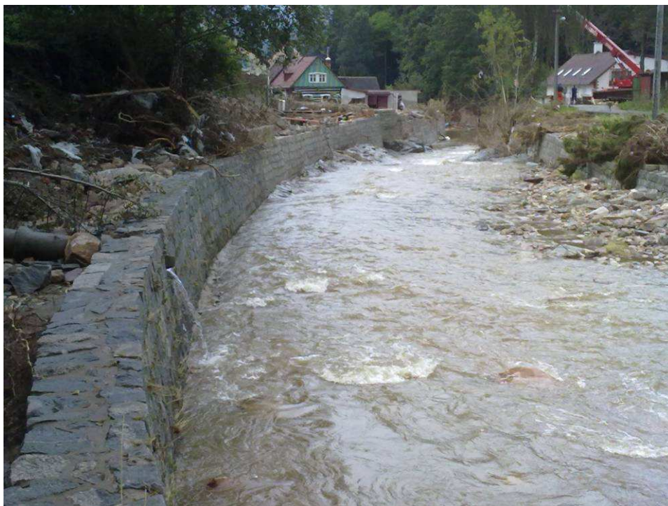
Foto 4.2 Nepoškozené opevnění úpravy Jeřice ve střední části měrné tratě
