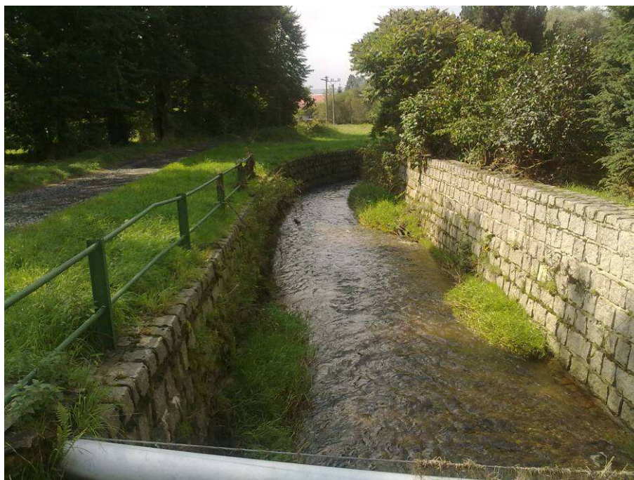
Foto 12.3 Upravené koryto Bulovského potoka v obci Předlánce těsně nad soutokem se Smědou
