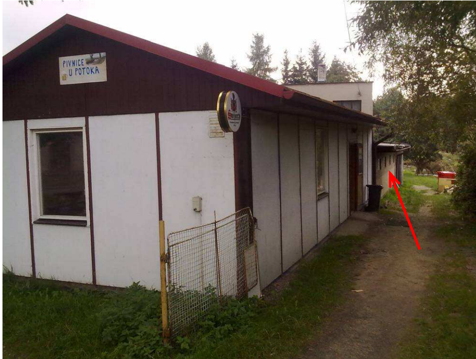
Foto 10.1 Stopa na objektu hospody pod silničním mostem
