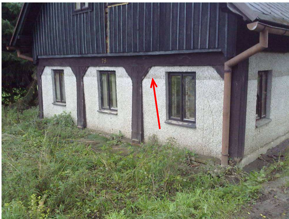
Foto 3.5 Liniová stopa na omítce rekreační chaty v dolní části posuzovaného úseku na Jeřici v obci Mníšek
