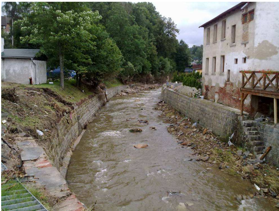
Foto 4.5 Jeřice v Chrastavě nad klenbovým mostem
