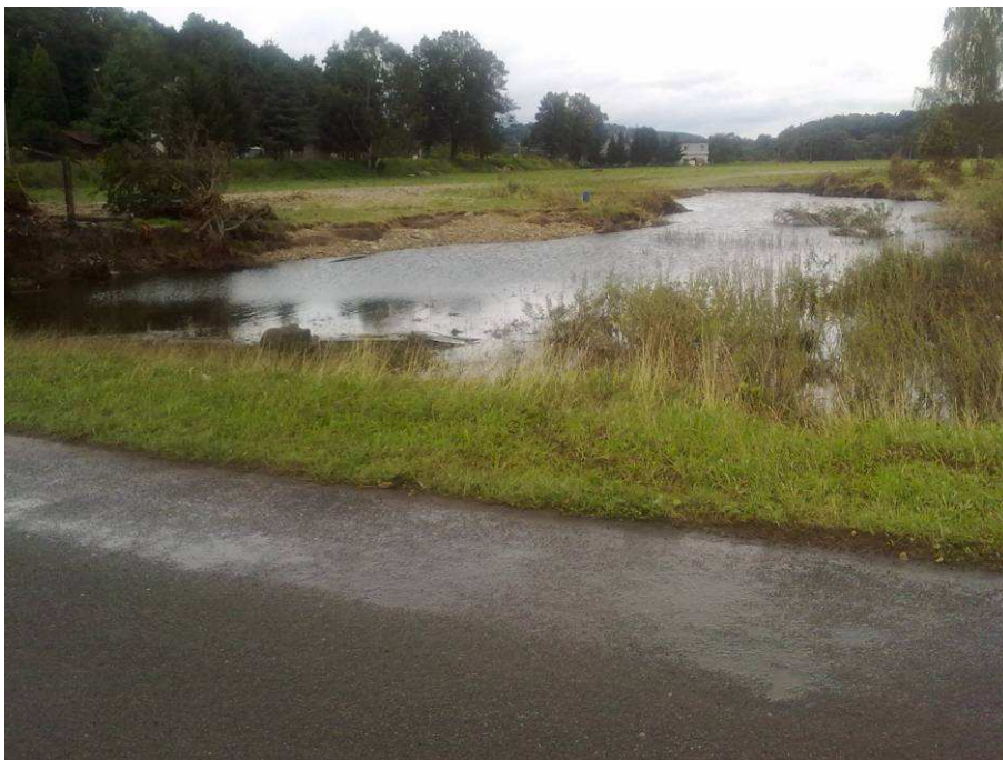
Foto 11.2 – Vymletá plocha pod místní silnicí v místě největších rychlostí vody v zaplaveném území podél obce Višňová
