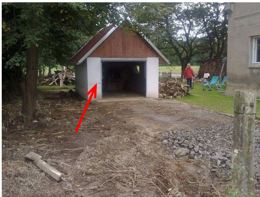
Foto 11.5 – Stopa po kulminační hladině na garáži u domu v horní části záplavového území Višňové
