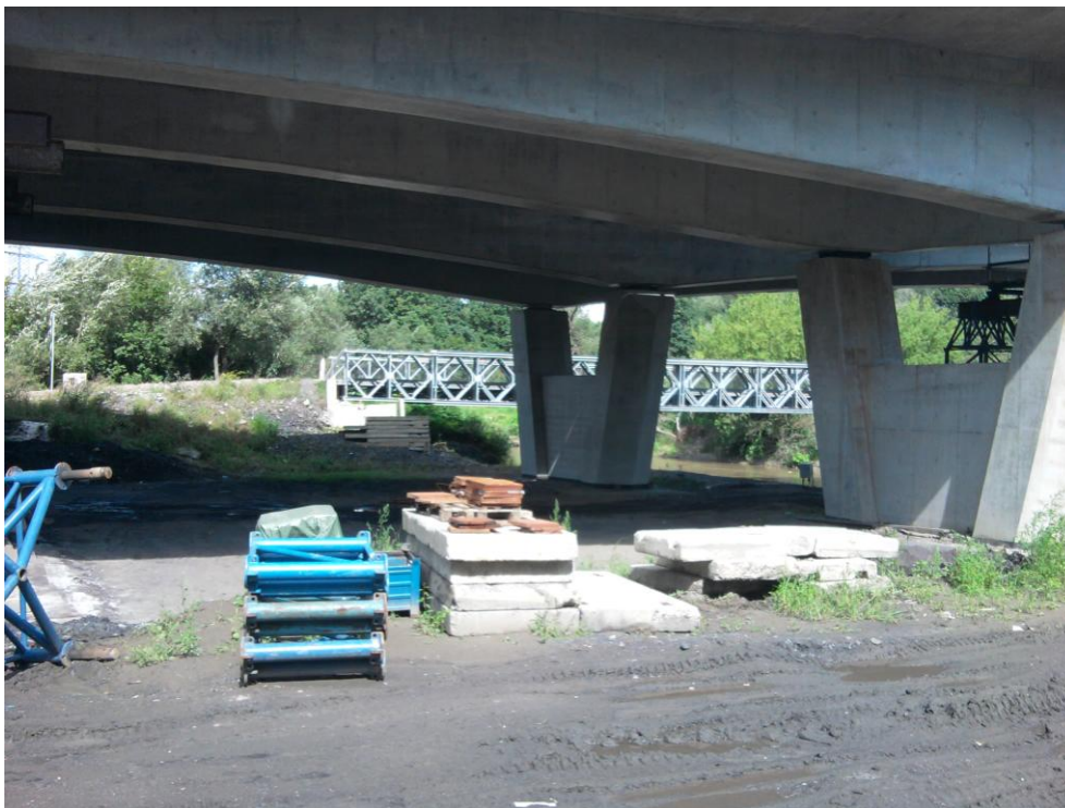
Foto 6.1 – Rozestavěný objekt dálničního mostu přes Olši s provizorním přemostěním
