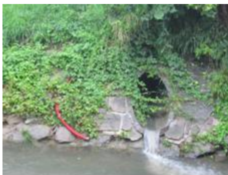
Obr. 1 Poškozená stabilizace manometrické sondy
