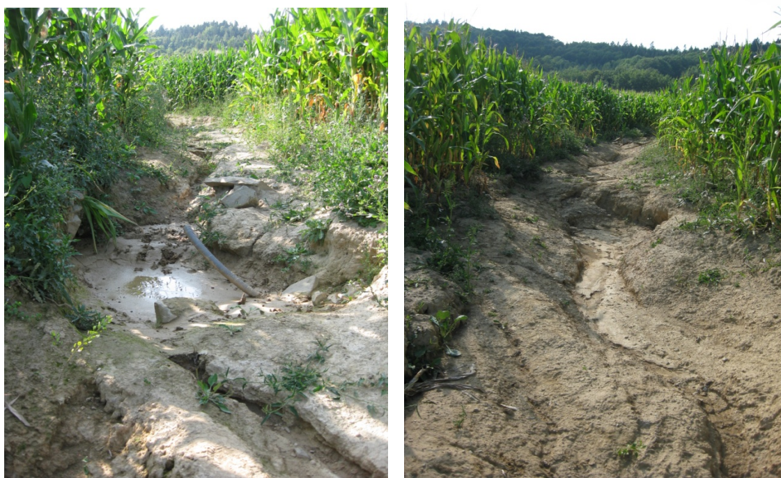
Obr. 7.1 Výrazné projevy eroze v dráze soustředěného odtoku
