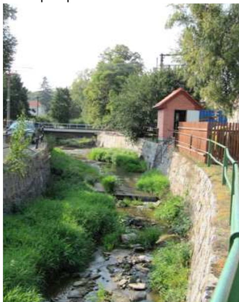
Pohled protiproudě ke stanici
