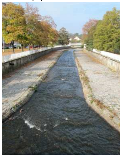
Pohled poproudě od stanice
