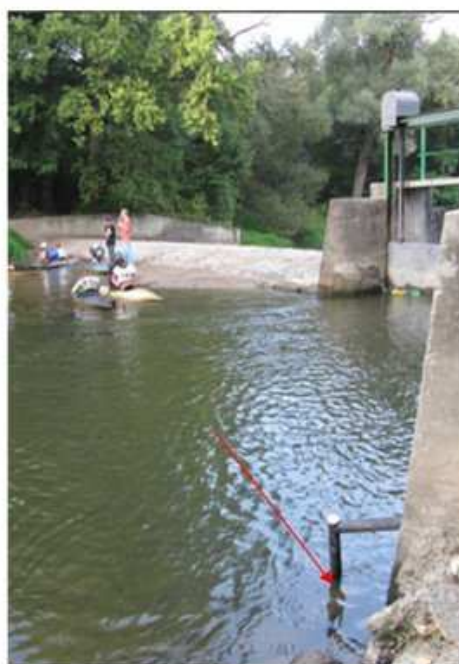
Obr.2 Manometrická sonda instalována v místě pevného přelivového jezu a pohyblivého jezu pro řízenou manipulaci
