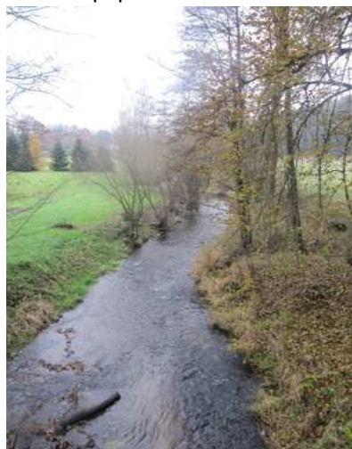
Pohled poproudě od stanice
