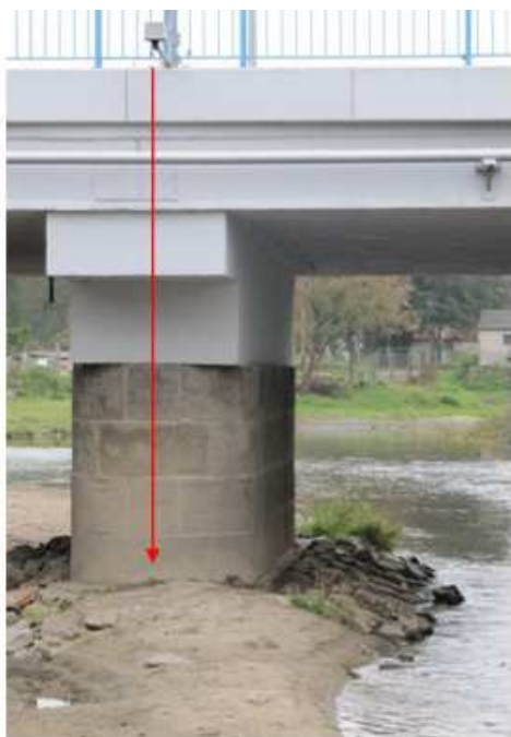
Obr. 1 Ultrazvuková sonda instalována mimo proudnici toku za odtokovou část pilíře mostu
