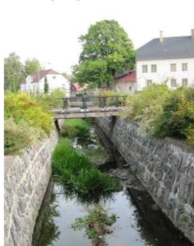
Pohled protiproudě ke stanici
