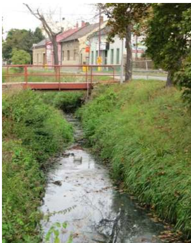
Pohled protiproudě ke stanici
