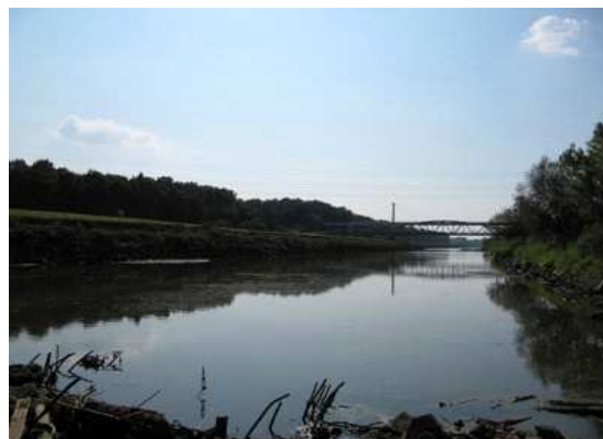
Pohled poproudě od stanice
