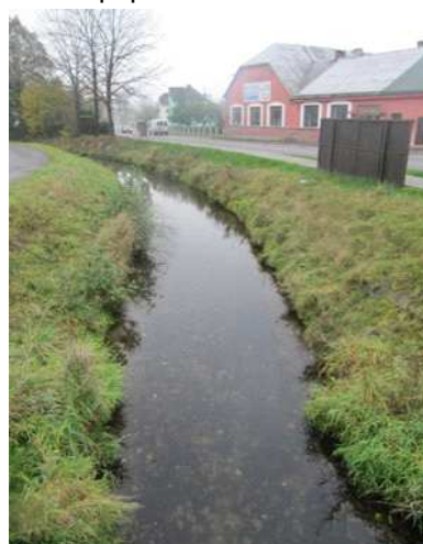
Pohled poproudě od stanice
