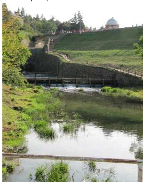
Pohled protiproudě k hrázi VD Plumlov
