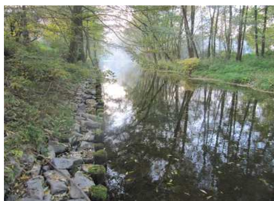
Pohled poproudě od stanice
