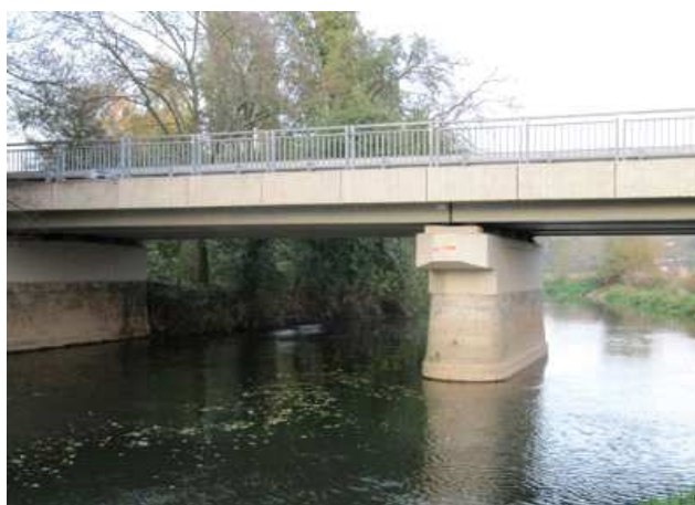
Pohled poproudě od stanice
