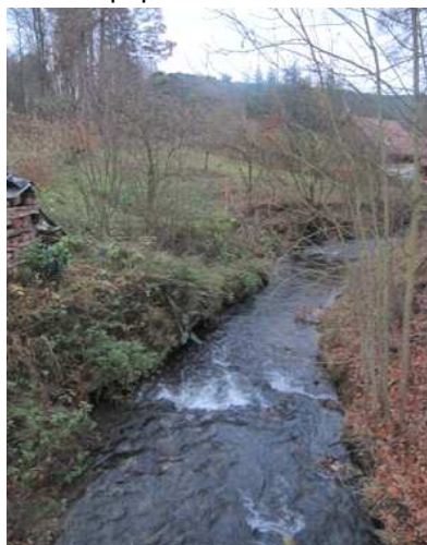
Pohled poproudě od stanice
