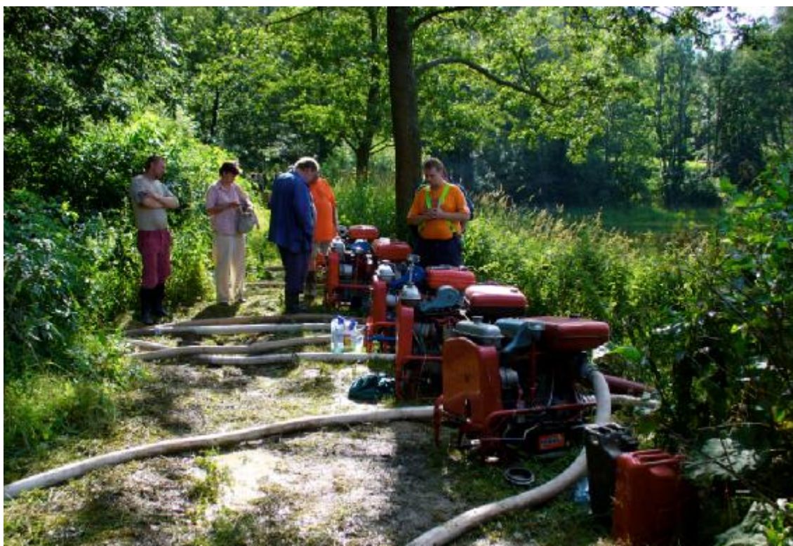
Obr. 2 – Přečerpávání vody přes korunu hráze pomocí hasičské techniky
