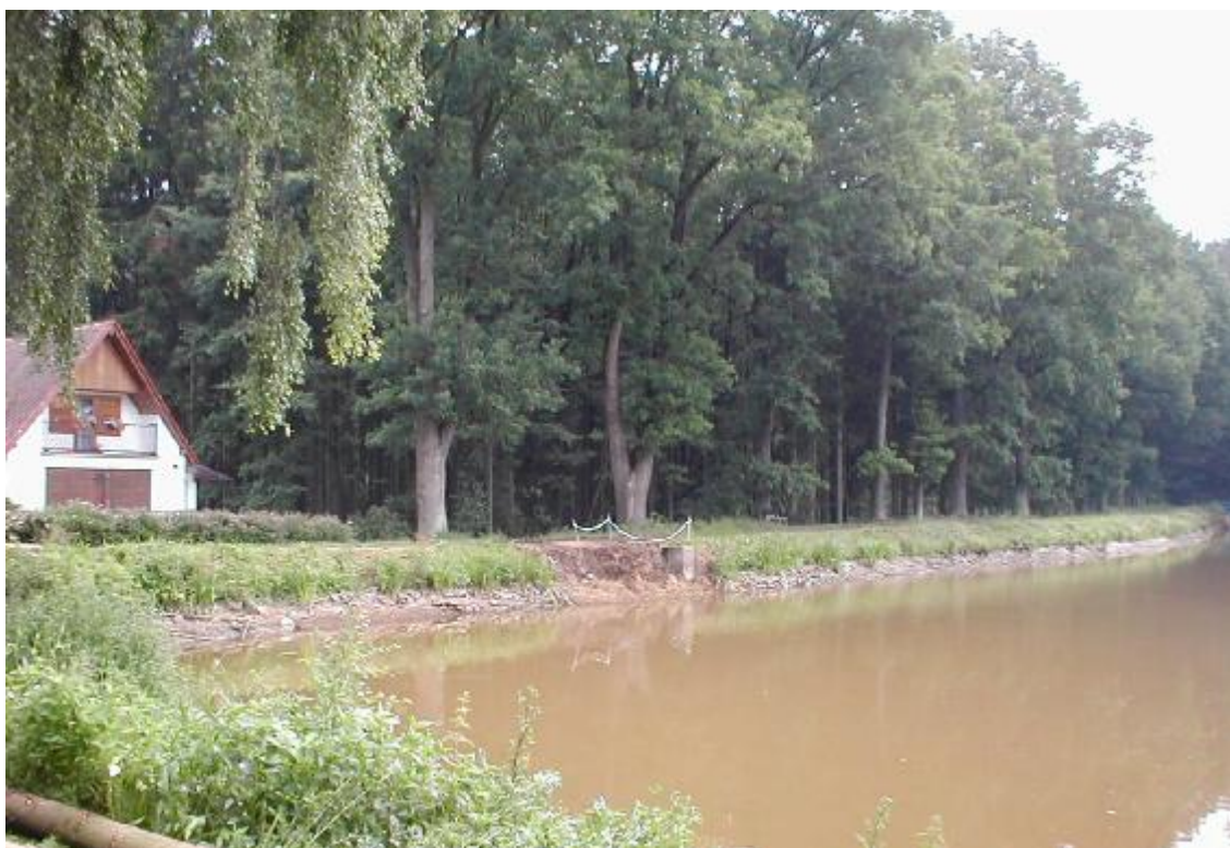
Obr. 2 – Pohled na hráz a spodní výpust
