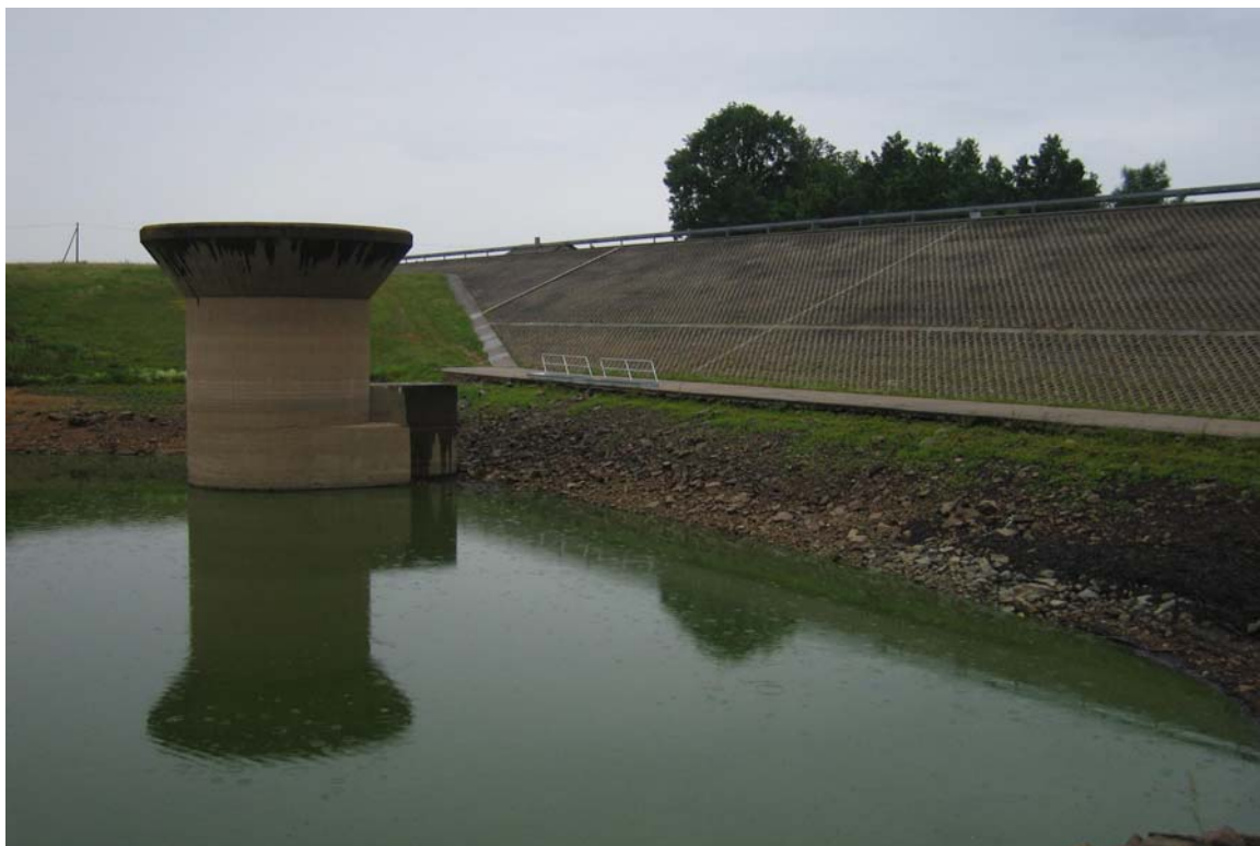
Obr. 1 – Povypuštěná nádrž před příchodem povodně
