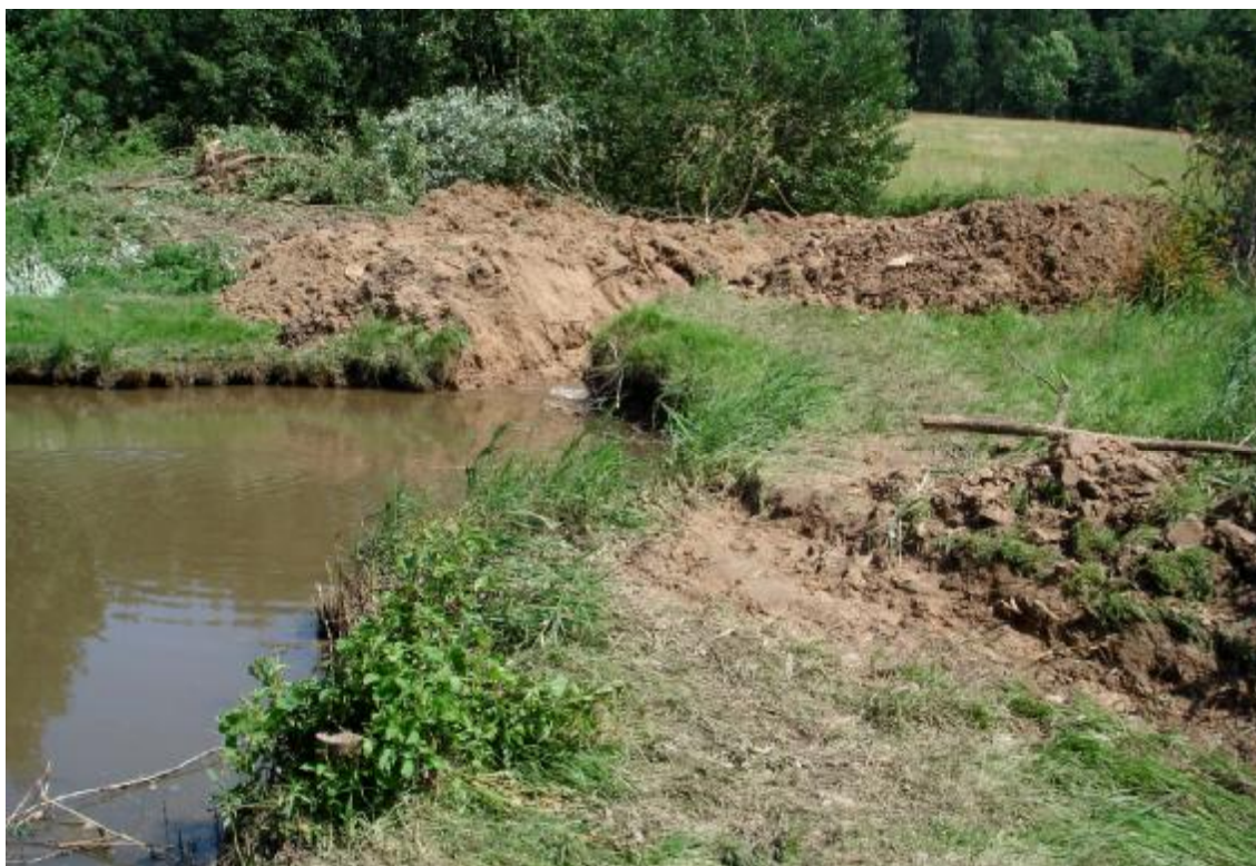
Obr. 3 – Operativní překop levého zavázání tělesa hráze
