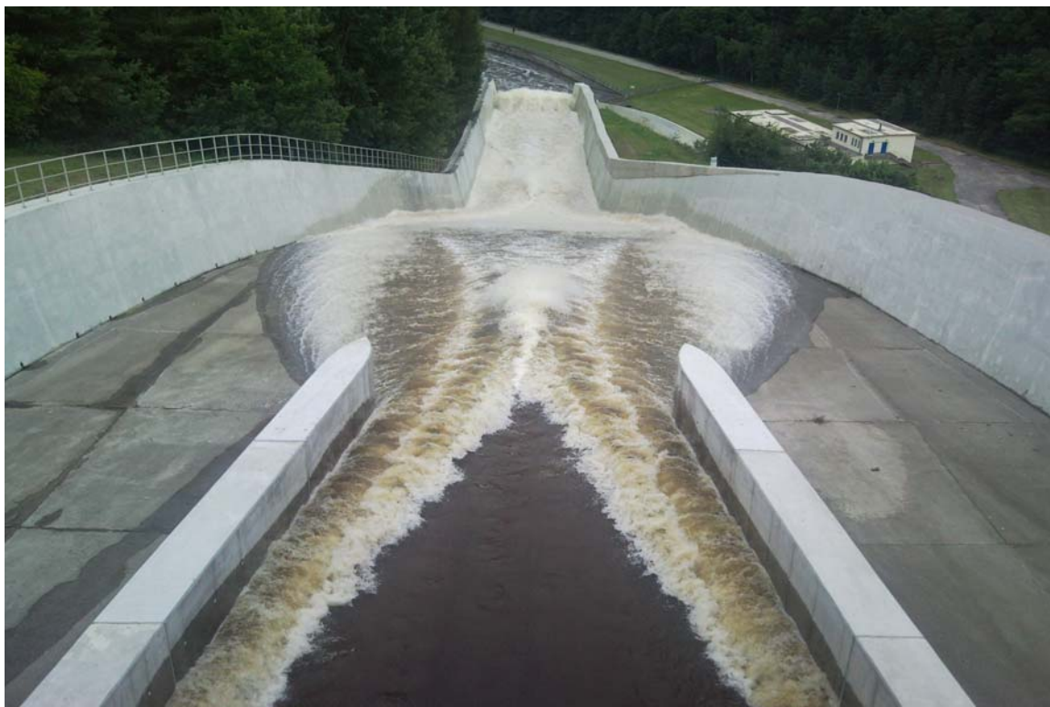
Obr. 1 – Převádění 35 \text{ m}^3 \cdot \text{s}^{-1} středním polem (usměrňovací pilíře vybudované v rámci rekonstrukce v roce 2008)
