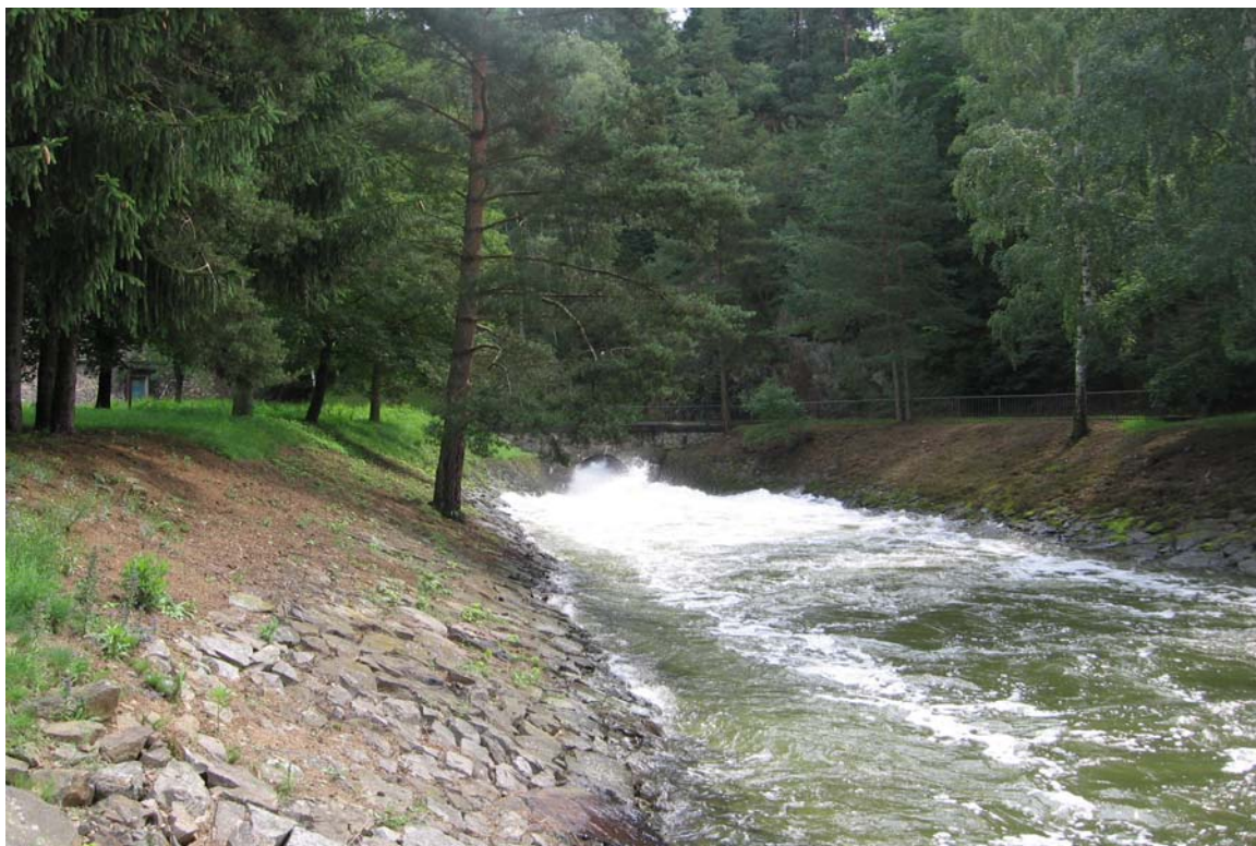
Obr. 3 – Vyústění odpadní štolý od spodní výpusti, odpadní koryto před napojením do řeky Oslavy, Q = 18 \text{ m}^3 \cdot \text{s}^{-1}
