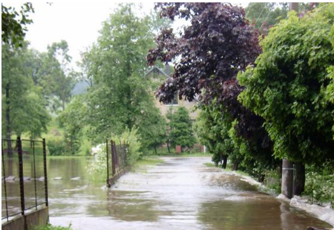
Obr. 1 – Přelévání hráze při povodni
