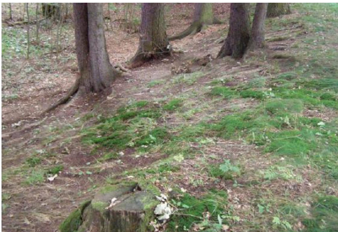
Obr. 2 – Místo přelévání koruny hráze v její střední části
