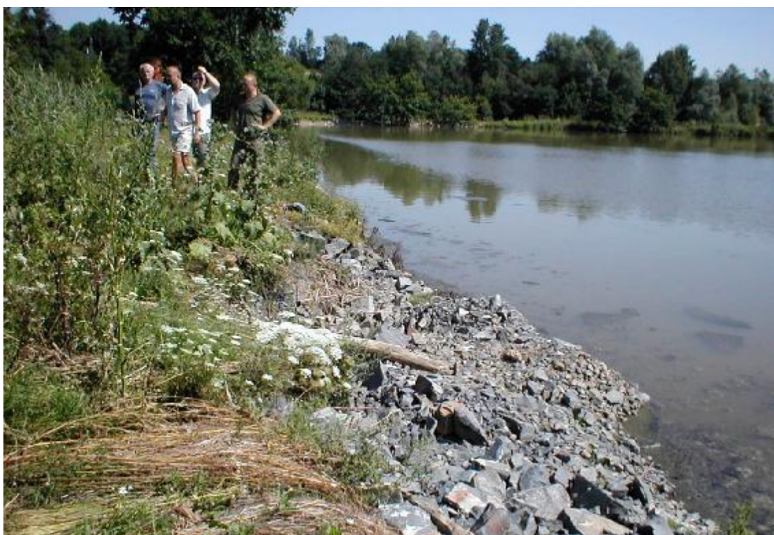
Obr. 3 – Poškození opevnění
