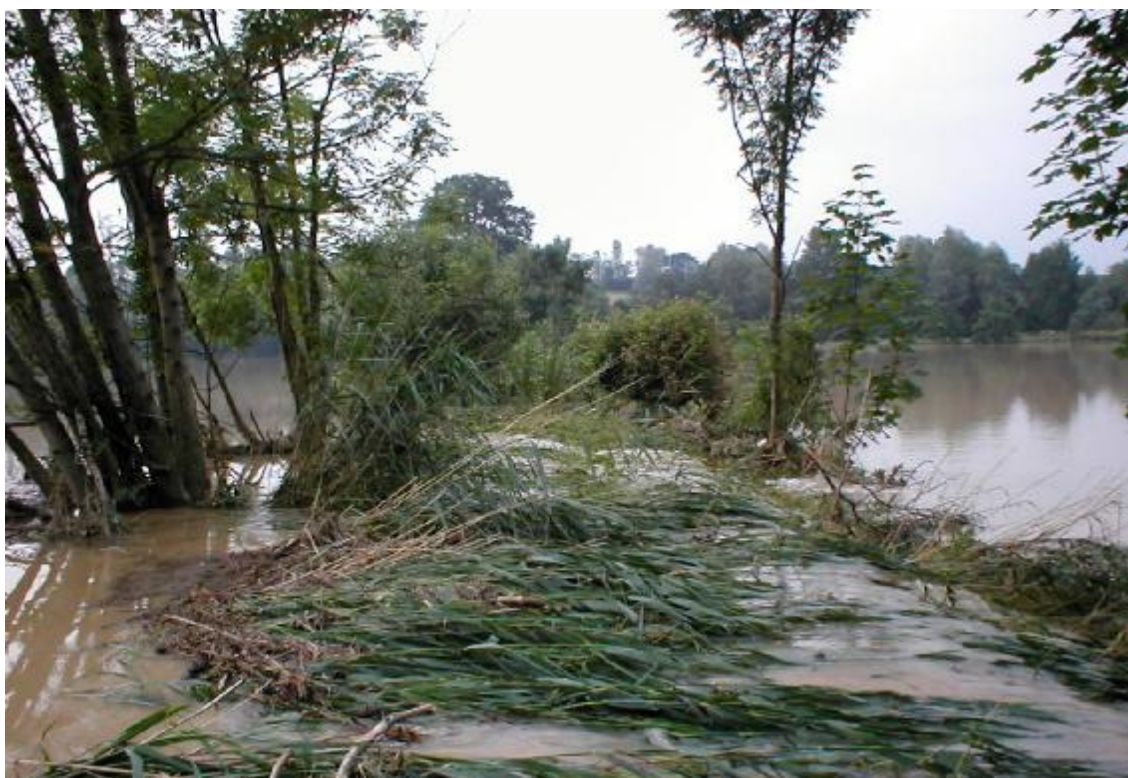
Obr. 4 – Přelévání hráz při povodni
