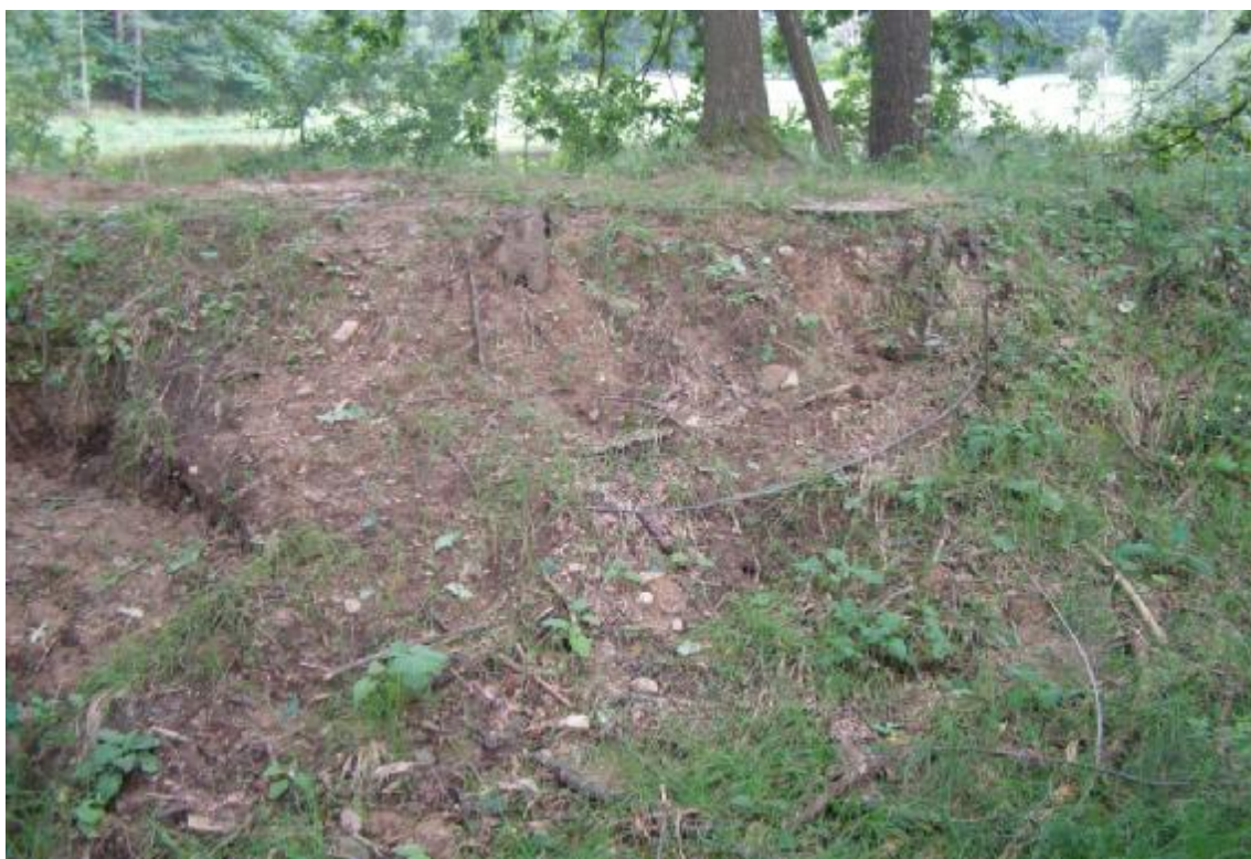
Obr. 2 – Pohled na střední část hráze proti vodě
