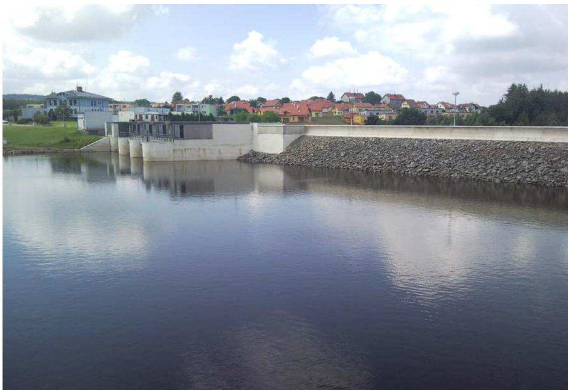
Obr. 2 - Pohled na bezpečnostní přeliv a zvýšení koruny hráze vlnolamem propojeným s těsnicím prvkem hráze (vybudované v rámci rekonstrukce v roce 2008)
