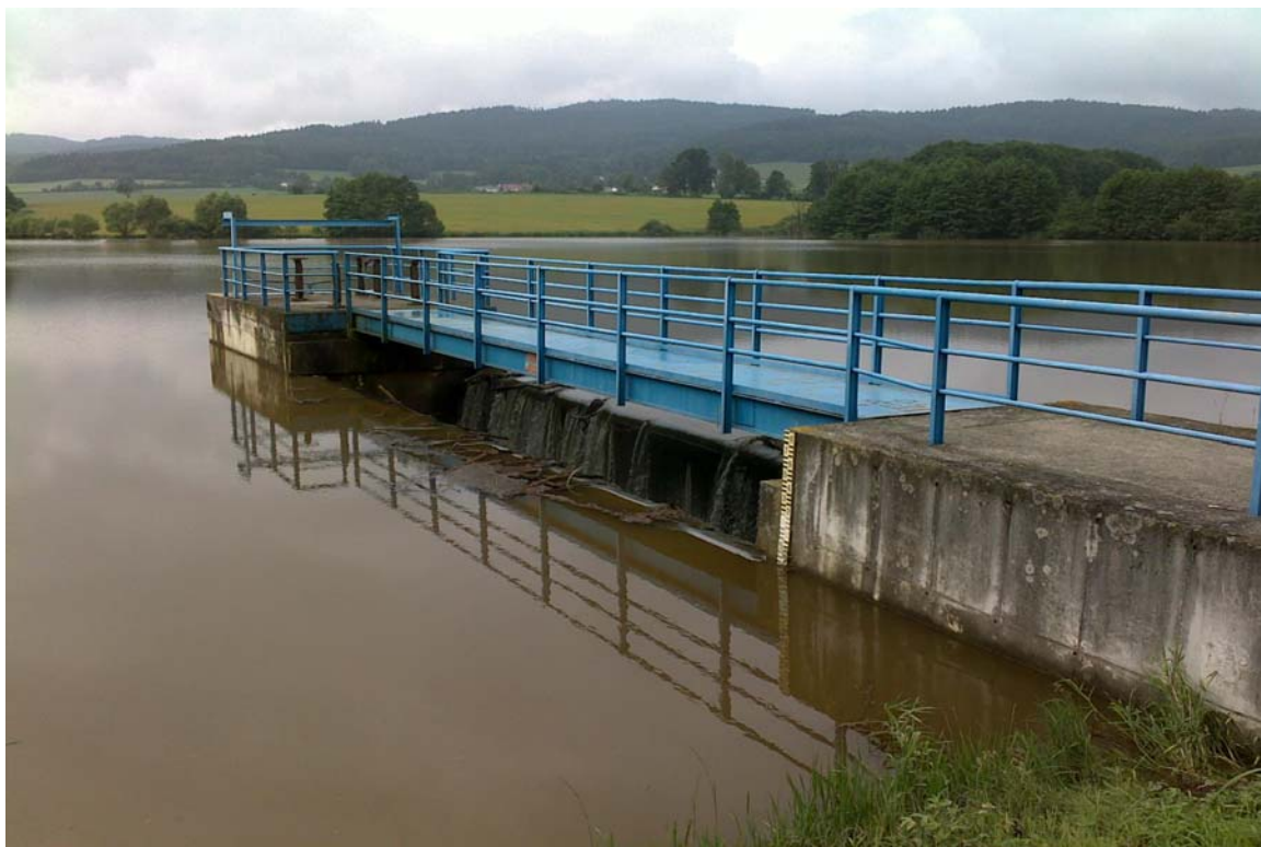
Obr. 1 – Pohled na sdružený funkční objekt
