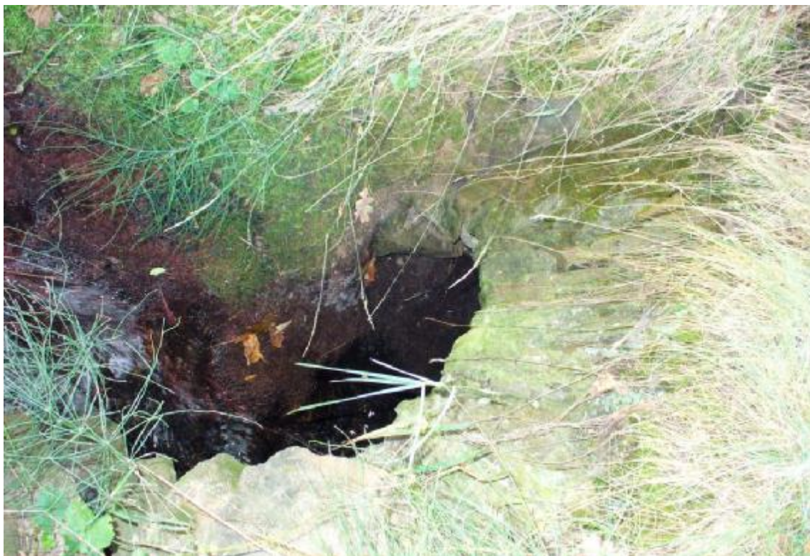
Obr. 4 – Propustek na odpadu od bezpečnostního přelivu
