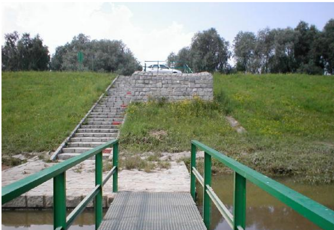
Obr. 4 – Pohled na bezpečnostní přeliv
