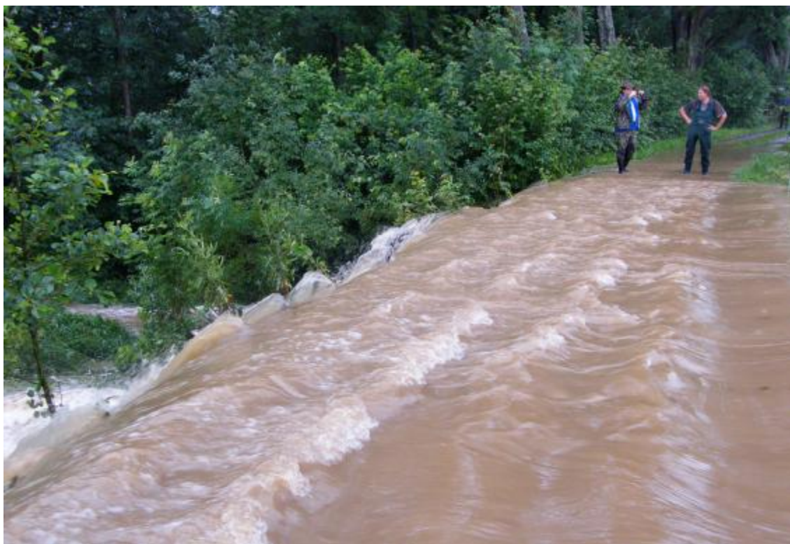
Obr. 3 – Přelévání hráze v profilu spodní výpusti, foceno od levého konce hráze
