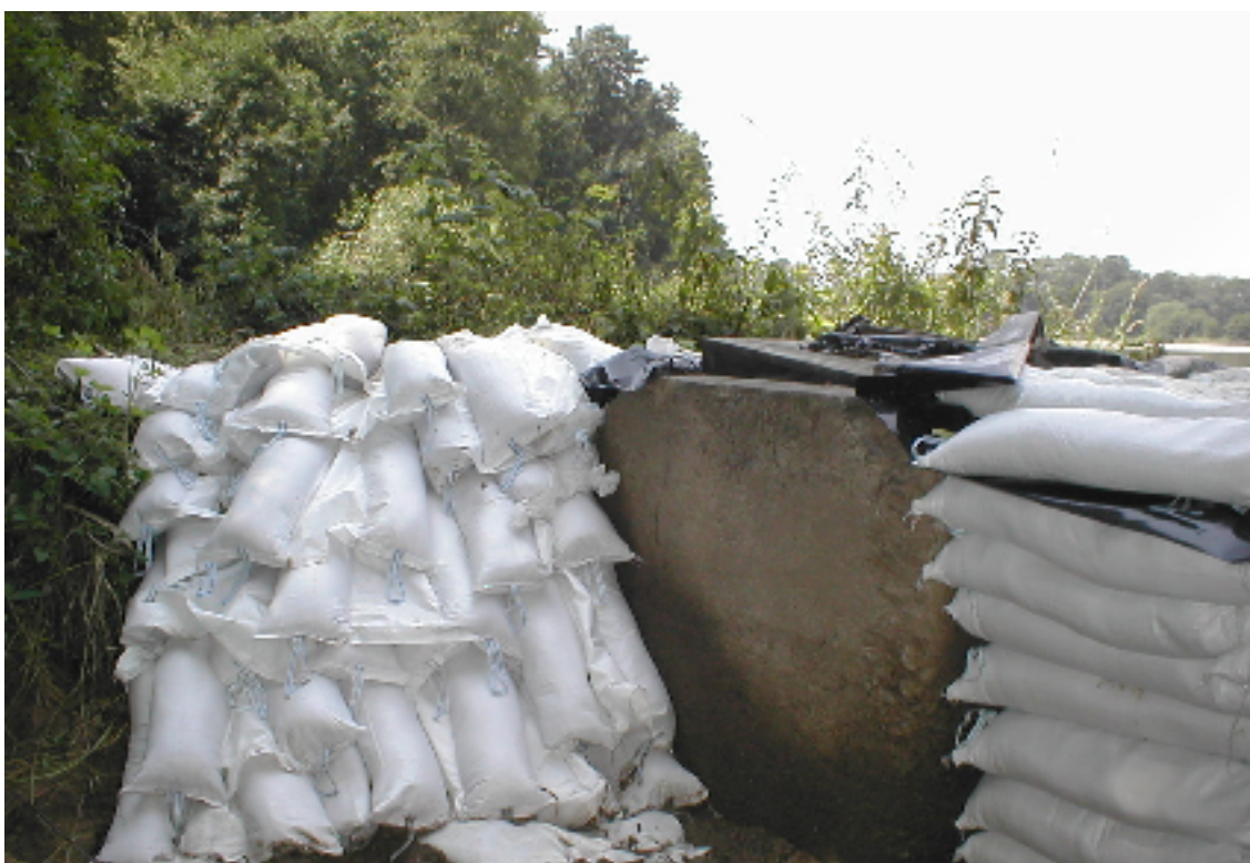
Obr. 2 – Sanace poškozené hráze provedená pytlí s pískem a PVC folií
