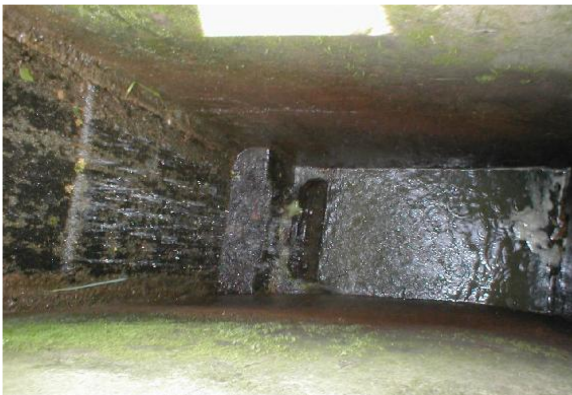
Obr. 4 – Záslepovací příruba na výtokovém potrubí
