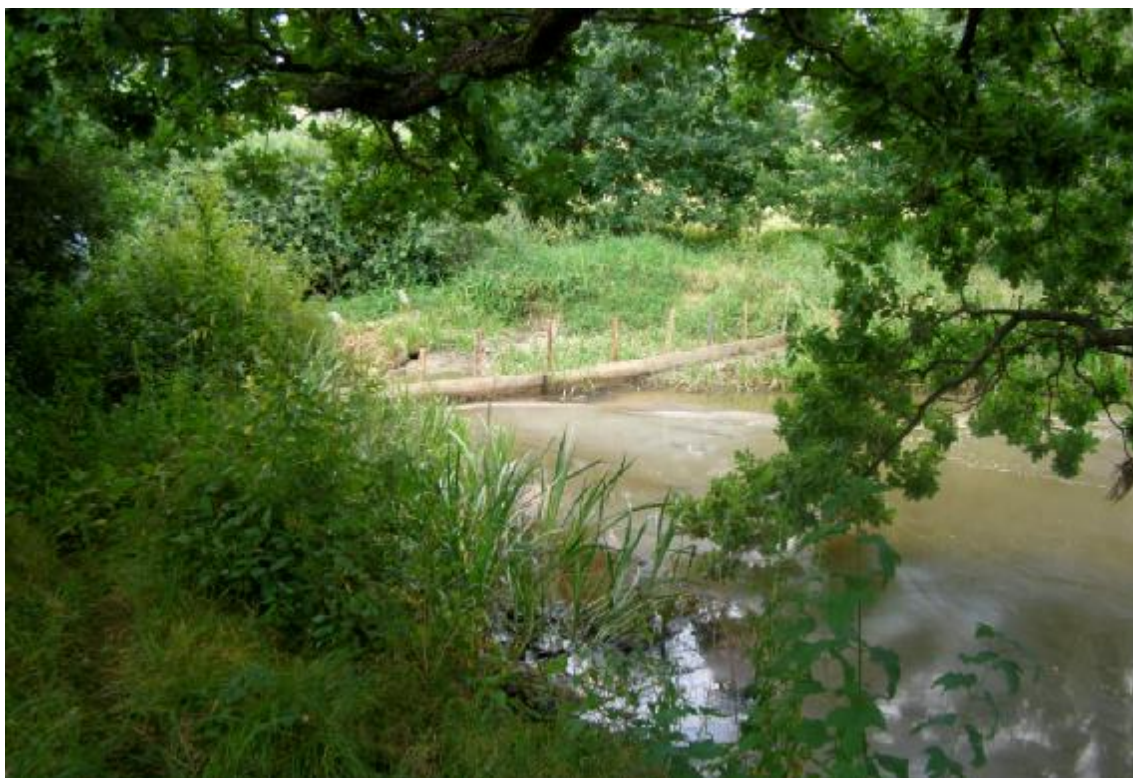
Obr. 1 – Provizorní oprava bezpečnostního přelivu
