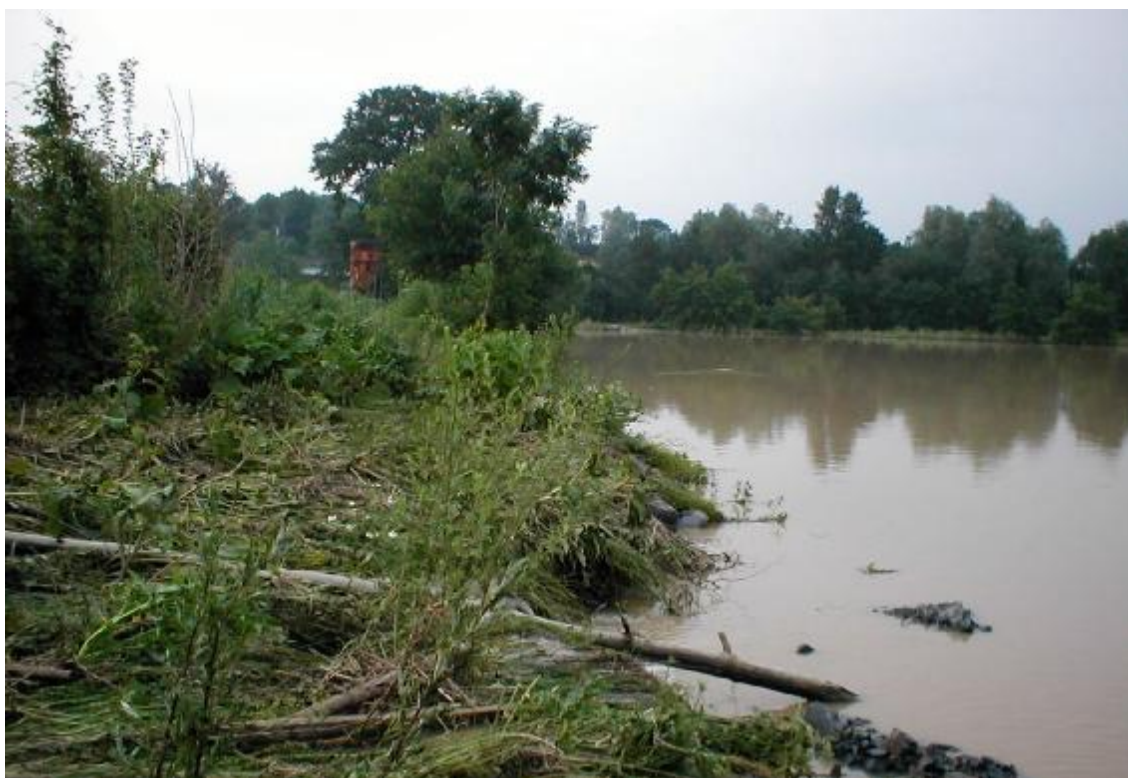
Obr. 2 – Přelévaná hráz mezi rybníky
