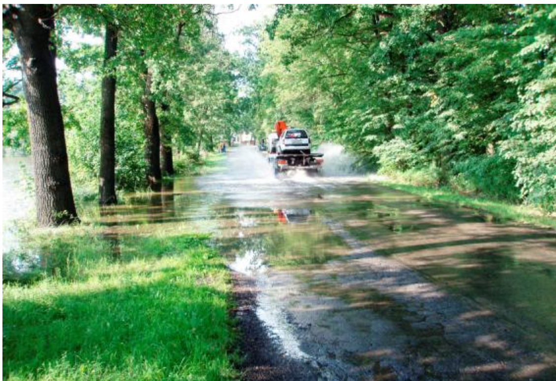
Obr. 2 – Přelévání hráze v oblasti výpusti, pohled od pravého konce hráze
