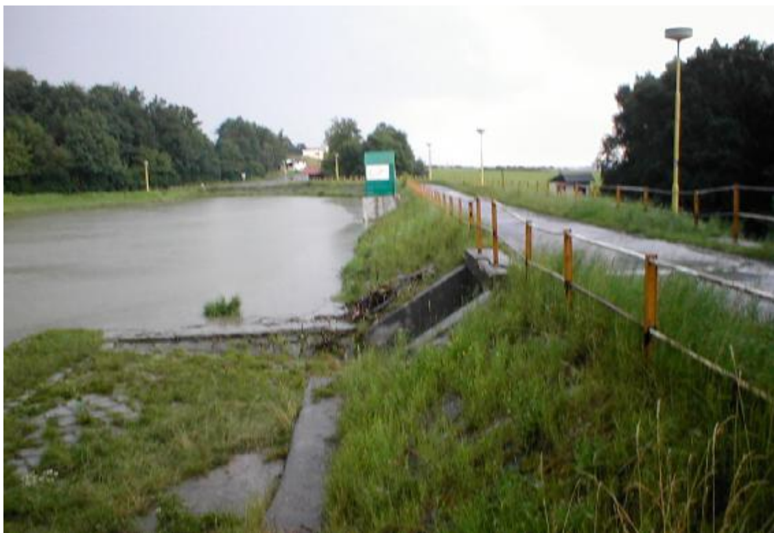
Obr. 1 – Pohled na hráz
