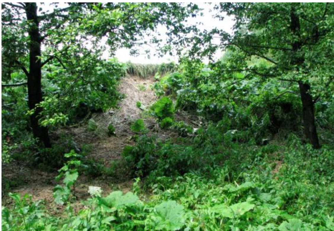
Obr. 1 – Erozní rýha na vzdušném svahu
