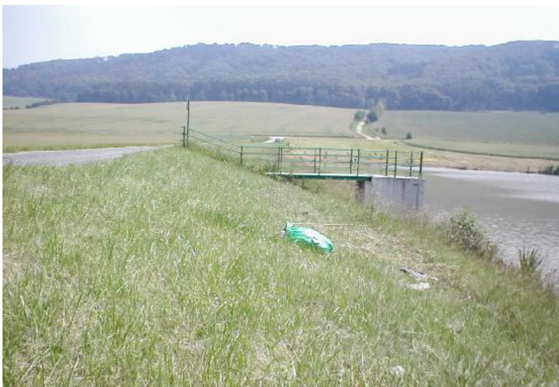
Obr. 1 – Pohled na hráz a spodní výpust
