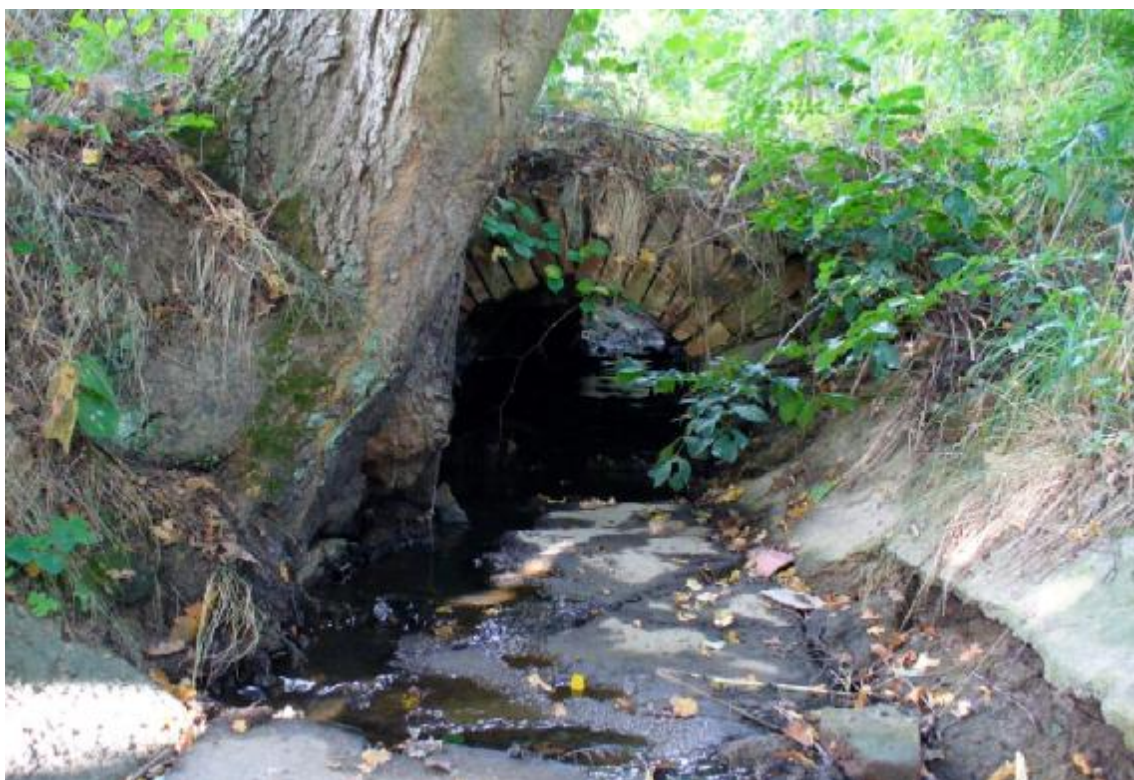
Obr. 4 – Propustek na odpadu od bezpečnostního přelivu
