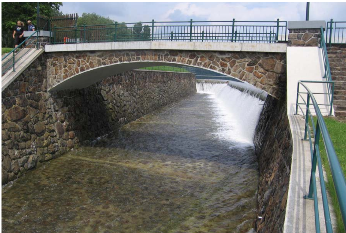
Obr. 1 – Pravostranné zavázání hráze, bezpečnostní přeliv, spadiště, přemostění, skluz, Q = 2 \text{ m}^3 \cdot \text{s}^{-1}
