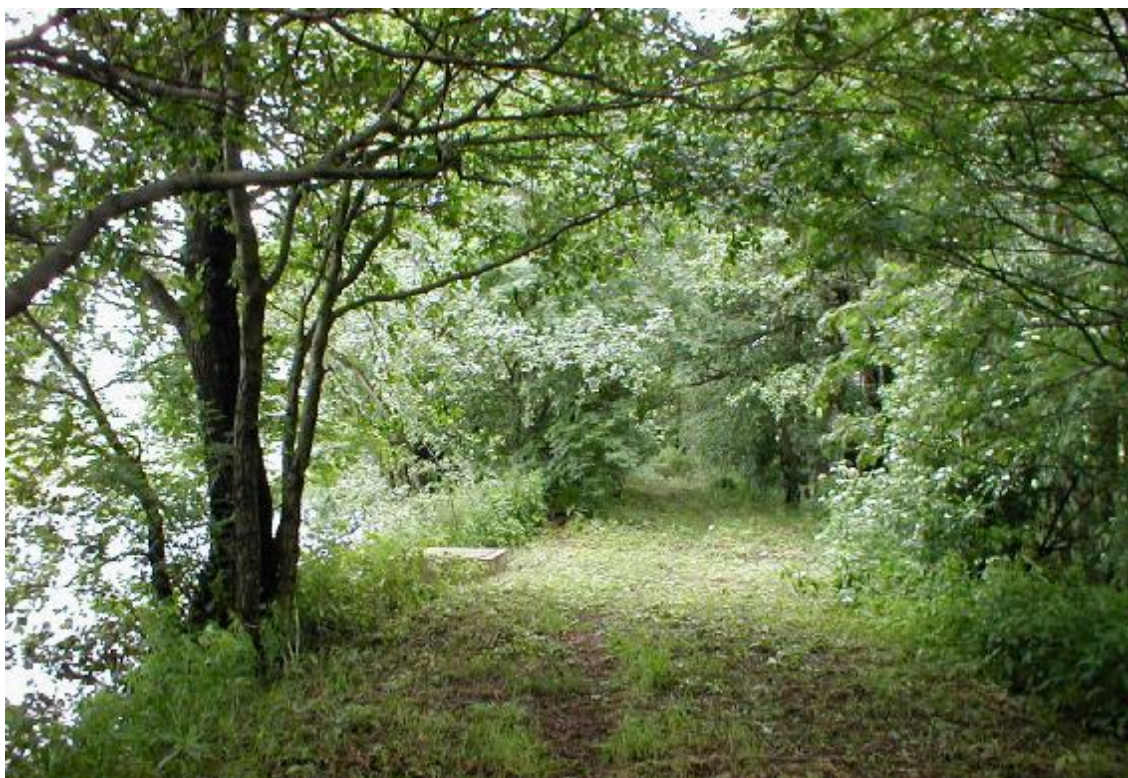
Obr. 1 – Koruna hráze u požeráku
