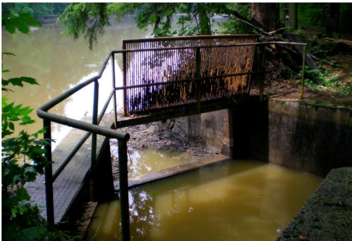
Obr. 4 – Vyhrazená česlová stěna před manipulovatelným přelivem v levém zavázání hráze po povodni
