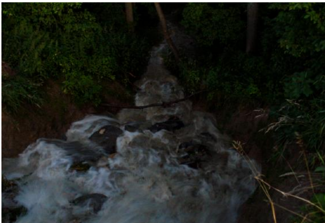
Obr. 3 – Průtok průrvou v místě prohrábky – maximální odtok z rybníka
