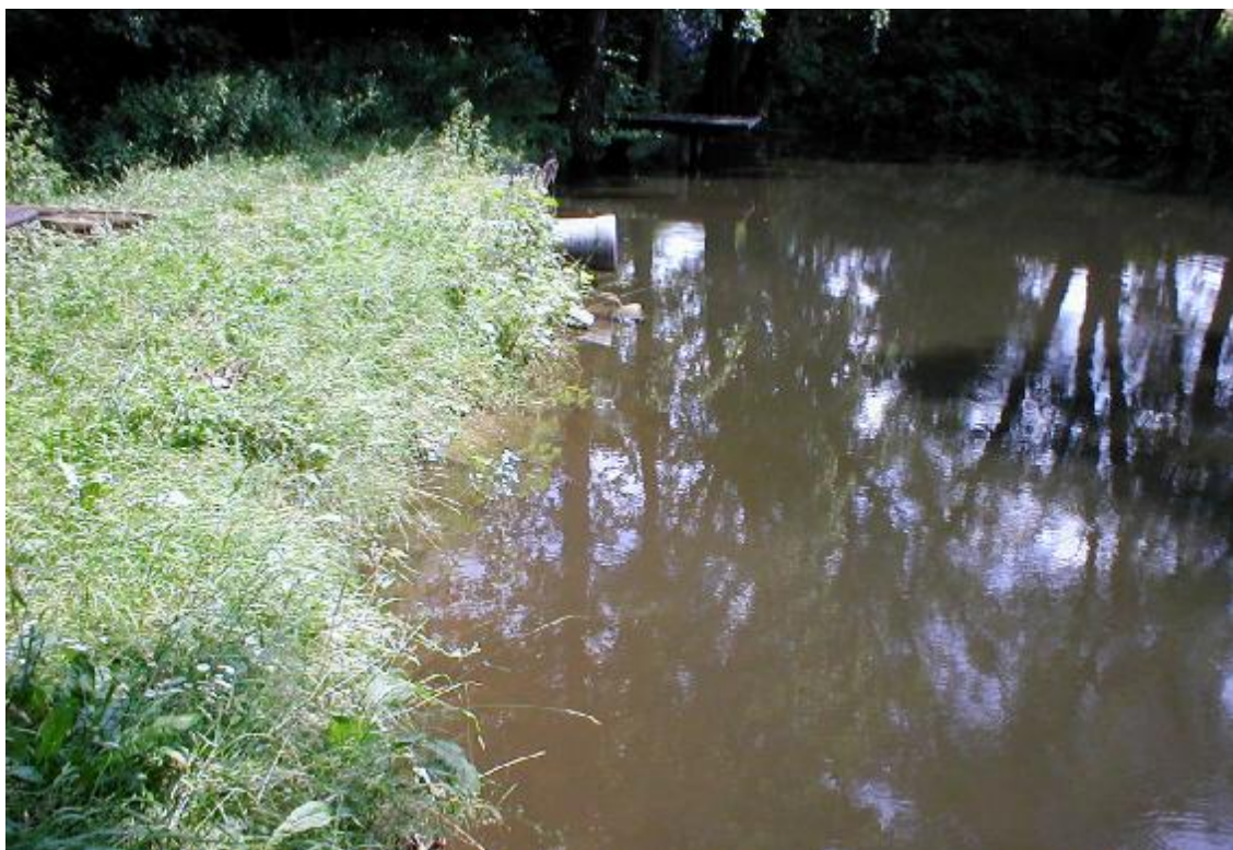
Obr. 1 – Hráz a bezpečnostní přeliv
