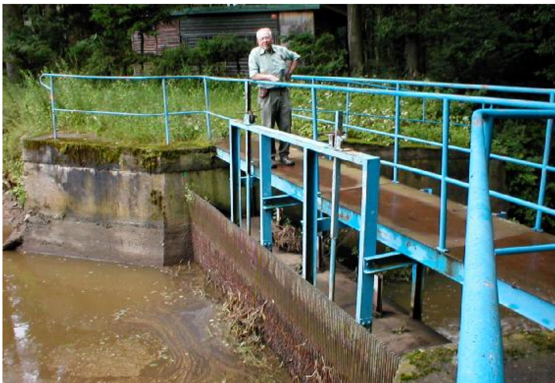
Obr. 3 – Bezpečnostní přeliv po povodni
