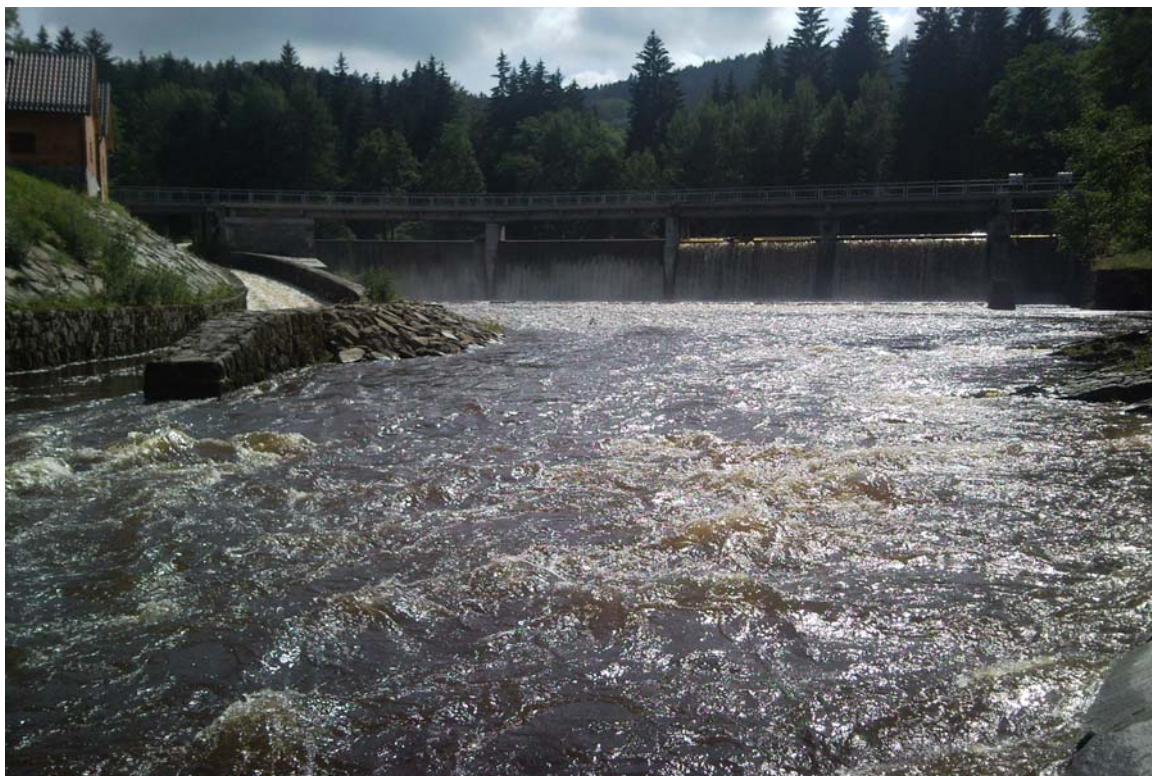
Obr. 1 – Zleva: vorová propust, dvě nová přelivná pole, dvě původní přelivná pole, šterková propust.
