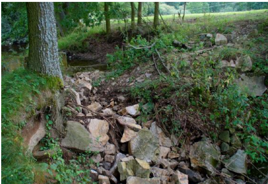
Obr. 1 – Pohled na bezpečnostní přeliv proti vodě
