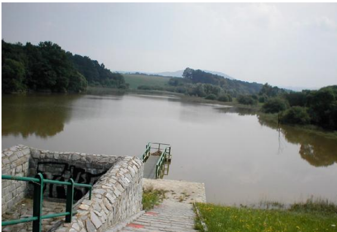
Obr. 1 – Pohled do nádrže – přeliv a spodní výpust
