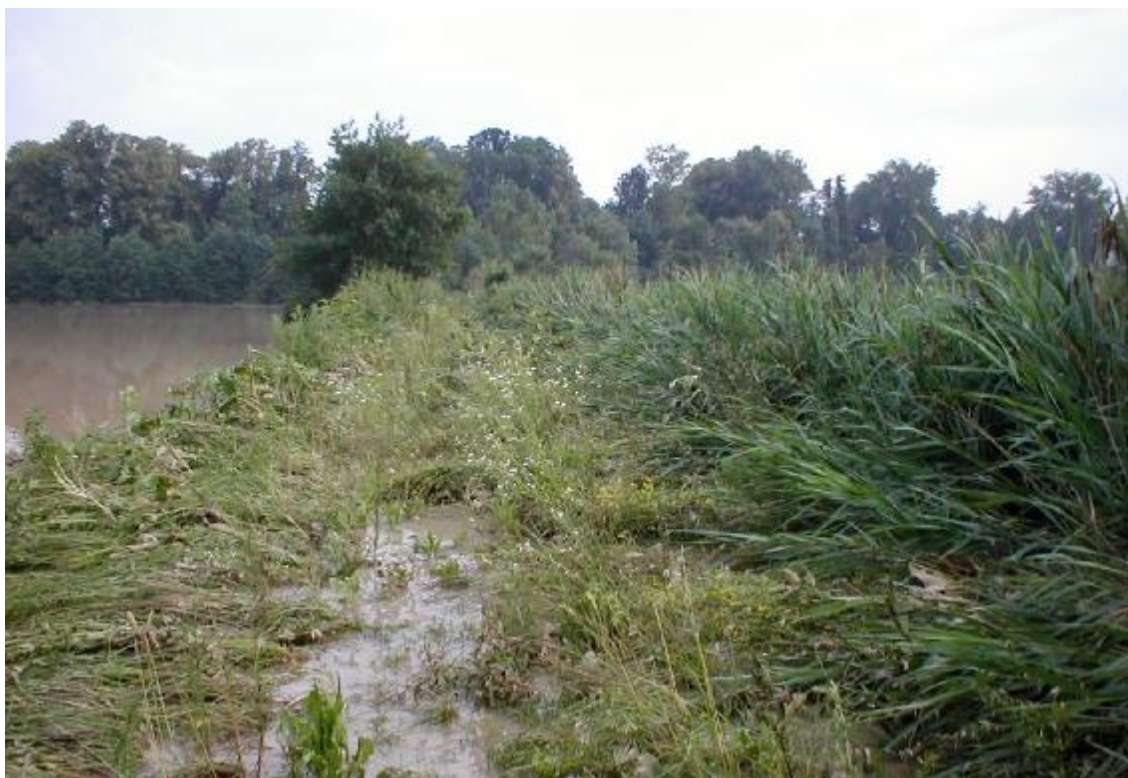
Obr. 1 – Přelévaná hráz mezi rybníky
