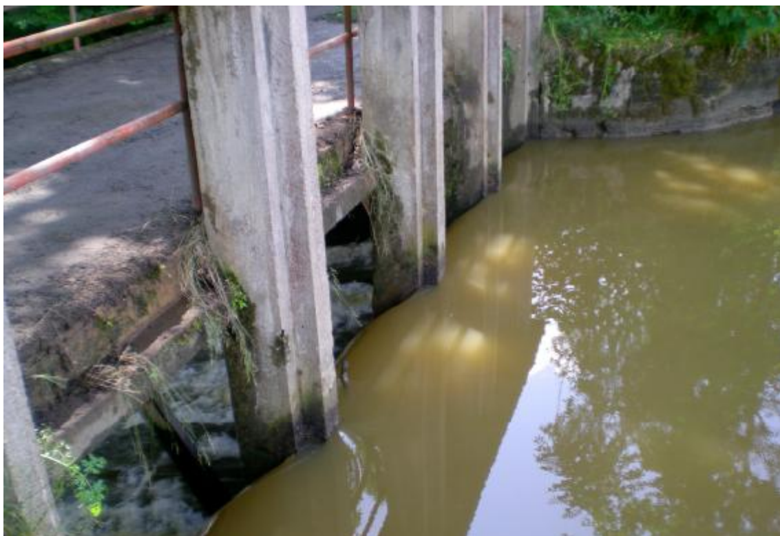
Obr. 2 – Hrazený bezpečnostní přeliv v pravém konci hráze
