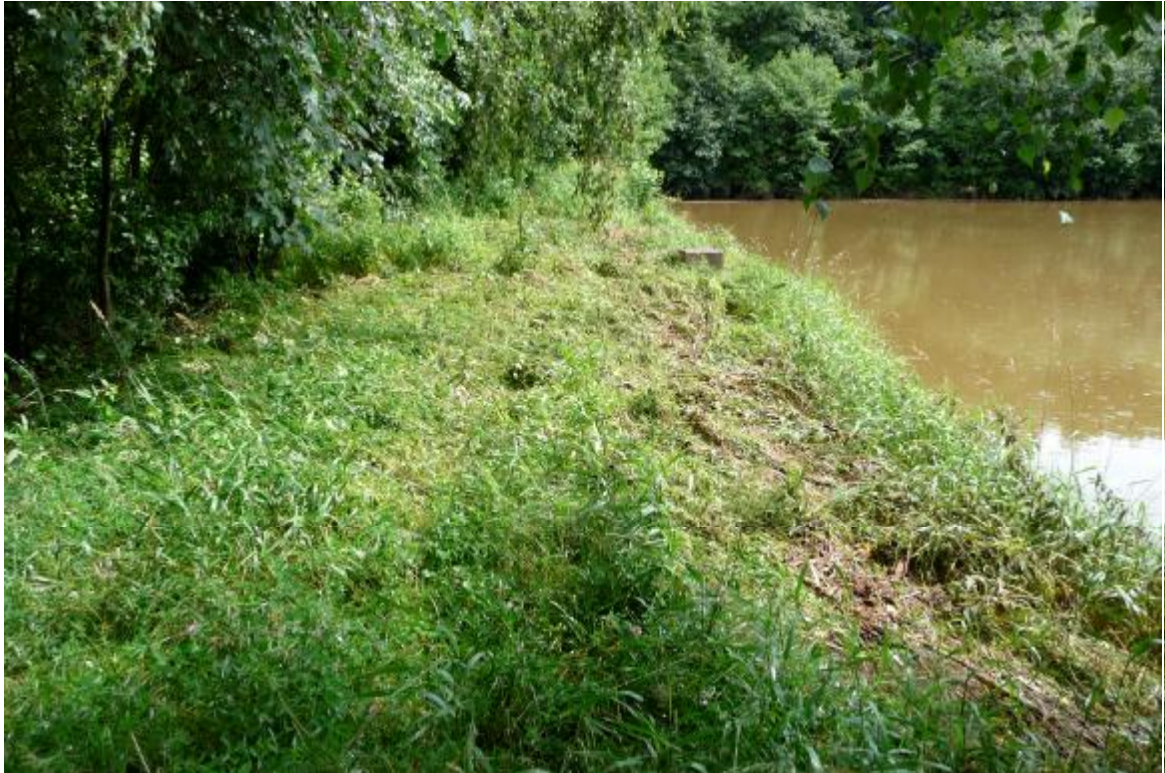
Obr. 3 – Pohled na místo přelítí vlevo od spodní výpusti
