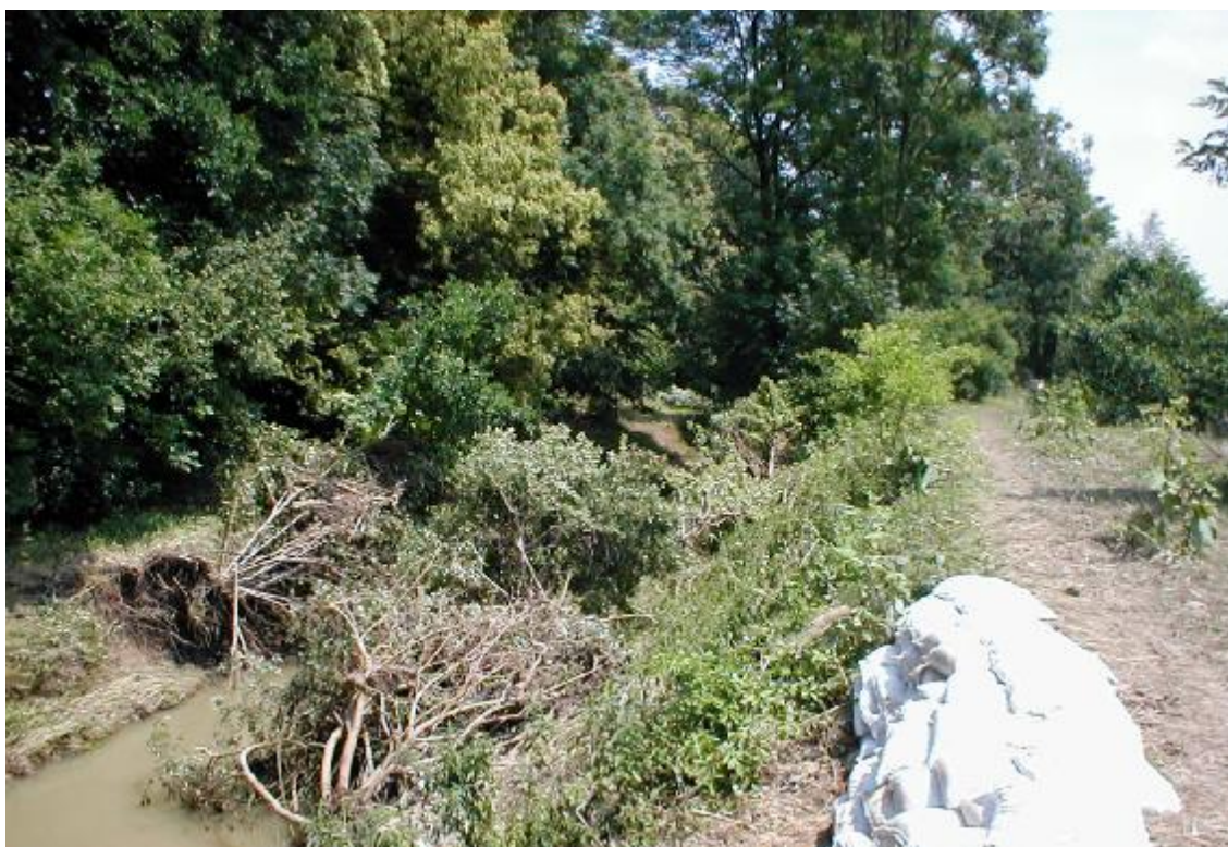
Obr. 4 – Poškozený svah vývratem stromu a přelitím
