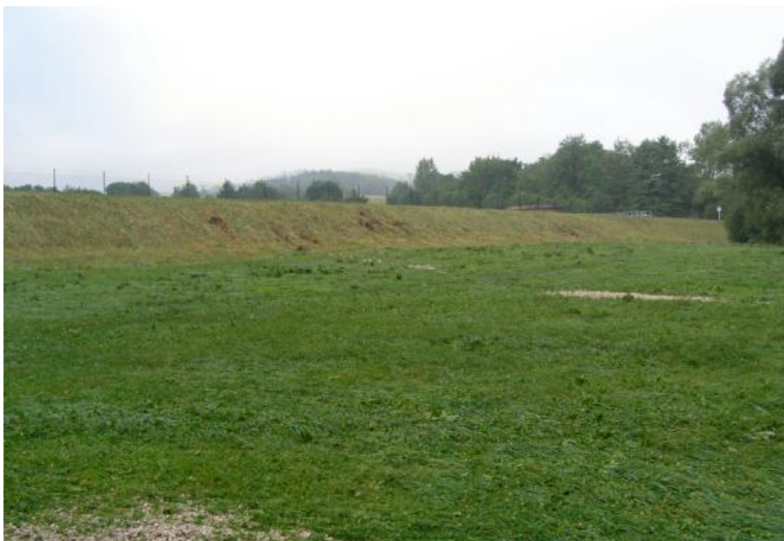
Obr. 2 – Přelitý vzdušný svah nádrže
