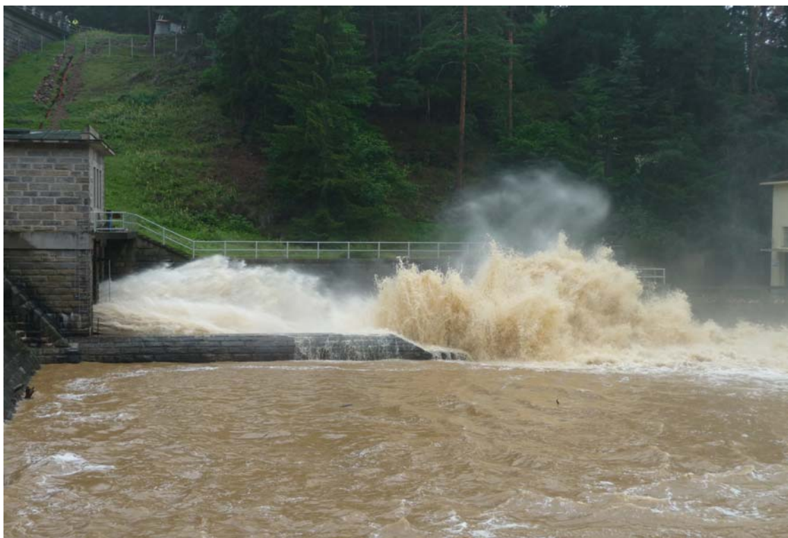
Obr. 4 – Pohled na levou stranu na výtok ze spodní výpusti Q = 40 \text{ m}^3 \cdot \text{s}^{-1} .
