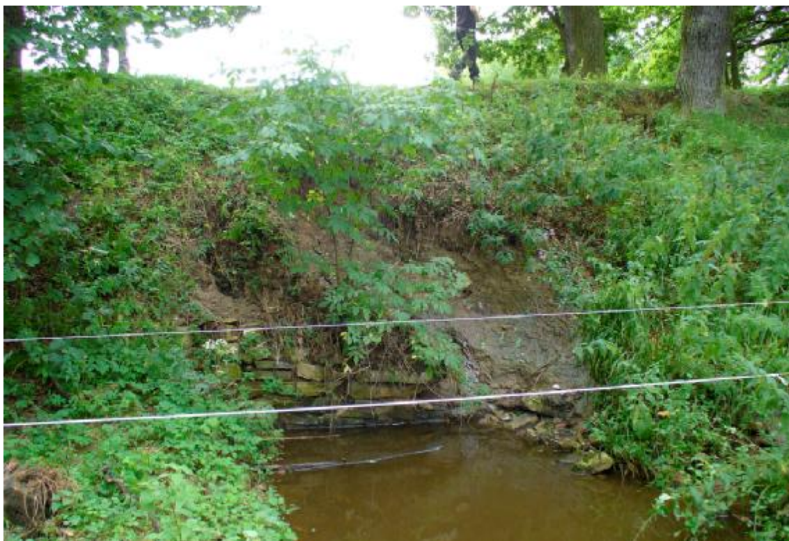
Obr. 3 – Pohled na hráz v profilu spodní výpusti proti vodě
