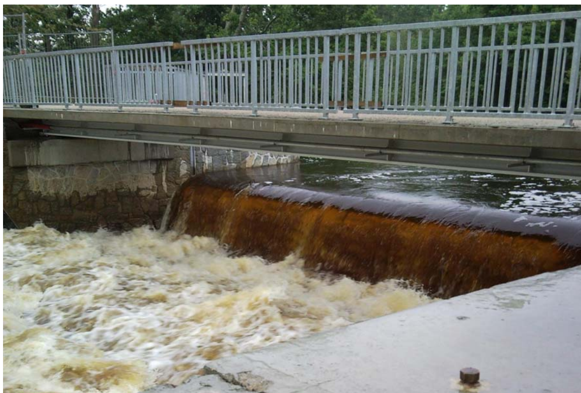
Obr. 1 – Nevladatelný přepad vody do Staré řeky přes provizorní hrazení jezového pole Splav, 29.6.2009
