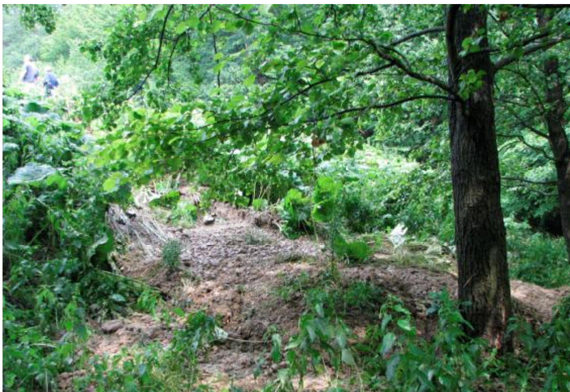
Obr. 2 – Erozní rýha na vzdušném svahu
