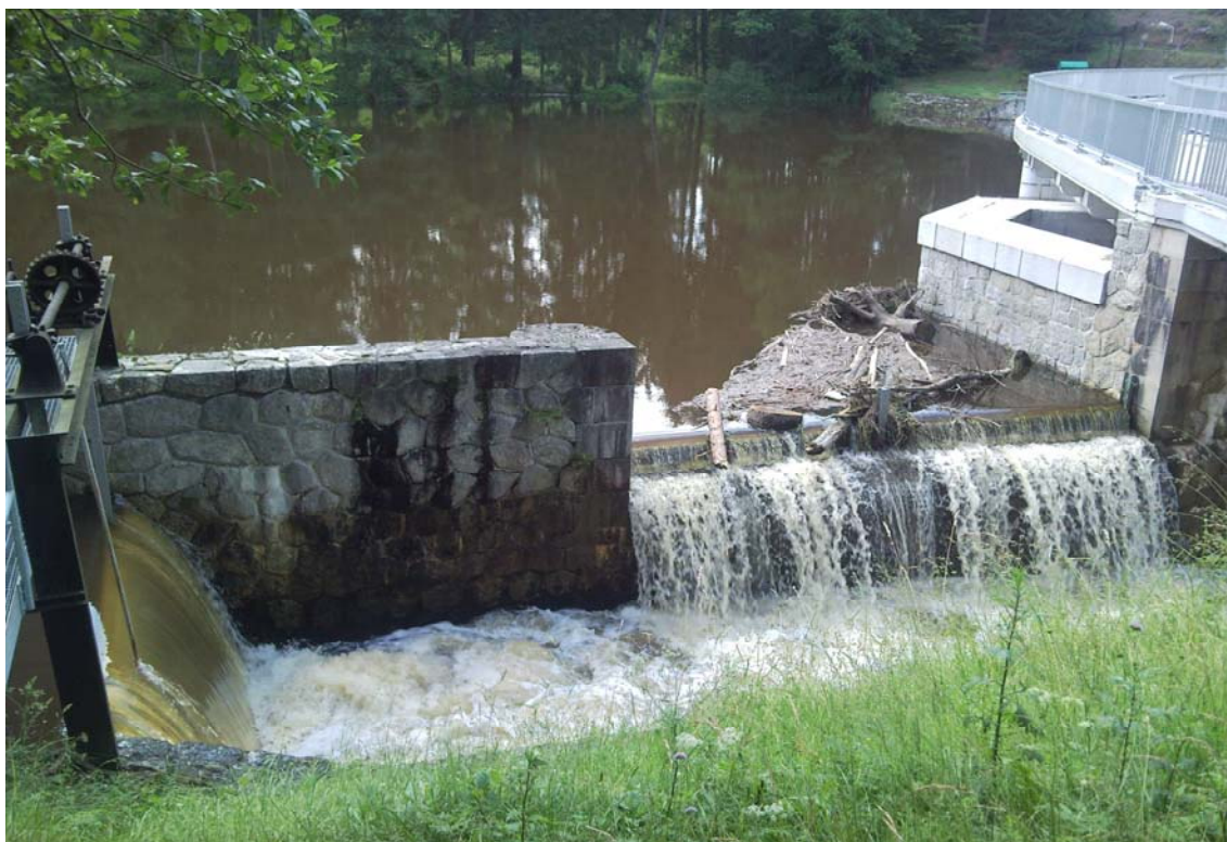
Obr. 2 - Pohled na boční bezpečnostní přeliv, přepad do vorové propusti.
