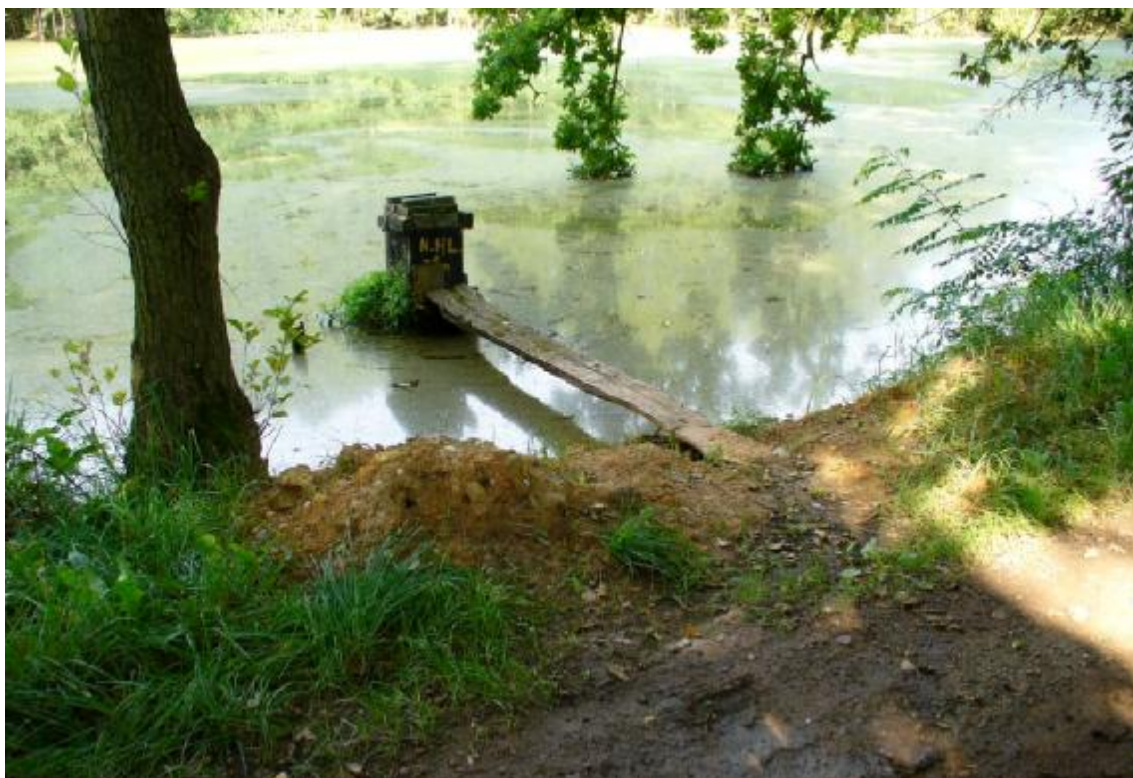
Obr. 1 – Opravená porucha na návodním svahu v profilu spodní výpusti
