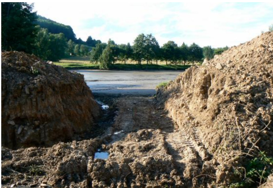
Obr. 4 – Konečný tvar překopu v levém zavázání tělesa hráze
