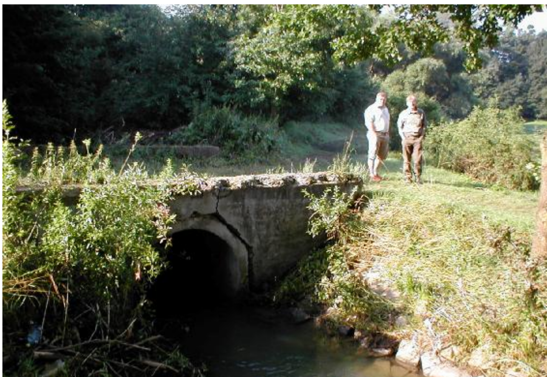
Obr. 4 – Nekapacitní propustek na Roš'ovici
