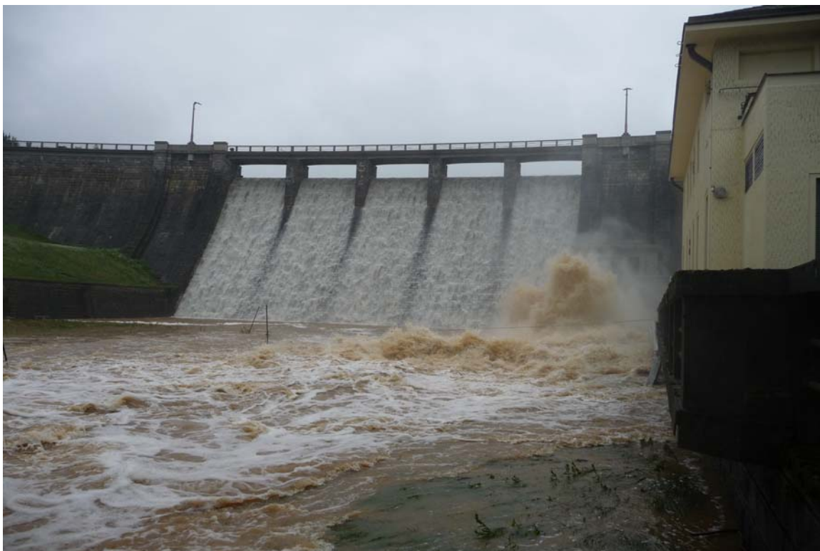
Obr. 3 – Pohled na bezpečnostní přeliv ve funkci, vpravo výtok od spodní výpusti.
