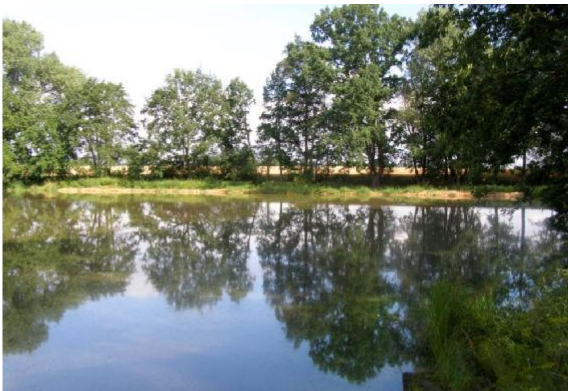
Obr. 3 – Opravená část přelévané boční hráze
