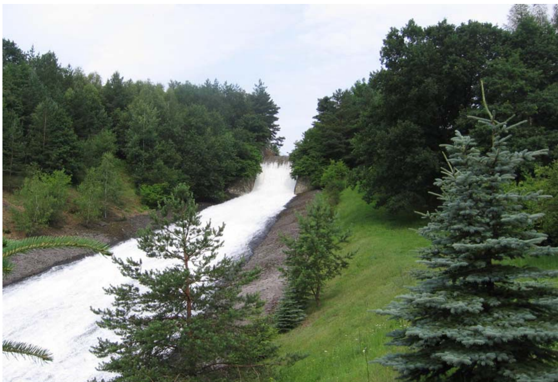
Obr. 2 - Skluz pod „skokanským můstkem“ před napojením do řeky Oslavy, Q = 2 \text{ m}^3 \cdot \text{s}^{-1}
