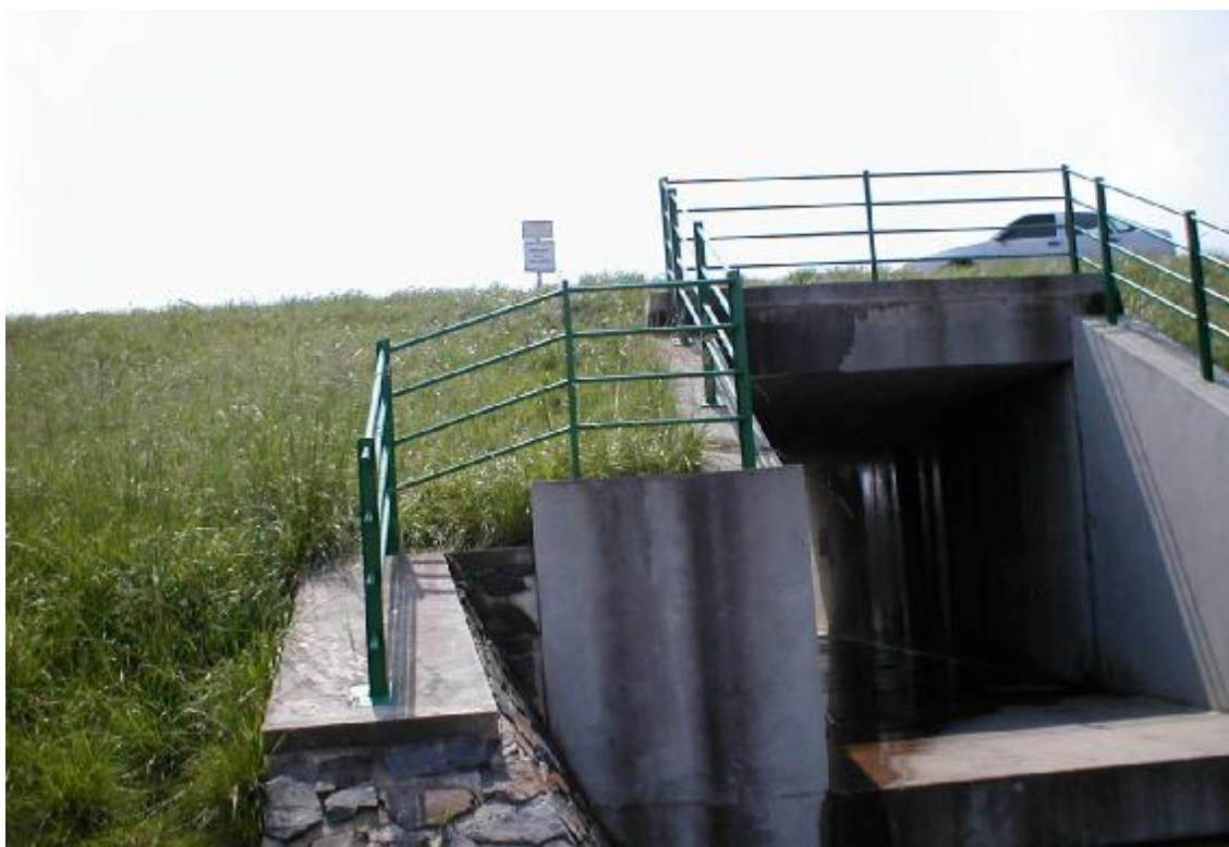
Obr. 4 – Pohled na vzdušnou stranu bezpečnostního přelivu
