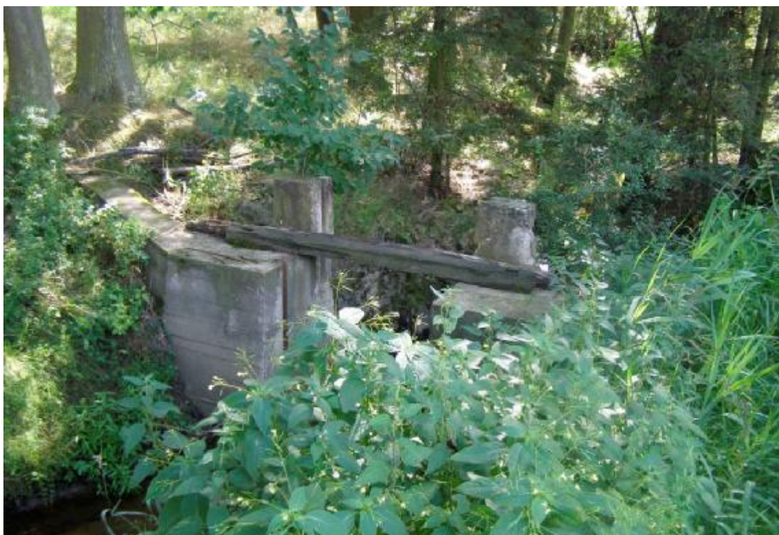
Obr. 2 – Vzdouvací objekt v korytě obtoku v úrovni hlavní hráze
