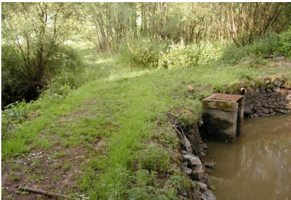
Obr. 3 – Požerák spodní výpusti a trubní přeliv
