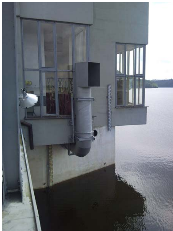
Obr. 3 – Vyvedení zavzdušňovacích otvorů nad max. hladinu a prodloužení vodočetné latě
