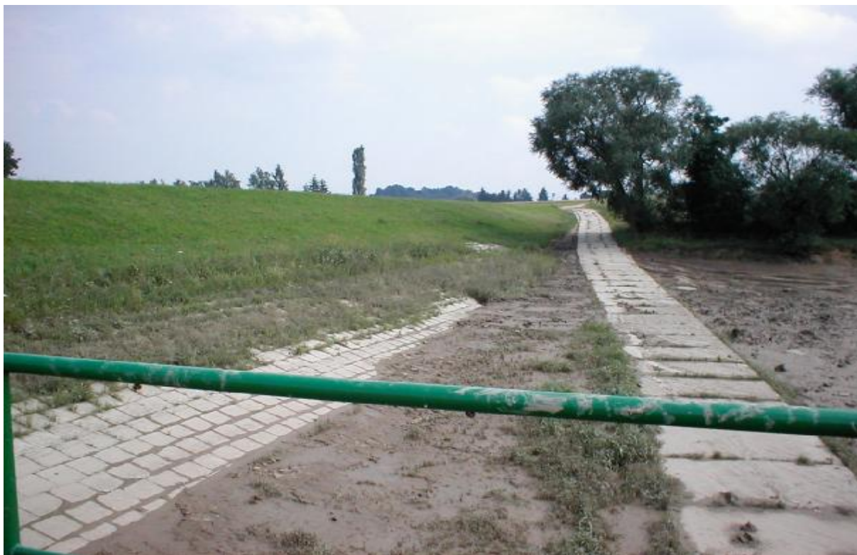
Obr. 3 – Návodní svah – úroveň hladiny při povodni
