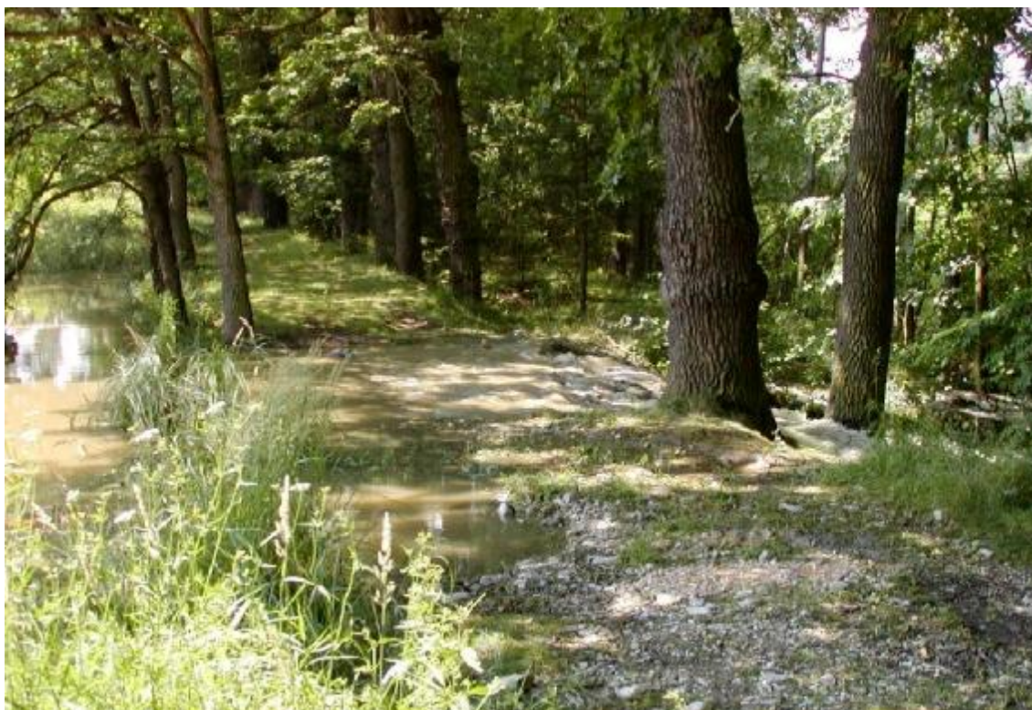
Obr. 1 – Pohled na korunu hráze v profilu spodní výpusti při povodni
