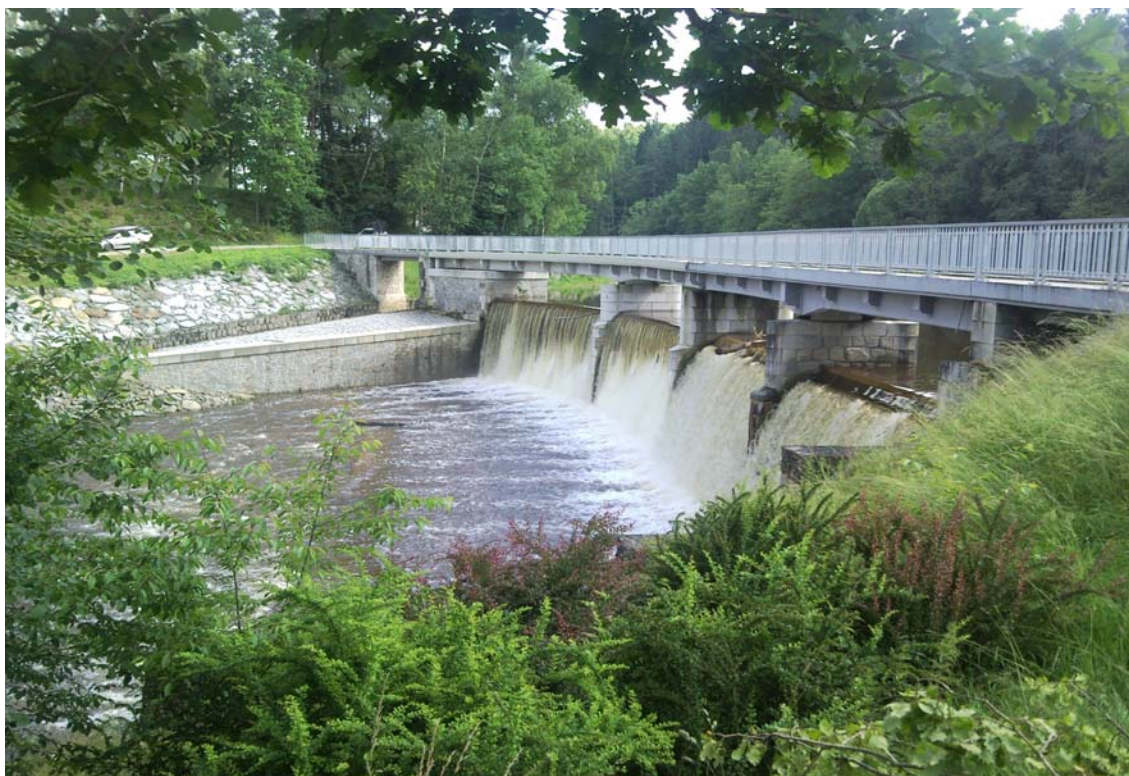
Obr. 4 - Pohled k levému břehu přes vodní dílo (od pravého břehu: vorová propust, čtyři pole přelivů, boční zeď štěrkové propusti).
