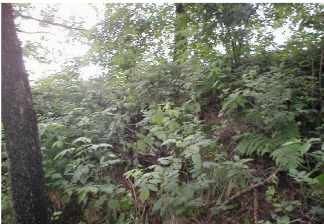
Obr. 4 – Vzdušný svah po přelévání
