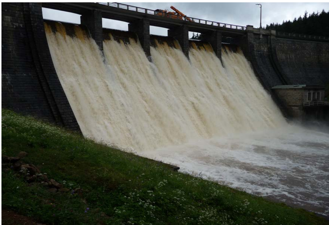
Obr. 2 – Pohled na bezpečnostní přeliv ve funkci, Q = 45 \text{ m}^3 \cdot \text{s}^{-1} .
