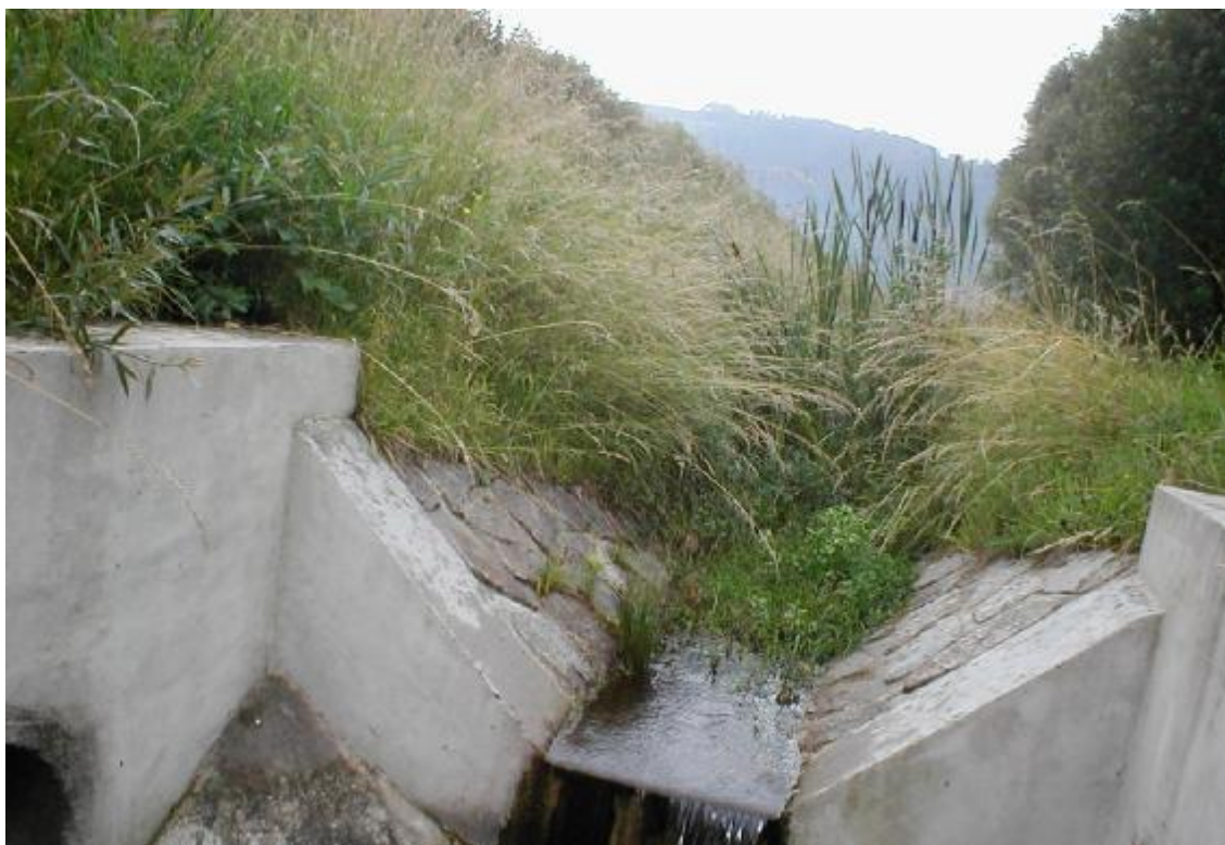
Obr. 3 – Odvodňovací příkop a spodní výpust
