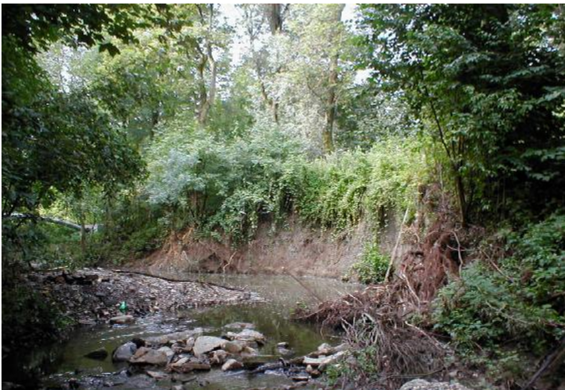
Obr. 4 – Erodivaný břeh toku pod hrází
