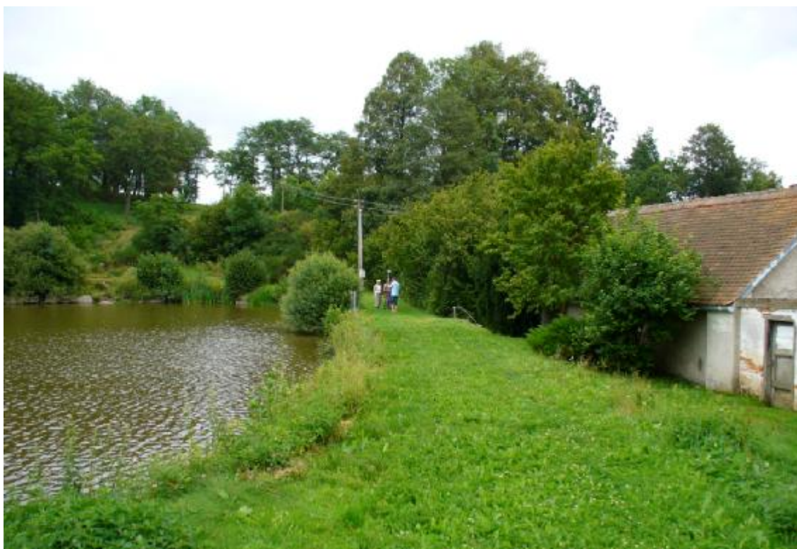
Obr. 2 – Pohled na korunu hráze
