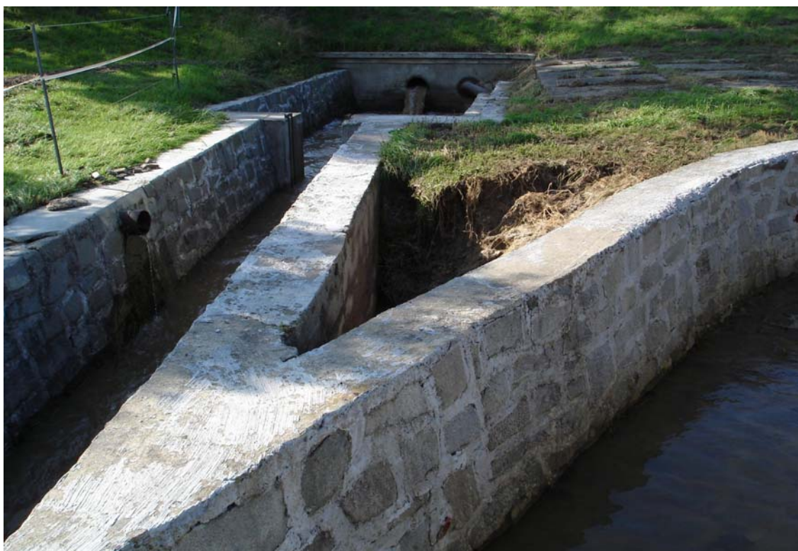
Obr. 2 - Soutok koryta od spodní výpusti se skluzem od přelivu, uprostřed kaverna
