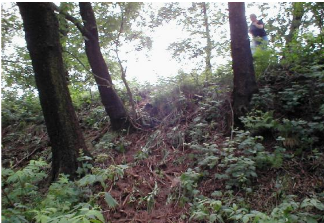
Obr. 3 – Vzdušný svah po přelévání
