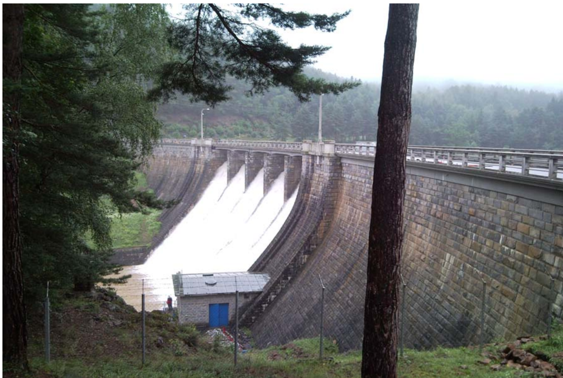
Obr. 1 – Boční pohled na hráz, bezpečnostní přeliv, přemostění, komunikace na koruně hráze.
