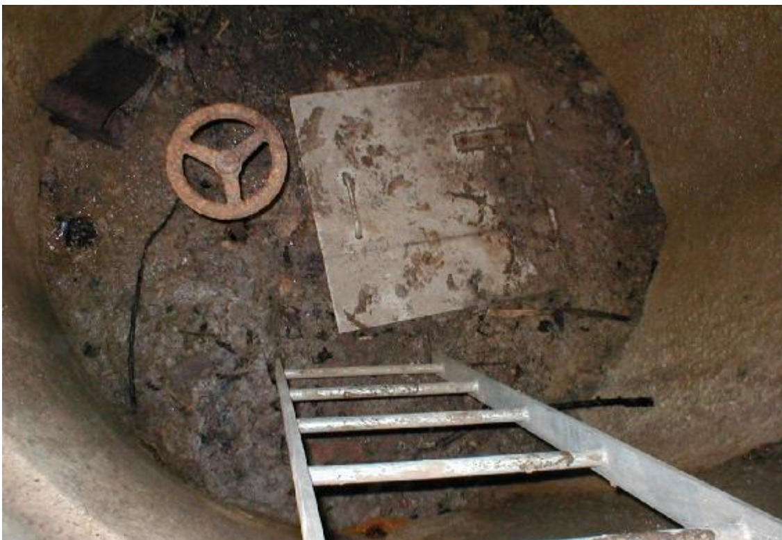
Obr. 4 – Sesuvem posunutá šachta spodních výpustí
