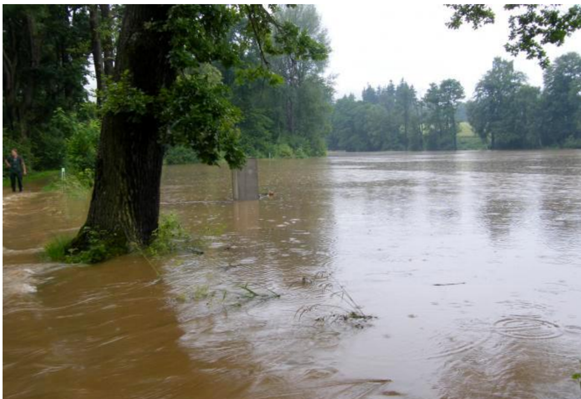
Obr. 4 – Pohled na plnou nádrž od levého konce hráze a přelévání koruny hráze v místě spodní výpusti
