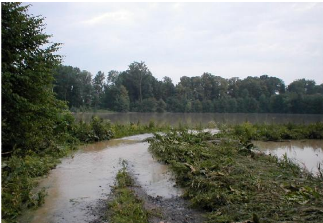
Obr. 1 – Přelévání hráz při povodni po kulminaci průtoků v Luze
