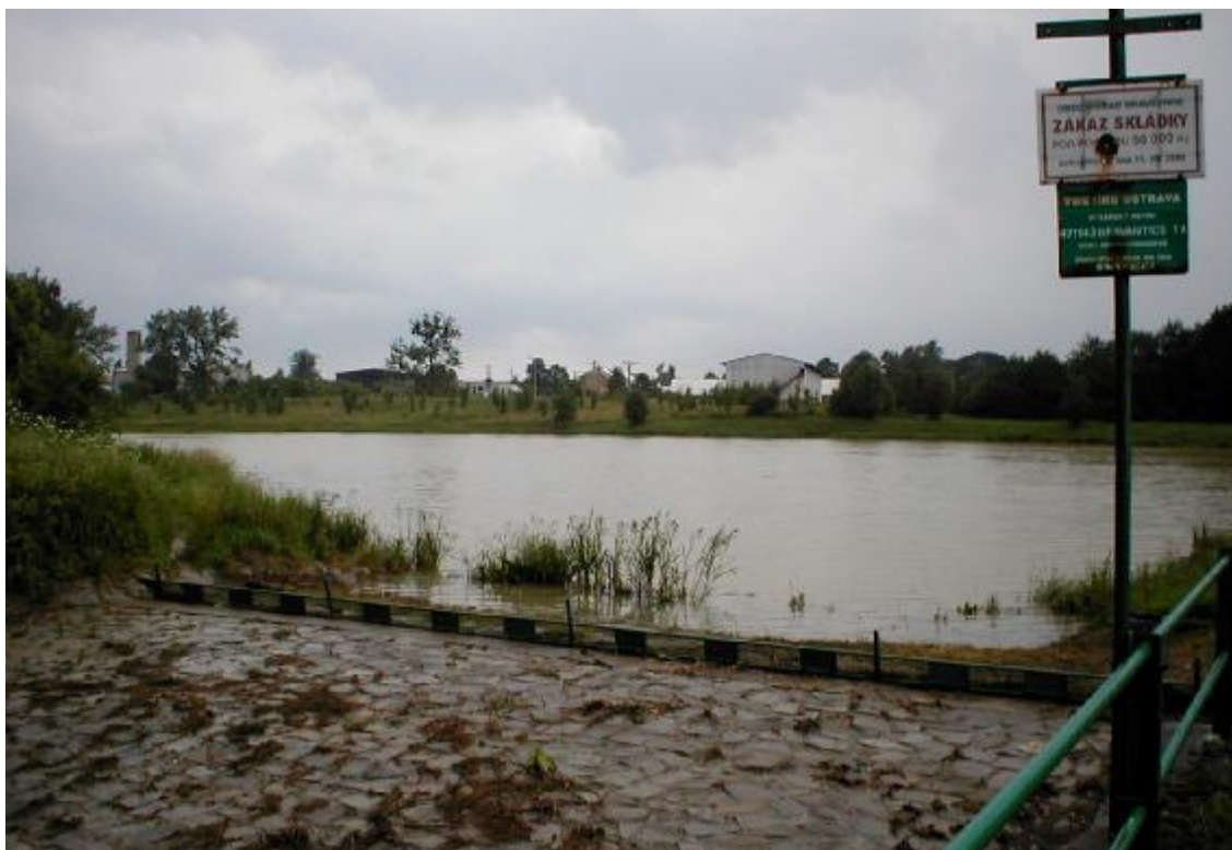
Obr. 1 – Bezpečnostní přeliv
