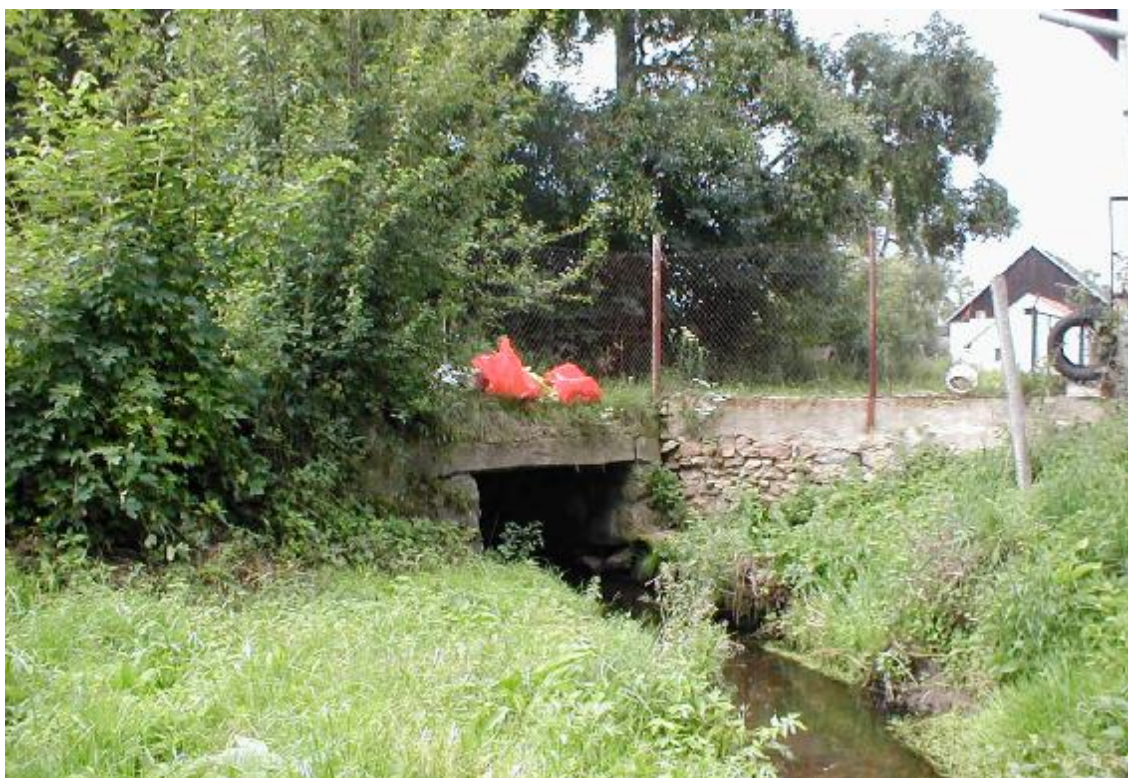
Obr. 4 – Nekapacitní most pod vodním dílem
