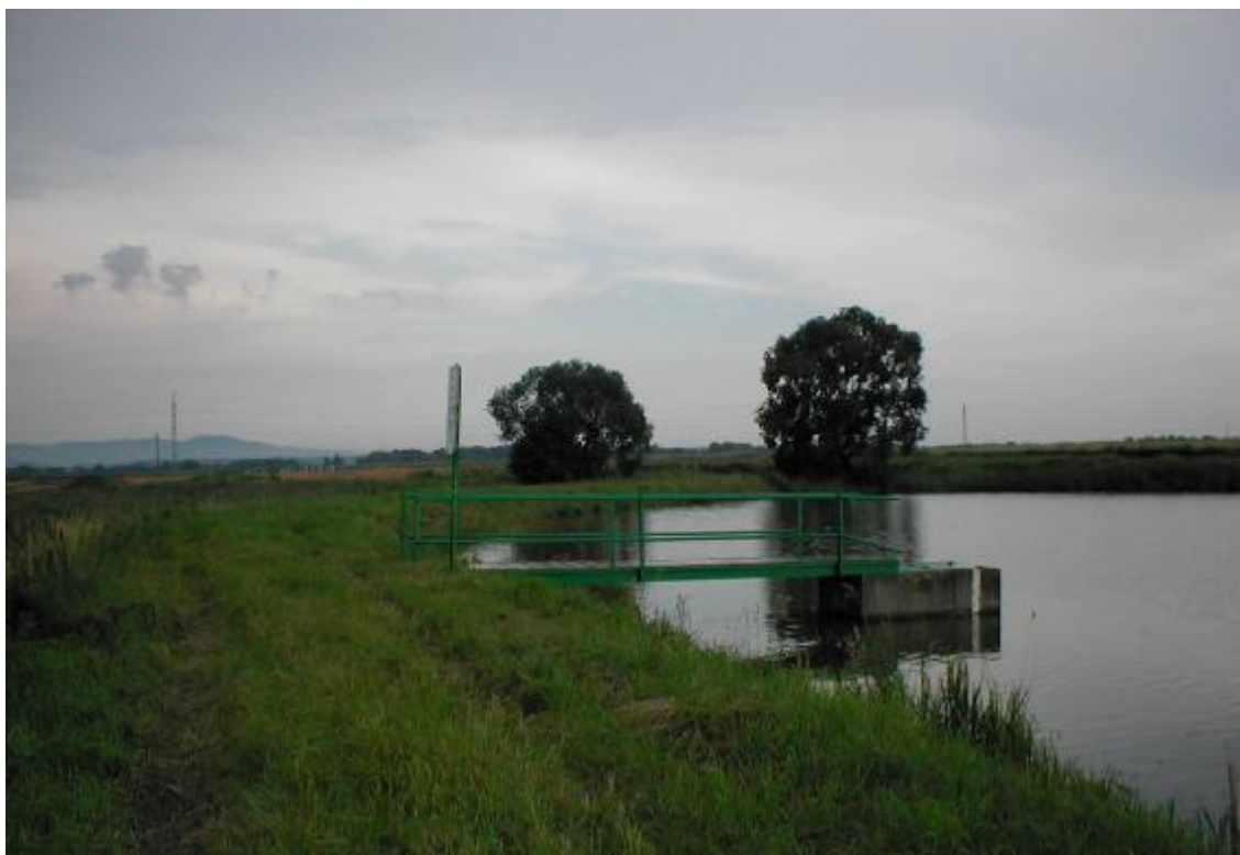
Obr. 1 – Pohled na hráz a spodní výpust
