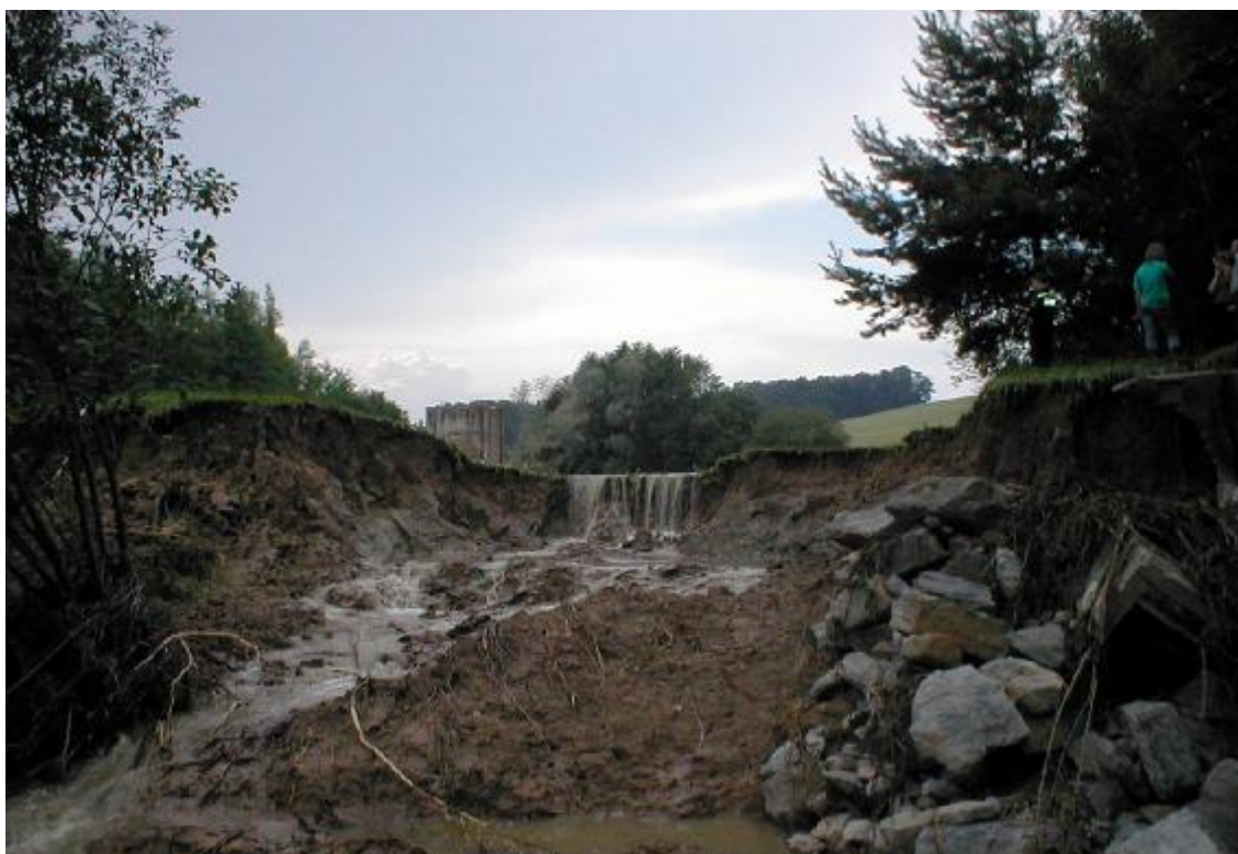
Obr. 2 – Pohled na protrženou hráz
