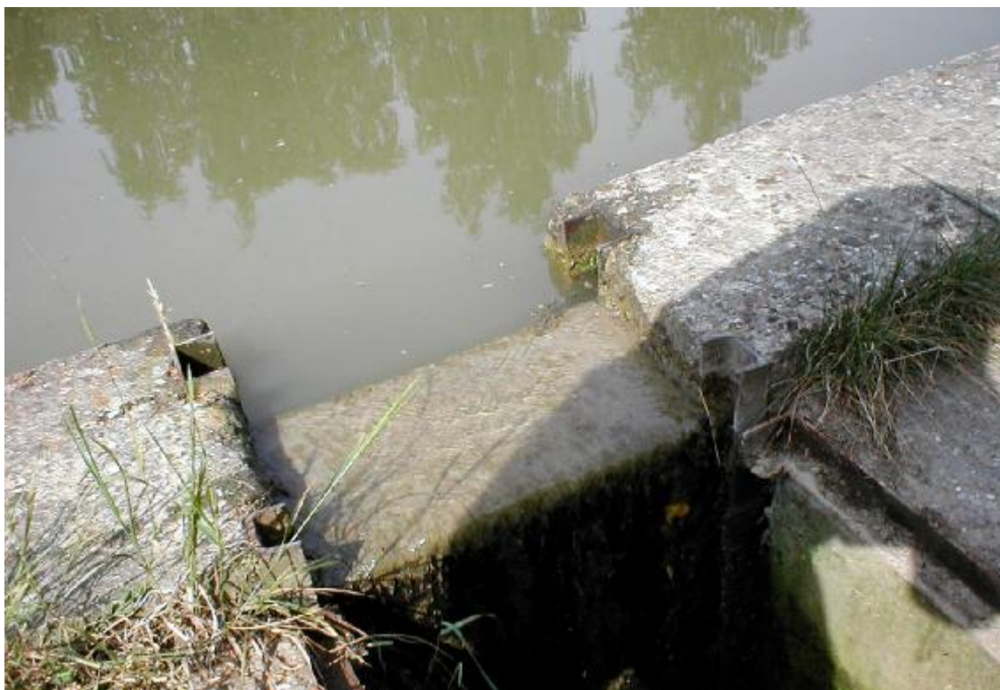
Obr. 3 – Zabetonované drážky dluží
