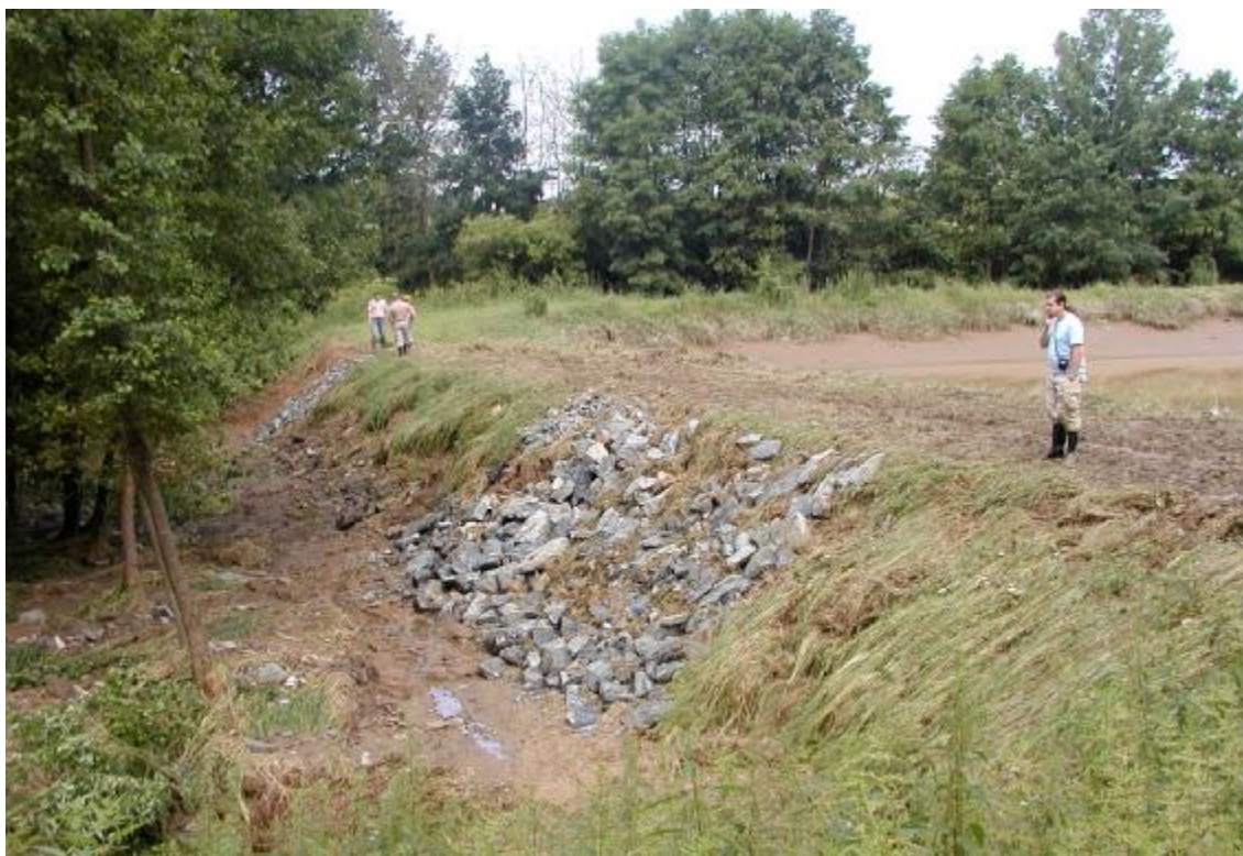
Obr. 1 – Provizorně opravená vzdušná část hráze rybníka v Bohunicích
