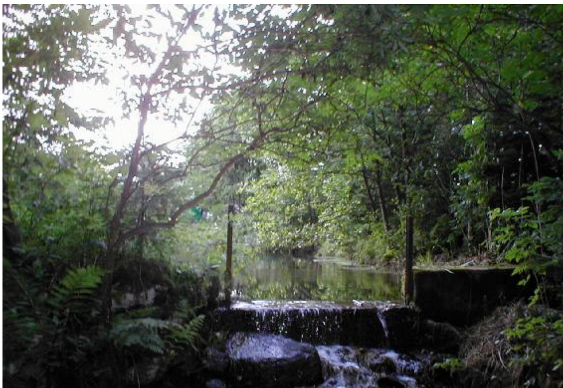
Obr. 3 – Bezpečnostní přeliv
