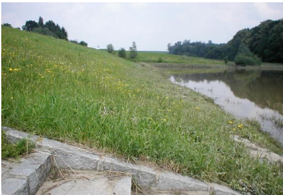
Obr. 2 – Úroveň hladiny vody při povodni
