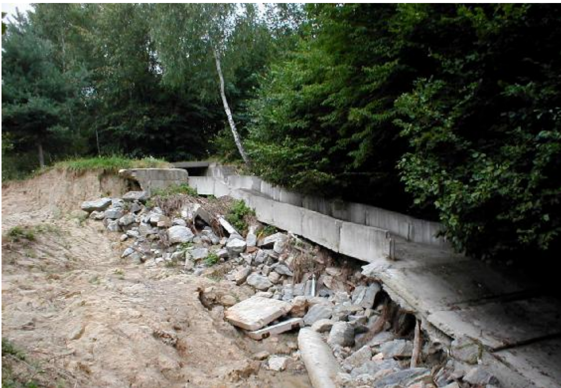
Obr. 3 – Skluz od přelivu
