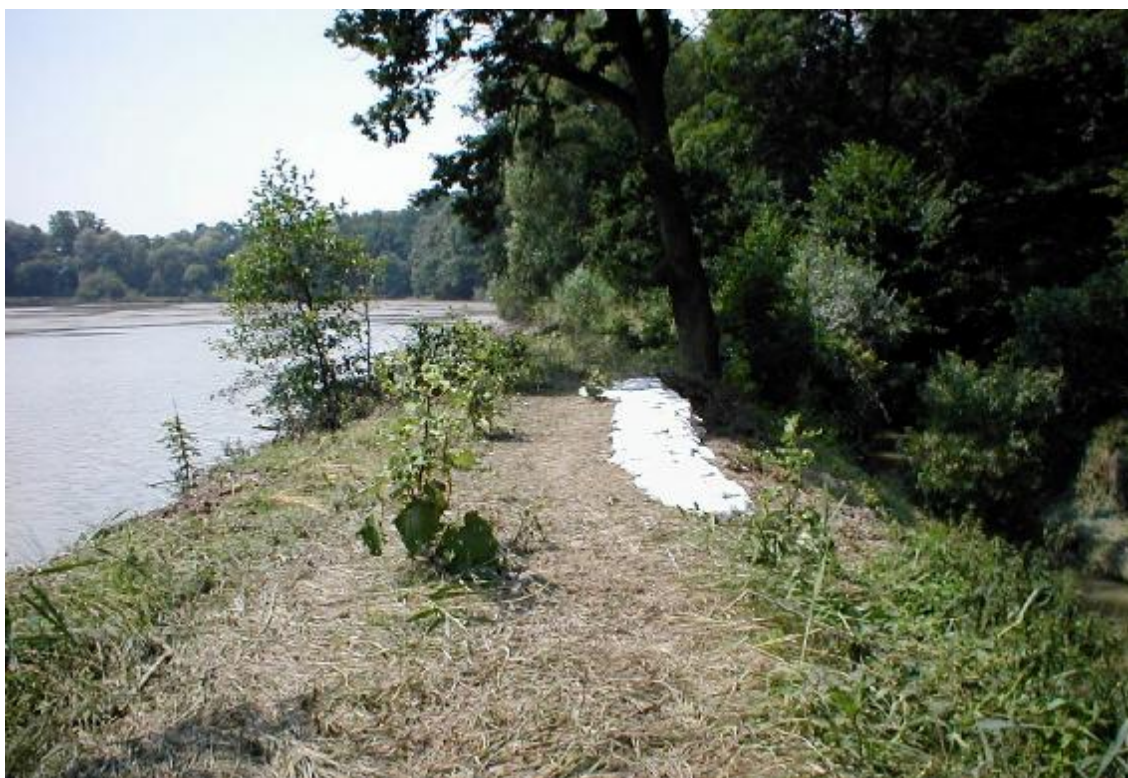
Obr. 2 – Přeléváná část hráze
