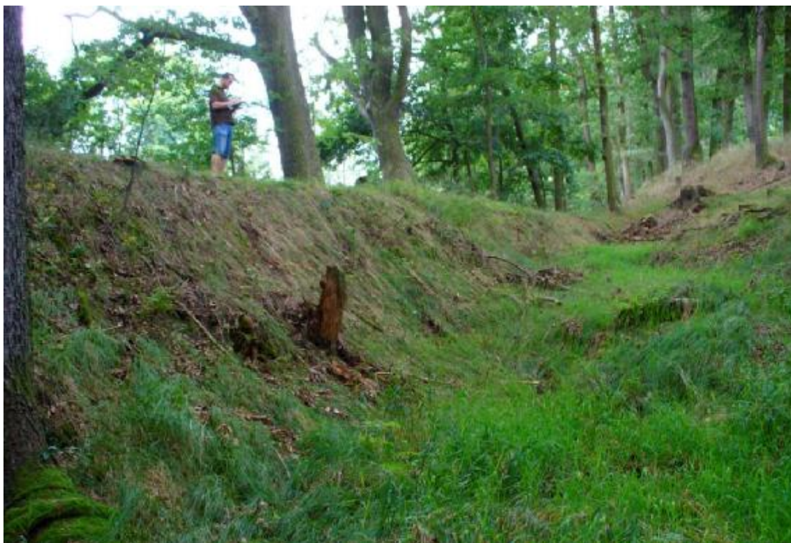
Obr. 1 – Místo přelévání koruny hráze v levém zavázání
