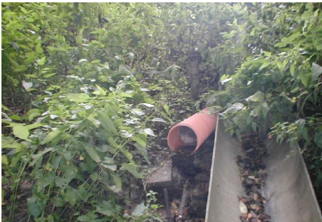
Obr. 3 – Spodní výpust – ucpaná zátkou
