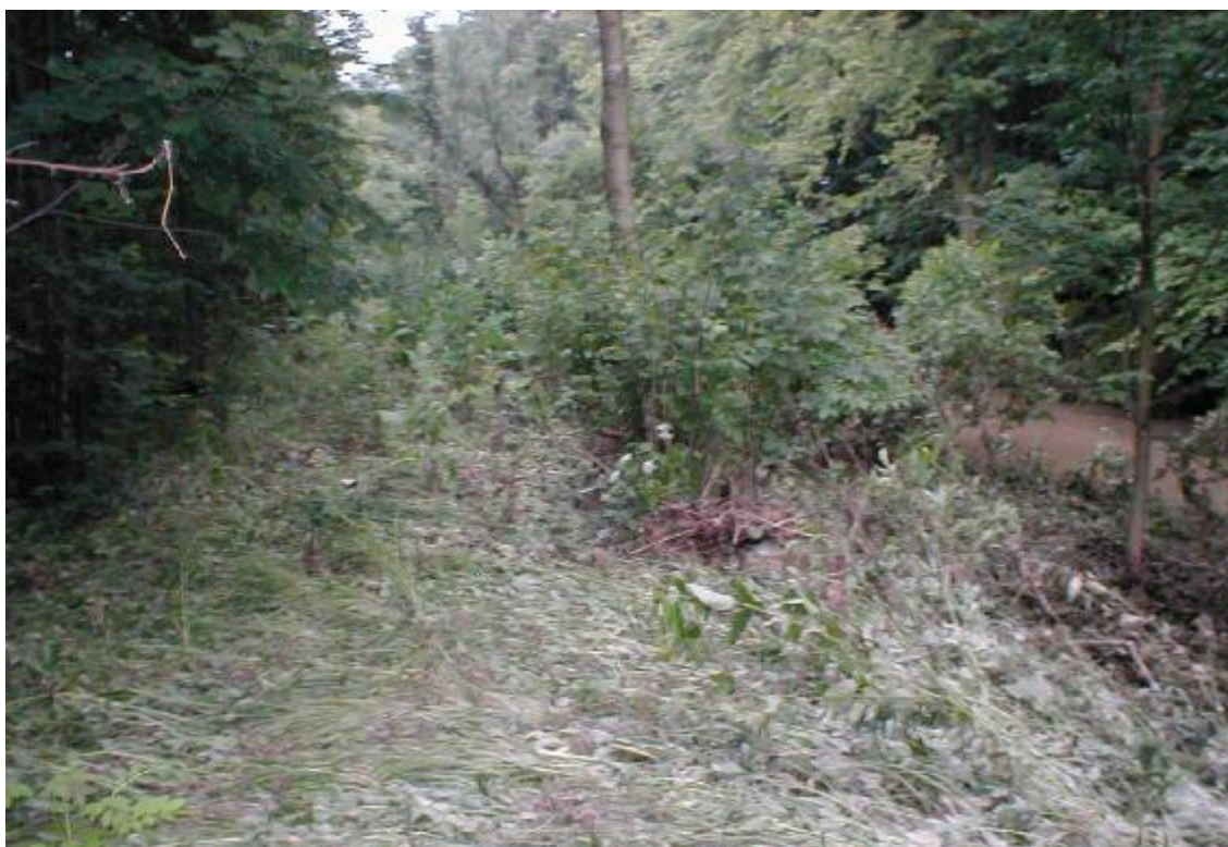
Obr. 2 – Hráz přelévaná v době kulminace v Luze do nádrže
