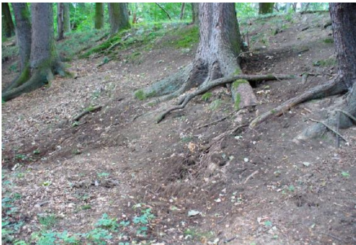
Obr. 3 – Obnažený kořenový systém ve střední části vzdušního svahu
