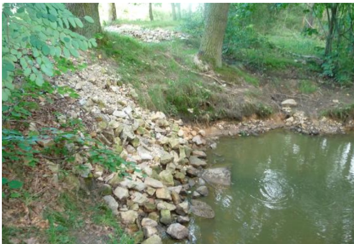
Obr. 4 – Pohled na sanovaná místa vzdušného svahu hráze v profilu výpusti
