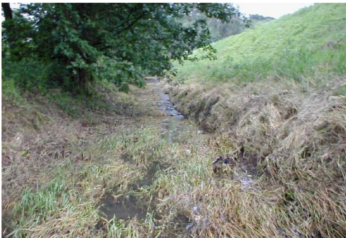
Obr. 2 – Odpadní koryto od přelivu – voda z průsaku
