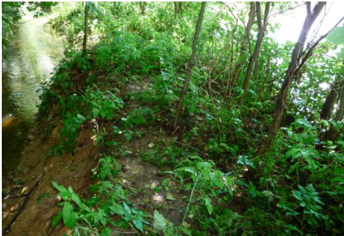
Obr. 4 – Stav, vegetace a poškození boční (dělicí) hráze mezi rybníkem a potokem Blatnice po povodni
