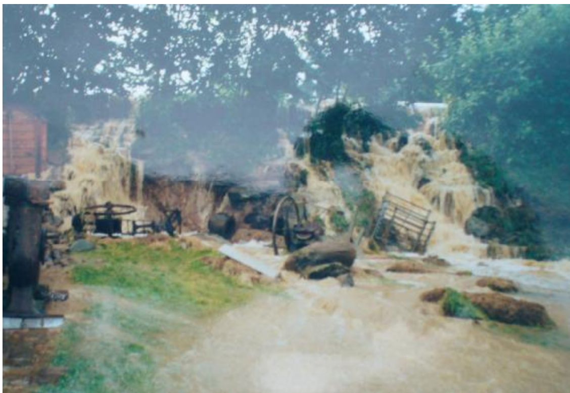
Obr. 3 – Pohled na hráz v profilu spodní výpusti proti vodě za povodně
