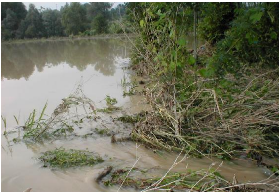
Obr. 3 – Přeléváná hráz při povodni po kulminaci v Luze
