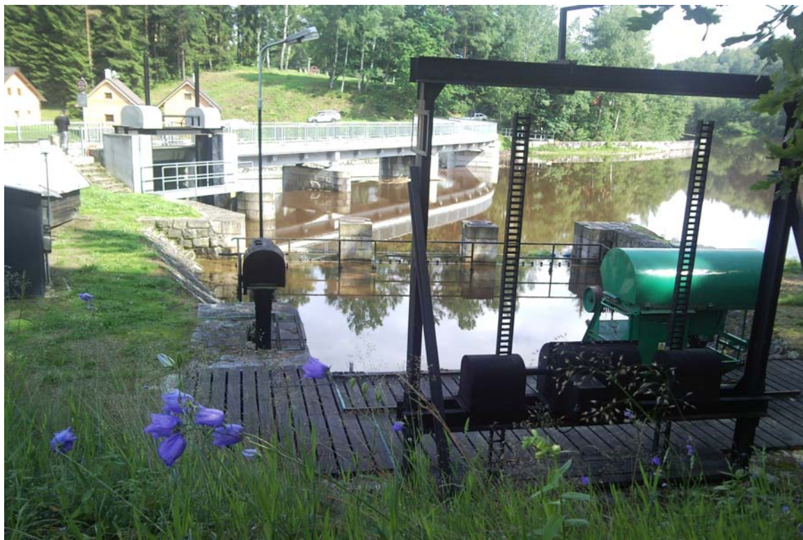
Obr. 3 – Pohled na návodní líc, vlevo konstrukce hrazení štěrkové propusti, v popředí odběrný objekt pro MVE s ovládacím zařízením.
