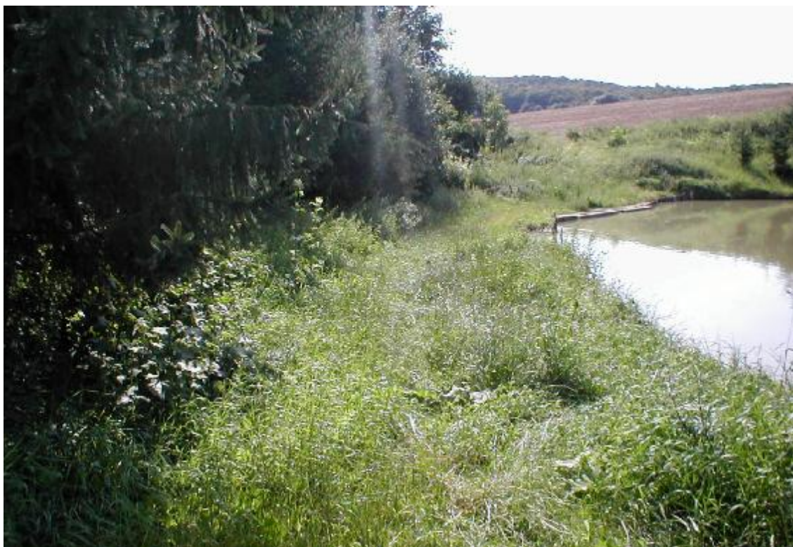
Obr. 1 – Pohled na hráz
