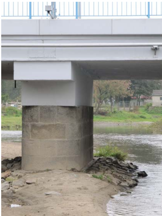
Obr. 7.5 – Příklady nevhodného umístění hladinového čidla
