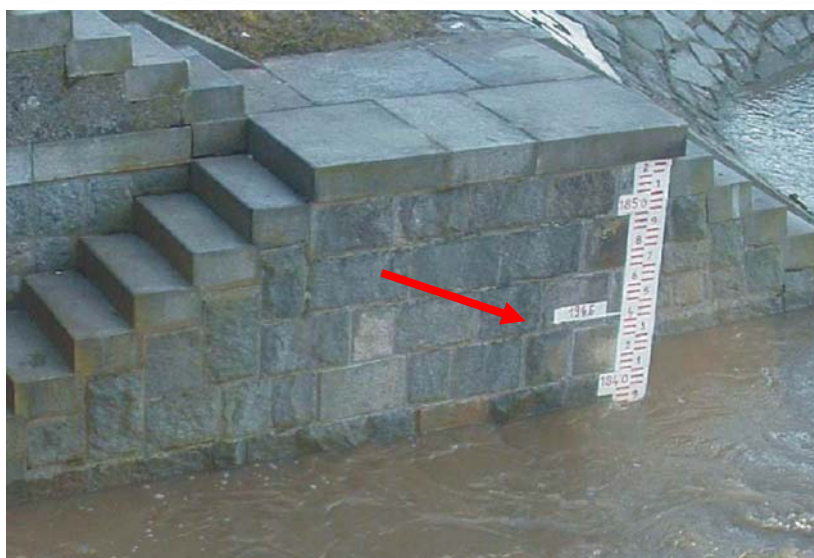
Obr. 21 Nymburk, středa 29. března 2006. Labe pod soutokem s Mrlinou stoupá, z povodňových značek zůstává nad hladinou pouze poslední – značka povodně z roku 1946. Foto: Elleder, L.
