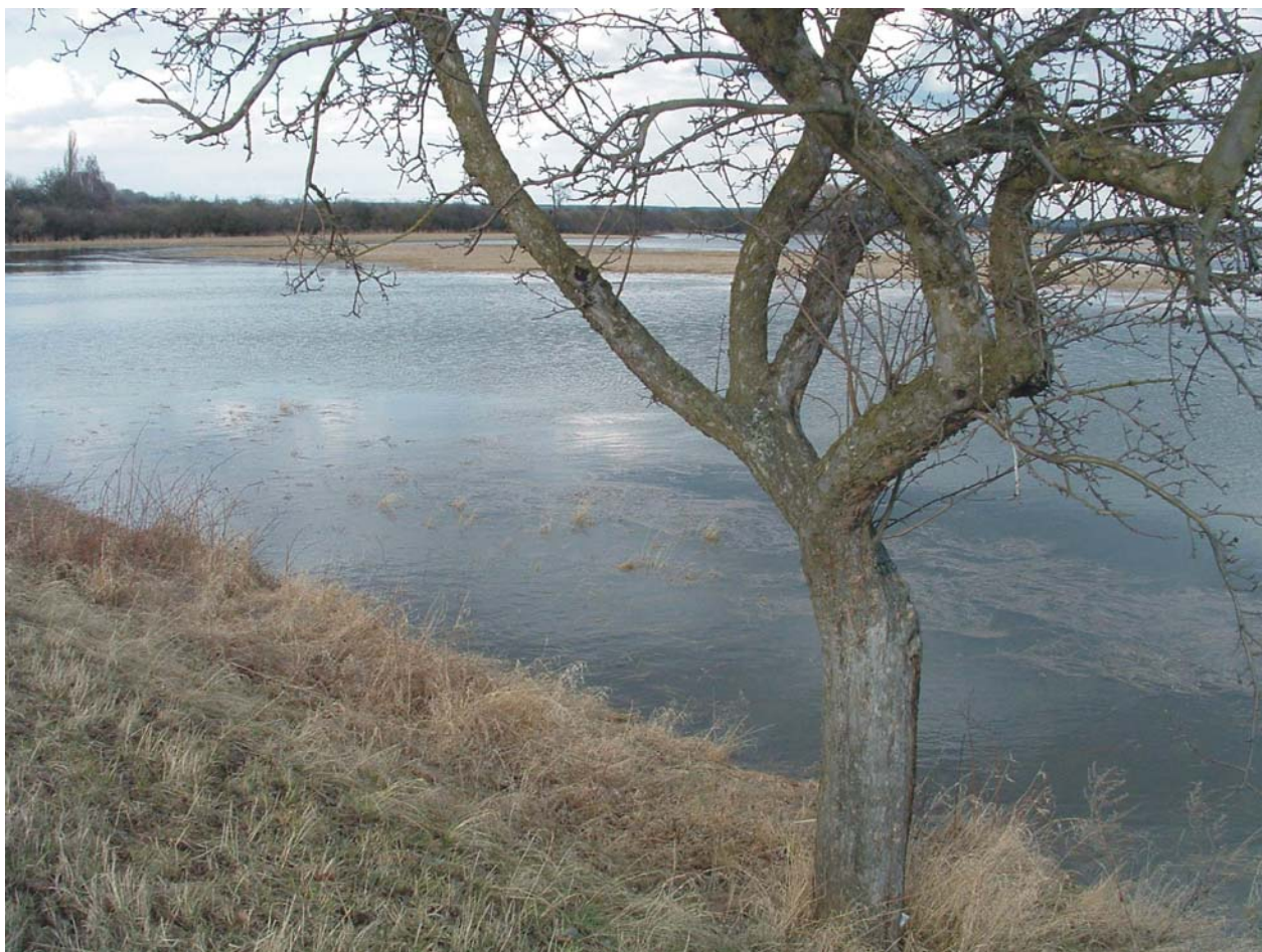
Obr. 19 Vestec, Mrlina, 29. března 2006. Rozlivy mimo ochranné hráze se realizovaly často do oblasti zrušených rybníků, součásti dříve významné rybníční soustavy na Nymbursku. Foto: Elleder, L.
