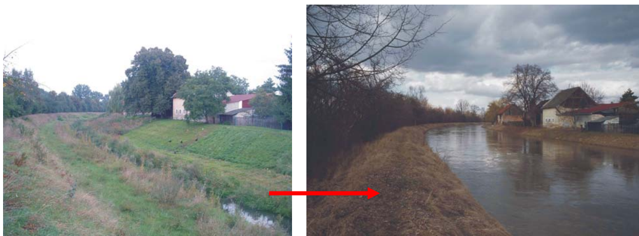
Obr. 20 Mrlina – Rašovice (úsek pod Vestcem). Pohled proti vodě, srovnání profilu za „normálního stavu“ a v průběhu povodně 29. března 2006. Mrlina teče v ochranných hrázích již nad úroveň terénu na pravém břehu. Foto: Elleder, L.
