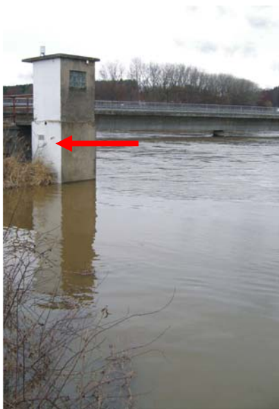
Obr. 42 Lužnice, Klenovice, 30. března 2006. Hladina dosáhla úrovně Q_{50} , srovnání s výškou z roku 2002 umožňuje povodňová značka (šipka). Foto: Hovorka, P. Rozlivy (vpravo) mezi Soběslaví a Klánovicemi (umístění stanice je mimo snímek, směr ukazuje šipka). Foto: Raudenský, M.
