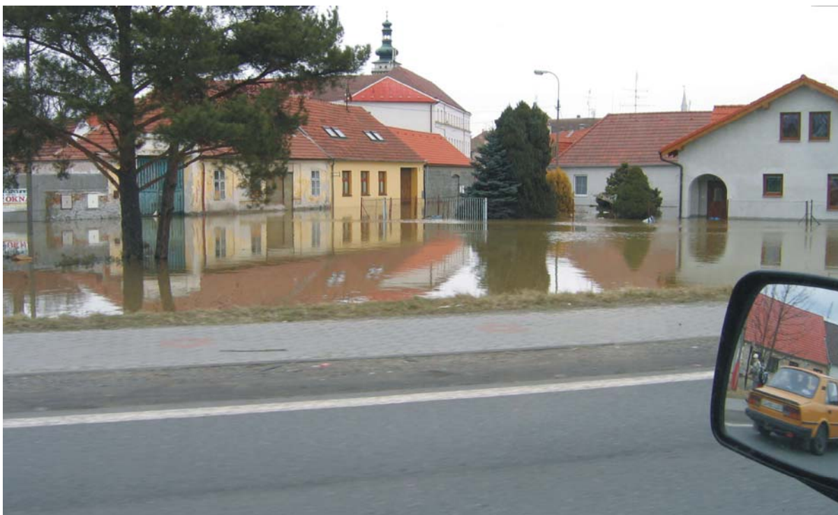
Obr. 41 Soběslav, 30. března 2006. Průjezd zatopenou částí města. Foto: Hovorka, P.
