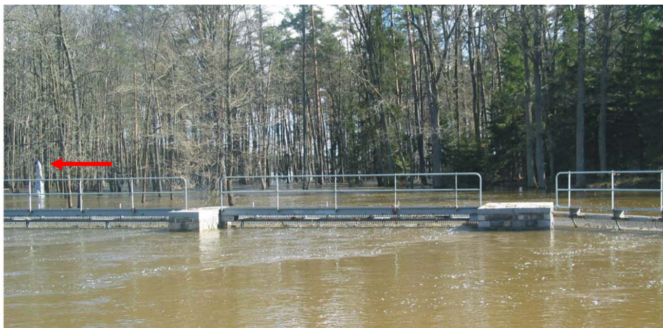
Obr. 38 Lužnice pod Rožmberkem 30. března 2006. Česlová stěna bezpečnostního odtoku z Rožmberka, povodňový sloup (šipka). Foto: Hovorka, P.
