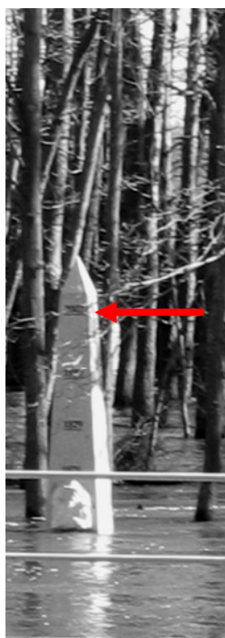
Obr. 37 Lužnice pod Rožmberkem 30. března 2006. Po povodni 2002 obnovený „povodňový sloup“. Úrovně historických povodní zde zachycených jsou odshora: 2002 (šipka), 1890, 1829 a 1876, (viz též dole). Foto: Hovorka, P. Letecký pohled (vpravo) na hráz o 3 dny později v neděli 2. dubna (poloha sloupu vpravo mimo obrázek ve směru šipky). Foto: Raudenský, M.
