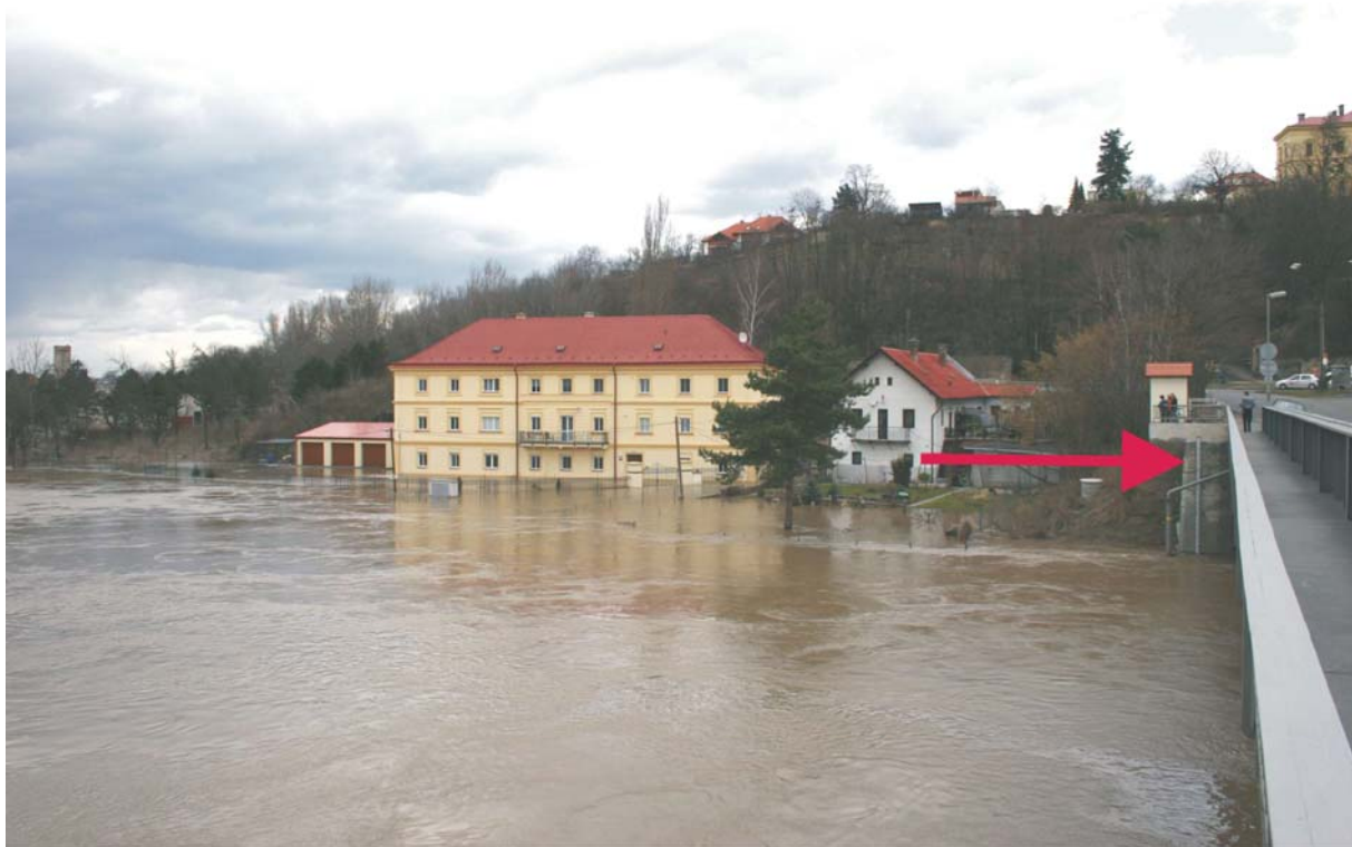
Obr. 72 Mělník, 3. března 2006. Doba kulminace, profil nové stanice, postavené po povodni 2002; šipka ukazuje na značku povodně 2002 (též Obr. 70 ). Foto: Kurka, D.
