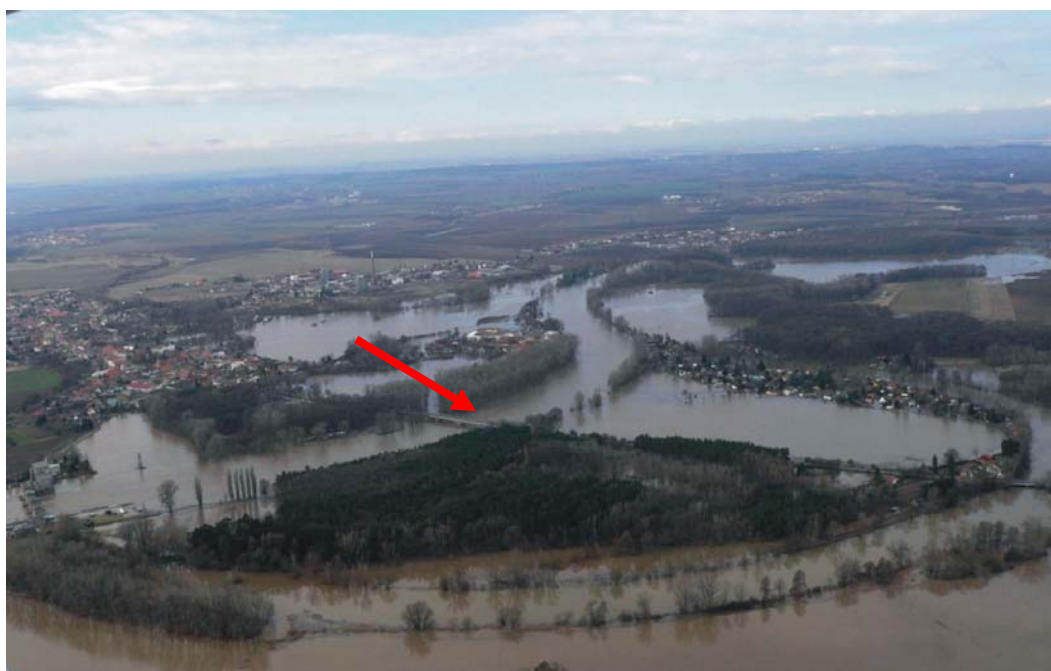
Obr. 35 Kostelec nad Labem – Labe, neděle 2. dubna 2006 večer. Snímek zachycuje jez a elektrárnu (vlevo), město a mohutný meandr původního Labe zčásti lemovaný zatopenými chatovými osadami. Polohu stanice ČHMÚ označuje šipka. Foto: Raudenský, M.
