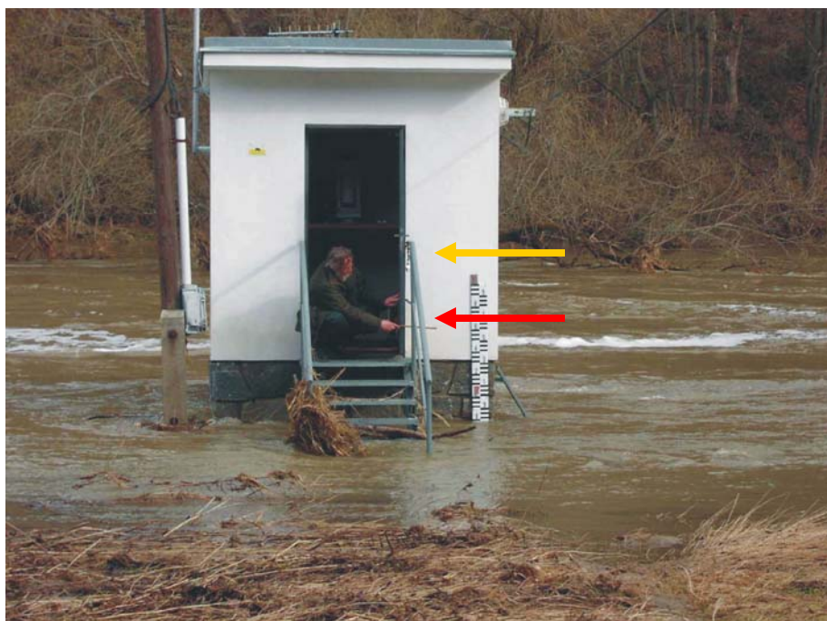
Obr 87 Dyje, Podhradí, 31. března 2006. Dvě významné kulminace dosažené v roce 2006: 30. března 472 cm (výšku ukazuje pracovník ČHMÚ a zároveň červená šipka) a 30. června 534 cm (žlutá šipka). Uroveň vody za kulminace v březnu 2006 byla tedy nečekaně vysoce překonána již za 3 měsíce. Foto: Lejska, S.
