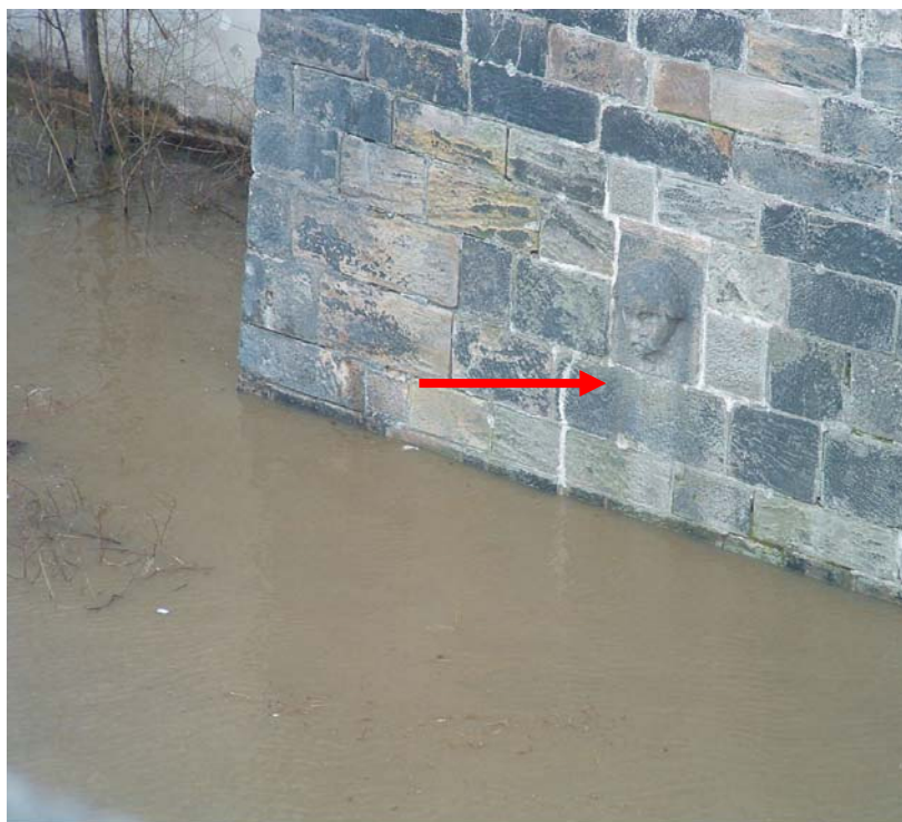
Obr. 64 Vltava, Praha, čtvrtek 30. března 2006. Povodeň v Praze nebyla ani ve vztahu k historickému vodočtu „Bradáci“ příliš významná. Kritickou hranicí bývala totiž spodní část plastiky. Foto: Elleder, L.
