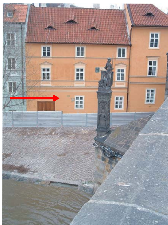
Obr. 65 Vltava, Praha – Kampa. Srovnání situace ze 14. srpna 2002 a ve čtvrtek 30. března 2006. Bariéry byly postaveny, ale vodní stav zůstal tentokrát pod úrovní 3. SPA. Povodňové značky ukazují úrovně hladin v letech 2002, 1784, 1845 a 1890. Foto: Elleder, L.
