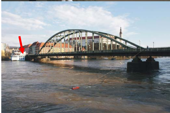
Obr. 77 Děčín, 4. dubna. Mozaika fotografií z měření průtoků v úterý 4. dubna 2006. Zatopená část silnice na levém břehu, měření průtoků s pomocí ADCP a vodočet na pravém břehu (též šipka) za stavu 870 cm, (kulminace dosažena na úrovni 887 cm), Foto: Kurka, D.
