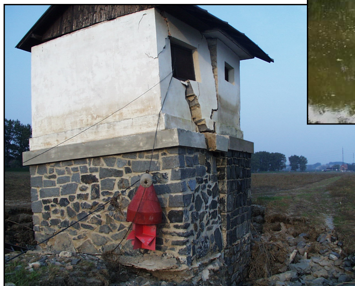
Obr. 6.4 Stanice Ždírec na Úslavě zničená povodní – nahore.
