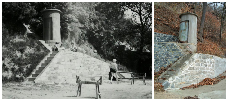
Obr. 11 Mělník, Labe limnigraf zřízený v místě plovárny a loděnice r. 1901 anebo dříve, foto v r. 1925 a 2007. Zdroj: Archiv hydrologické služby ČHMÚ.
