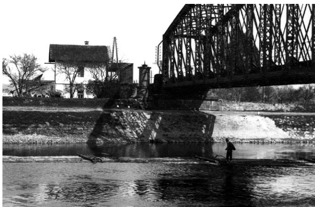
Obr. 12 České Budějovice, železniční domek a železniční most s limnigrafem z r. 1904, snímek kolem r. 1925. Zdroj: Archiv hydrologické služby ČHMÚ.
