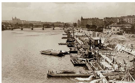
Obr. 8 Výstavba Podskalského nábreží asi v r. 1906. Zdroj: Bečková (2012).
