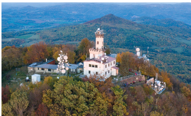
Obr. 1 Pohled na observatoř Milešovka z letadla. Na věži je umístěn radar WR2120. Světlá krabice na zemi v popředí na levé straně obrázku znázorňuje SEVAN a vlevo od něho se nachází radar MIRA 35c.
