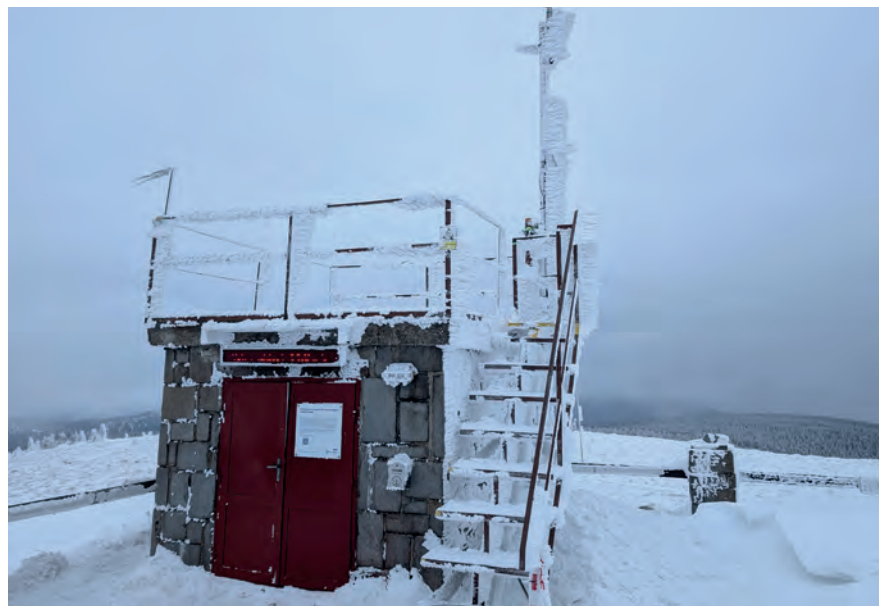
Obr. 5 Garáž na meteorologické zahrádce s měřením směru a rychlosti větru, délkou trvání slunečního svitu, informačním panelem a cedulí. Foto: Veronika Šustková.
