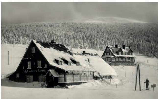
Obr. 3 Erlebachova bouda po přestavbě v roce 1926 ukazuje jiný druh reflexe extrémních klimatických podmínek daného stanoviště. Běžně bývá vchod umístěn na podélné straně domu, zde je však netypicky situován do štítové stěny, a to přímo na návětrné straně. Tato pozice dle zkušenosti vlastníka zajistila, že vchod nebude zavalen sněhem sjíždějícím ze střechy ani zatarasen návějemi, které se naopak hromadily na závětrné straně. Pohlednice ze sbírek Krkonošského muzea Vrchlabí, sign. H 3744.
