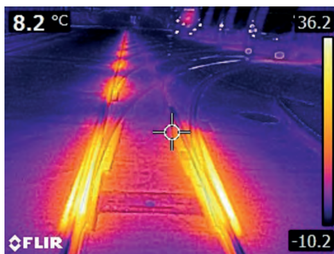
Obr. 2 Termogram tramvajové harfy v depu Krasňany. Zdroj: Vlastní, (W-Technika 2023).
