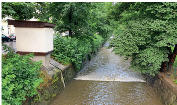
Vodoměrná stanice na Botiči, Praha-Nusle. Foto: archiv ČHMÚ.
