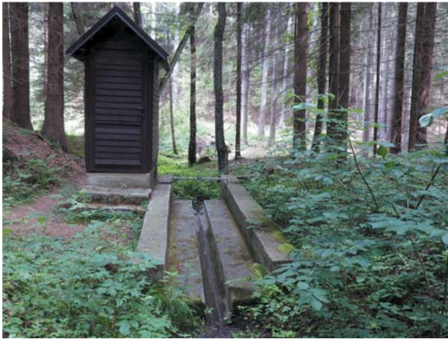
Obr. 5 Hydrologický přepad s ultrazvukovou sondou na lesním potoce.
