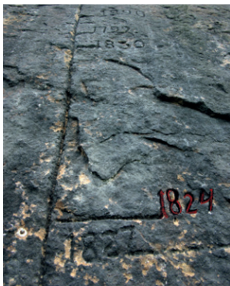
Obr. 4 Značka povodně z roku 1824 v Děčíně. Její výška je zde výrazně nižší než výšky dosažené při povodních v letech 1799 a 1830, zatímco v Praze byl poměr opačný.
